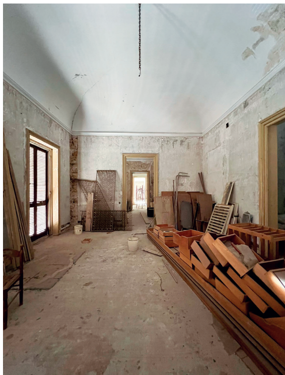
Figura 5.14 - Início de obra, Rappa, Palermo, imagem de Giacchino Munna, 2022
