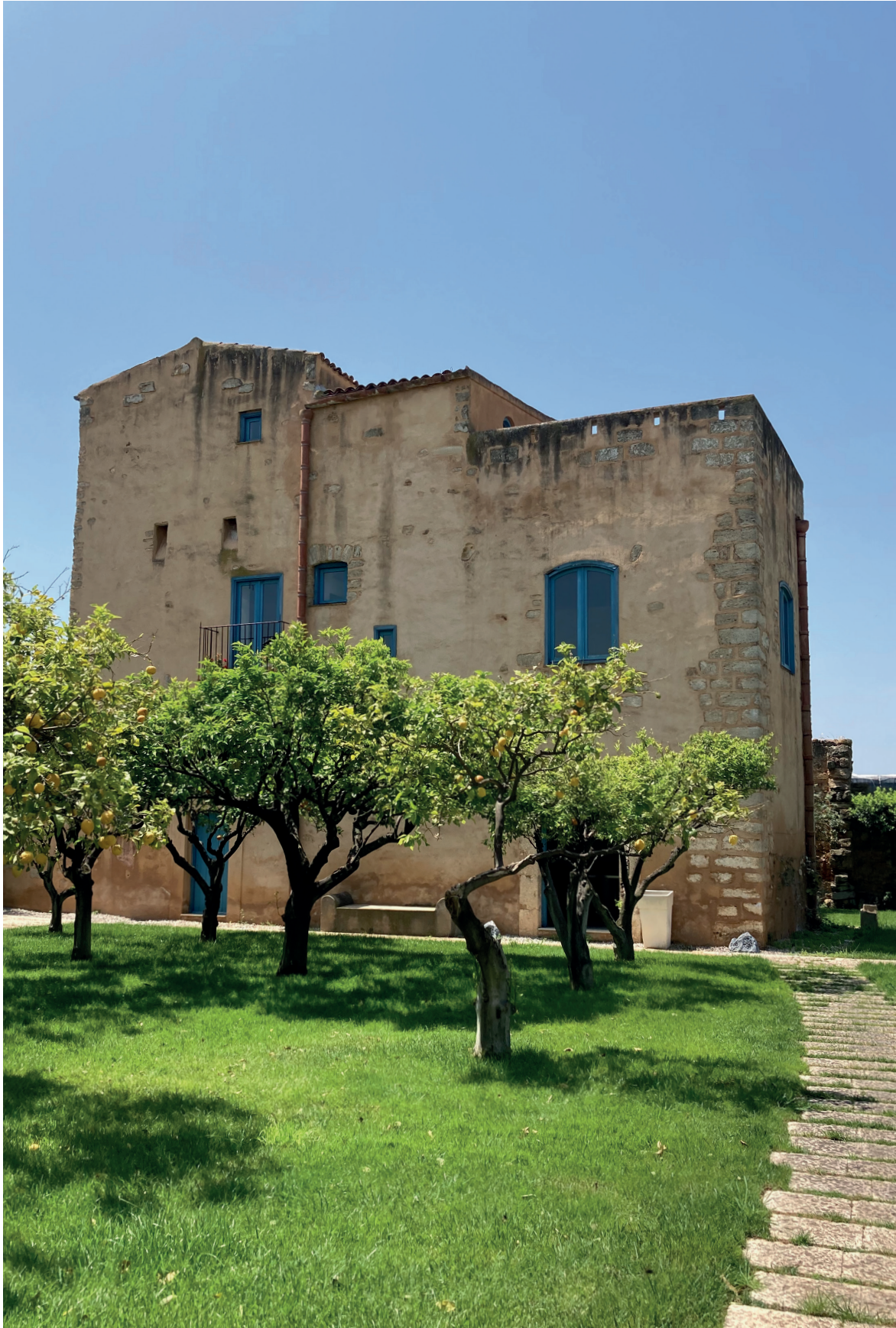
Figura 4.29- Edifício do baglio , Adega Cusumano, Partinico, imagem de Sofia Lemos, 2022
