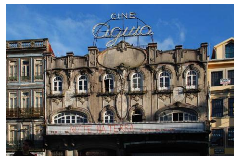
Fig. 32 – fachada antiga do cinema
