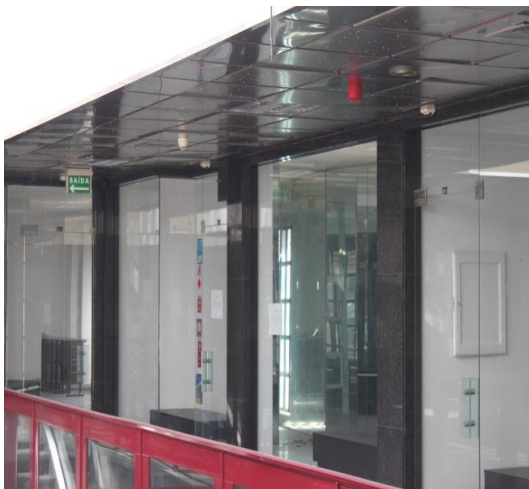
Fig. 52 – Corredor de acesso às lojas
