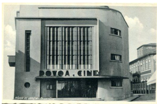
Fig. 67 - Póvoa-Cine – vista exterior
