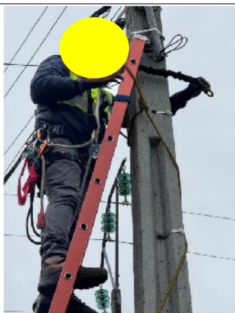
Figura 48 - Posicionamento em altura
