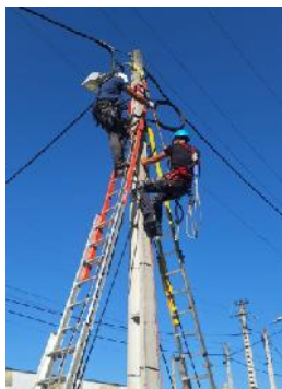
Figura 58 - Preparação para Resgate em Formação
