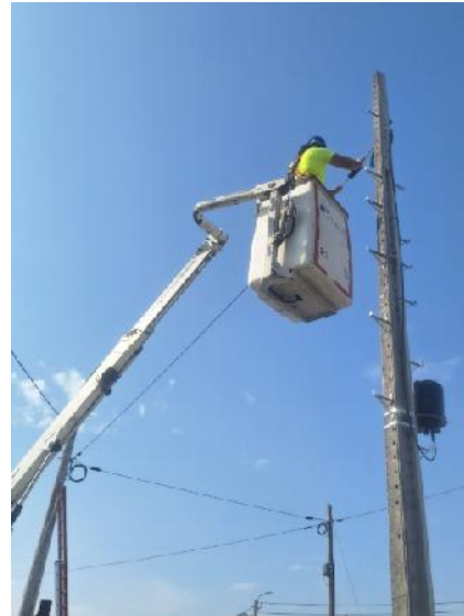
Figura 53 - Trabalho em altura com recurso a PEMP
