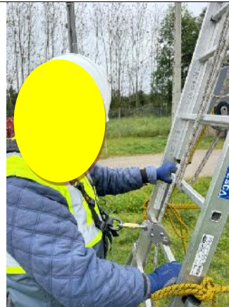
Figura 47 - Arnês ligado ao Anti queda por Mosquetão
