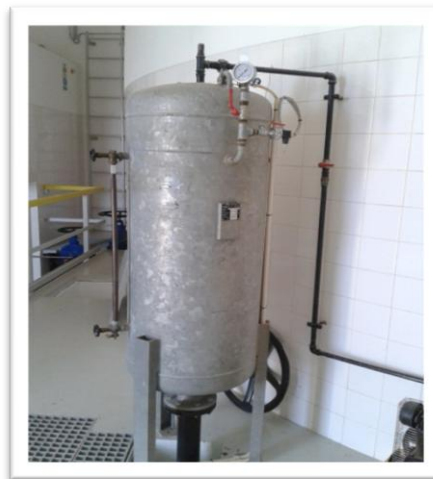
Reservatório hidropneumático
