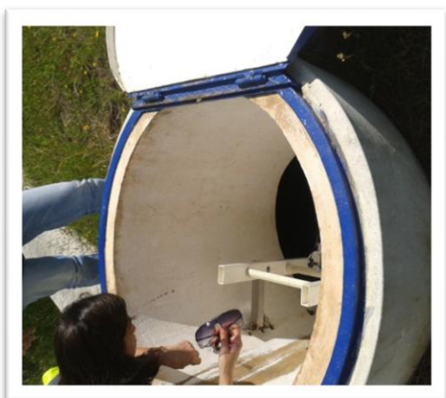
3- Parte superior e de acesso ao interior do Reservatório TM
