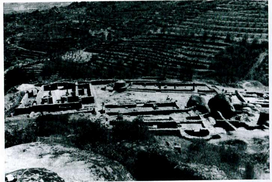
Vista geral da Villa Romana do Prazo.
