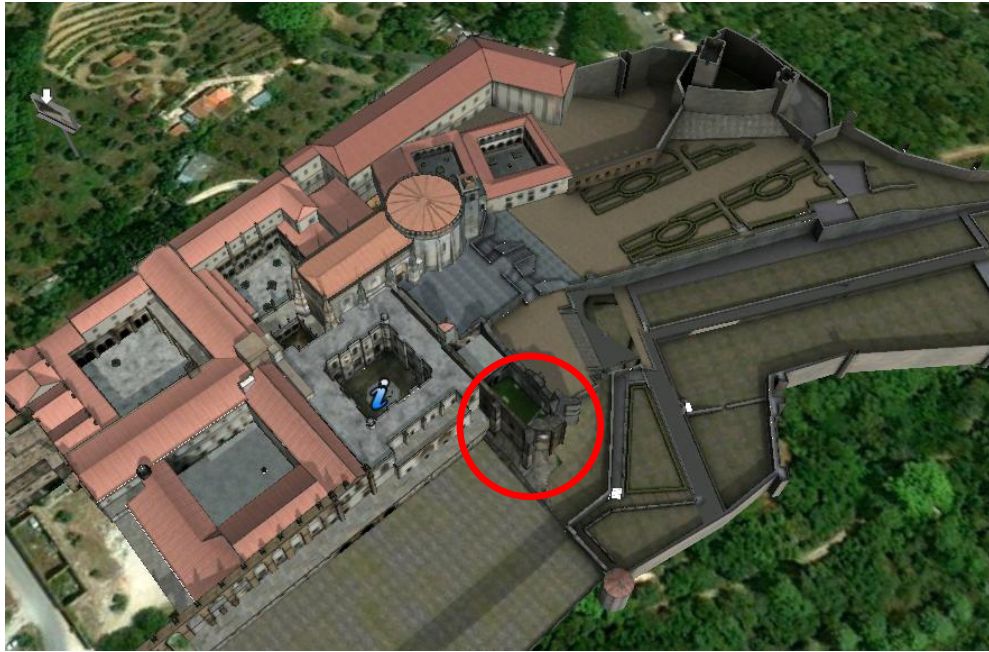
Fig. 2: Imagem 3D do convento de Cristo, evidenciando a Sacristia Incompleta (Google maps, 2011).
