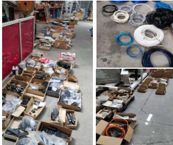
Figura 14: Início da agregação de materiais.
