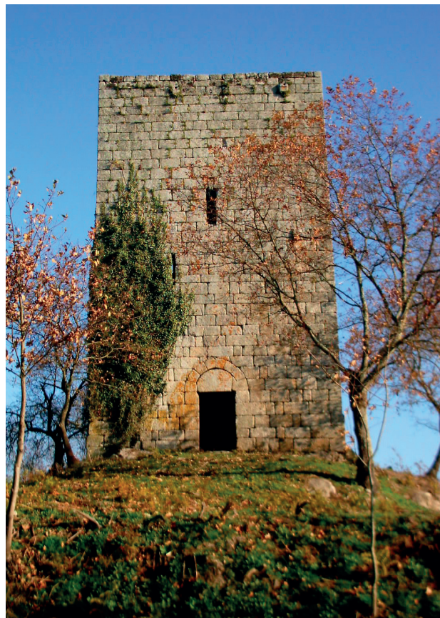
Figura 2. Torre de Vilar em ruínas (inícios do século XXI) (Rota do Românico).
