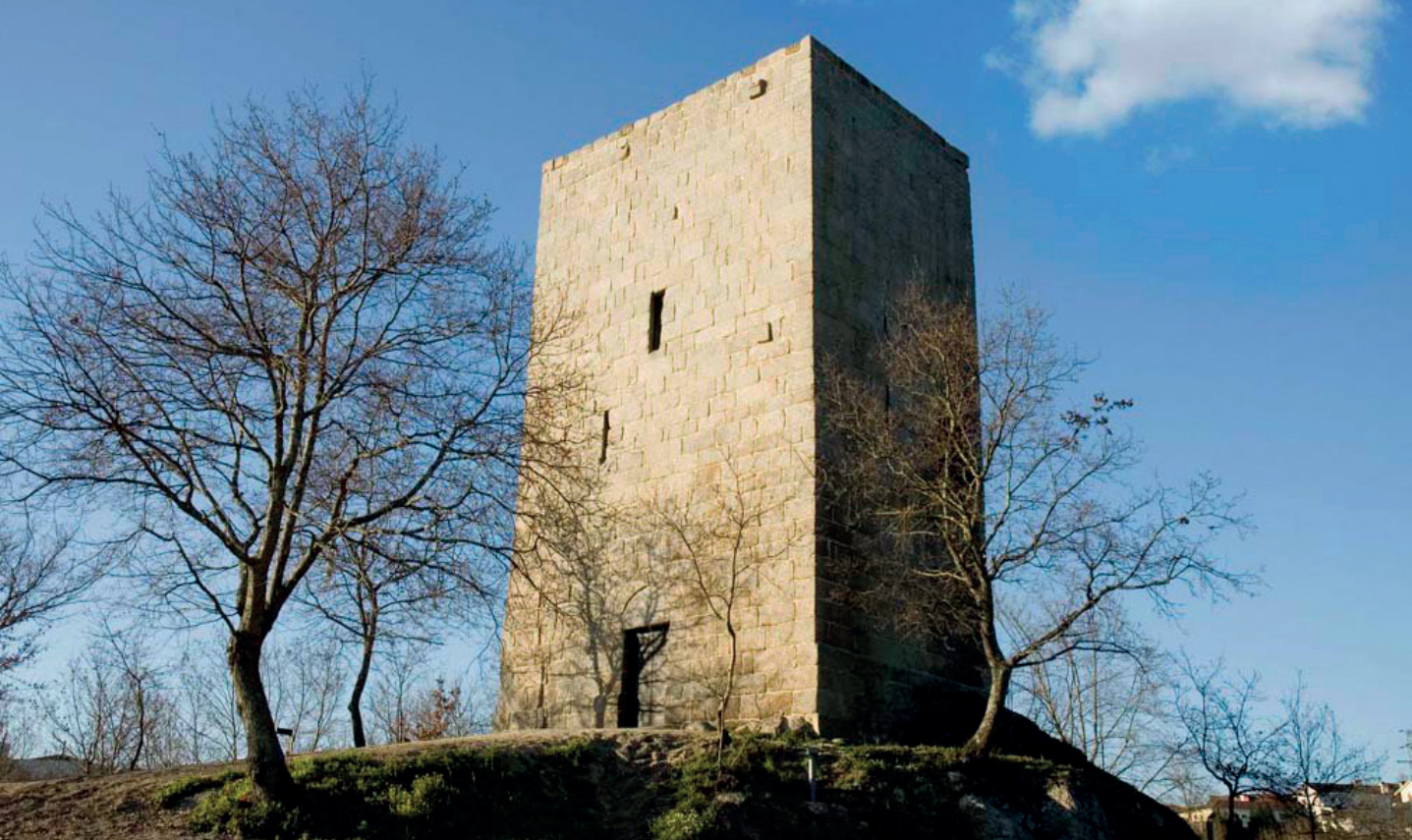
Figura 7. Torre de Vilar (atualidade) (Rota do Românico).
