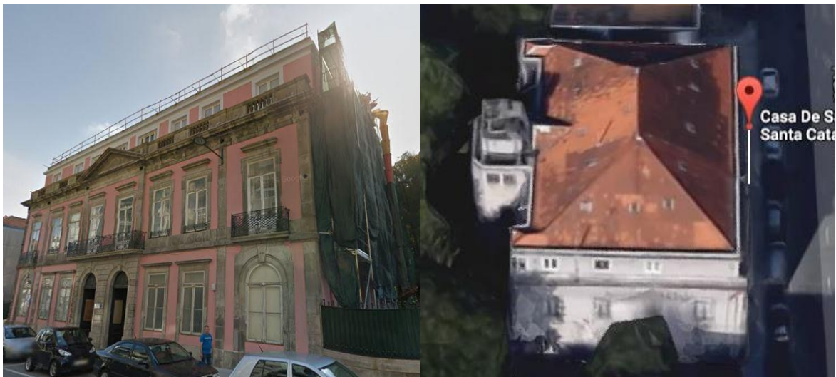
Figura 64 - Reconhecimento do edifício onde seria instalada a UPAC
