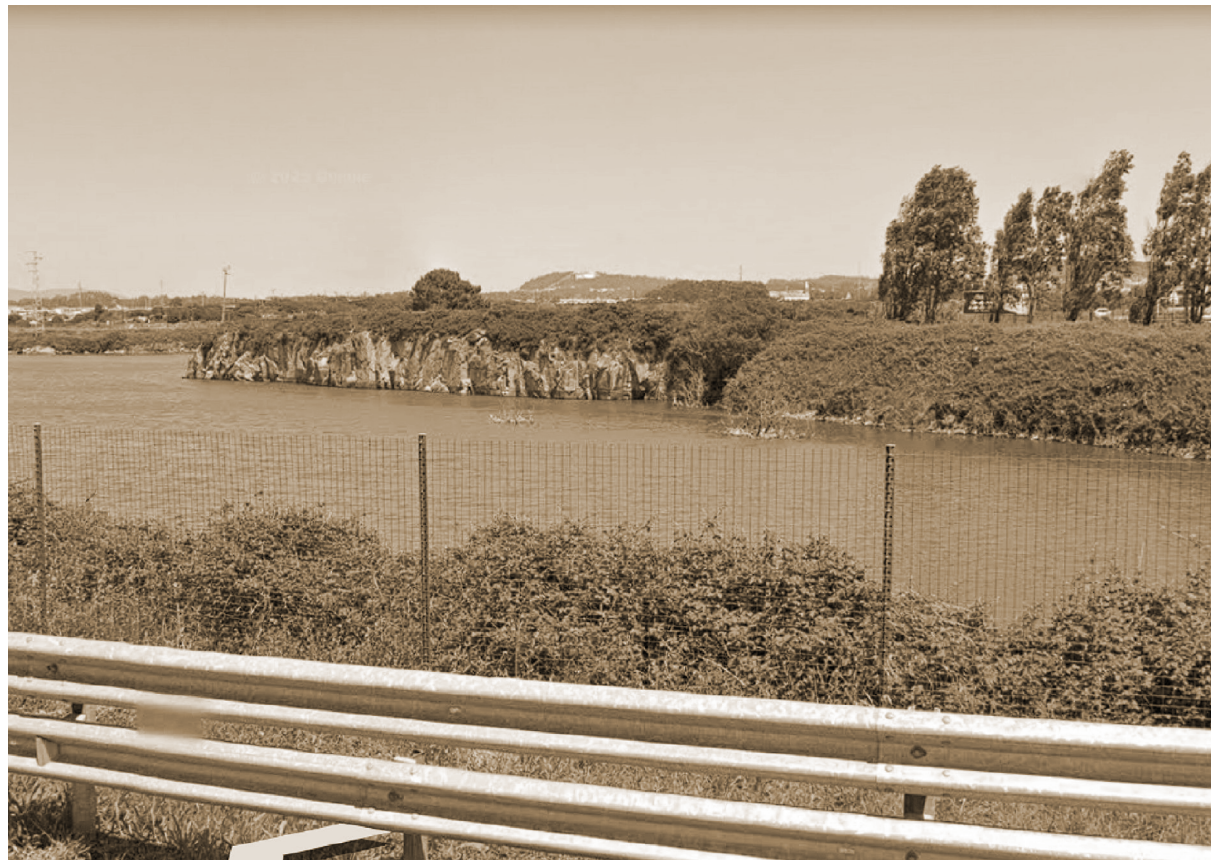
Fig. 58 – Foto do lugar a intervir. A Pedreira da Póvoa. Coberta por água.
