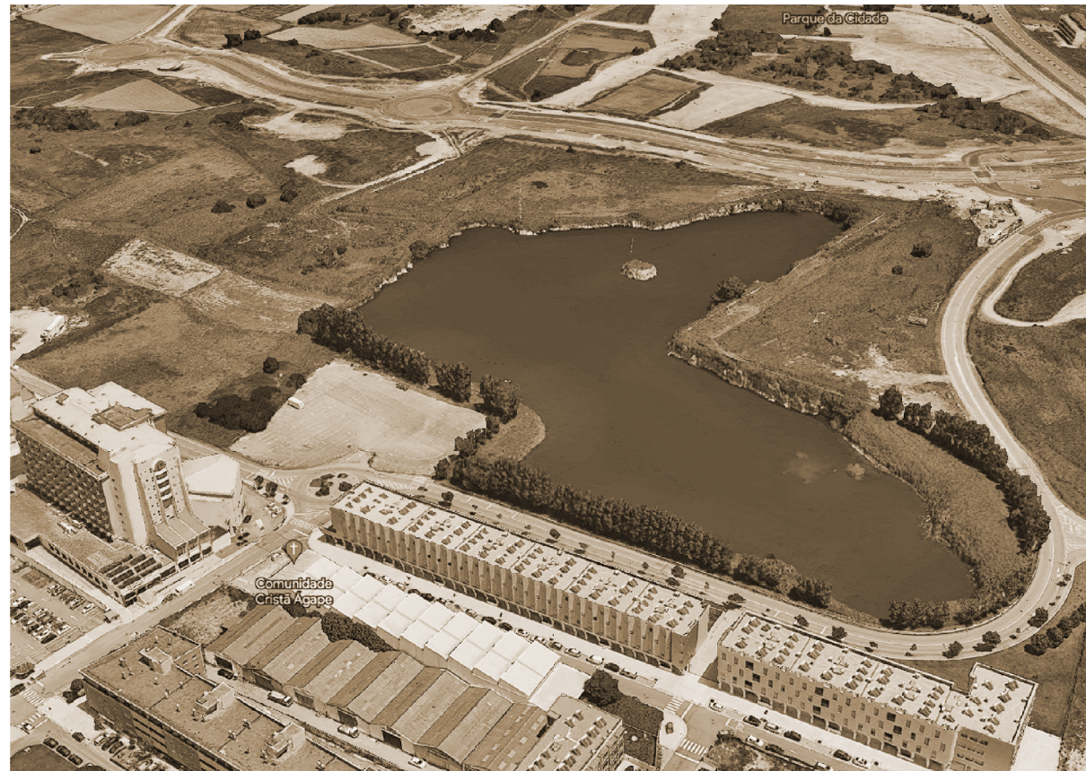
Fig. 47 – Vista aérea da área de intervenção.
