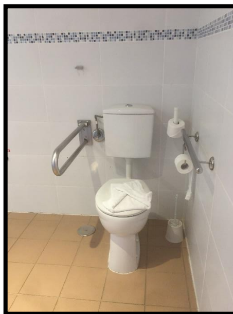
Figura 32- Sanita com apoios
