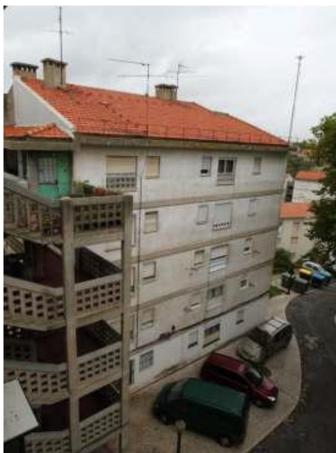
Fig.22 – Fachada de lote e caixa de escadas sem cobertura (à esquerda) [Fonte: PMT]
