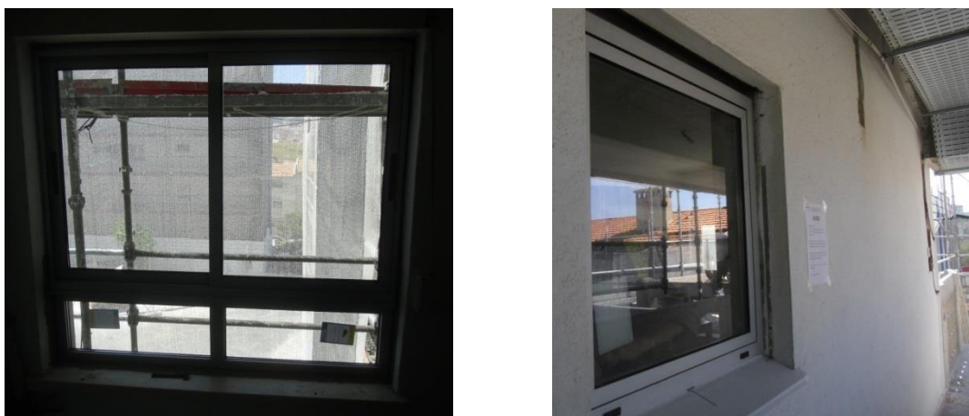
Fig.32 – Vista da caixilharia pelo interior (à esquerda) e pelo exterior (à direita) [Fonte: Ripórtico]
