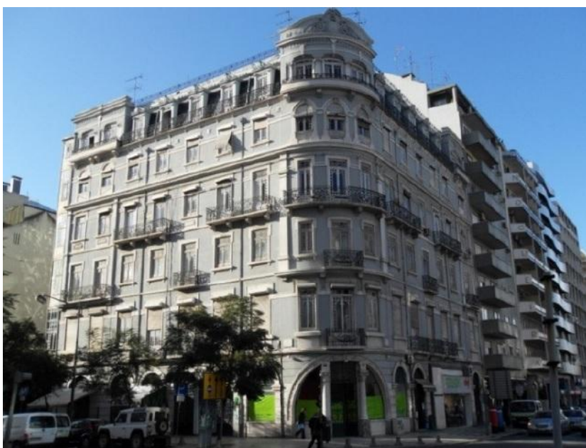
Fig.8 – Edifício gaioleiro existente na Avenida da República, em Lisboa [7]
