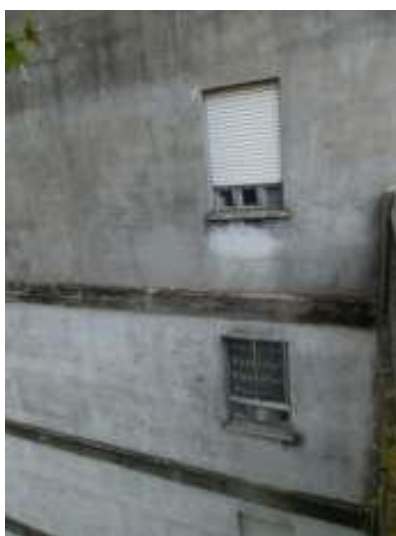
Fig.30 – Exemplo de janelas com a caixilharia inicial (de correr) e com estore em PVC branco [Fonte: PMT]
