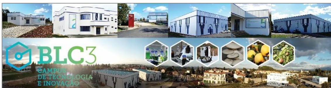
Figura 2. Imagens da BLC3 - Campus de Tecnologia e Inovação - Edifícios e vista panorâmica
