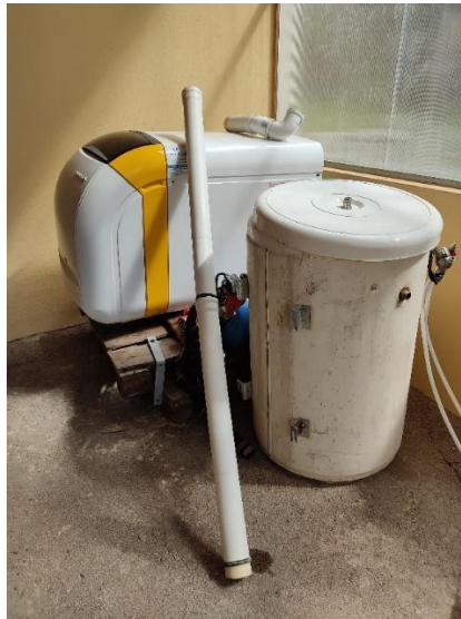
Figura 47 - Caldeira a gasóleo e depósito AQS removido
