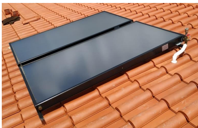
Figura 65 - Instalação dos coletores solares térmicos finalizada
