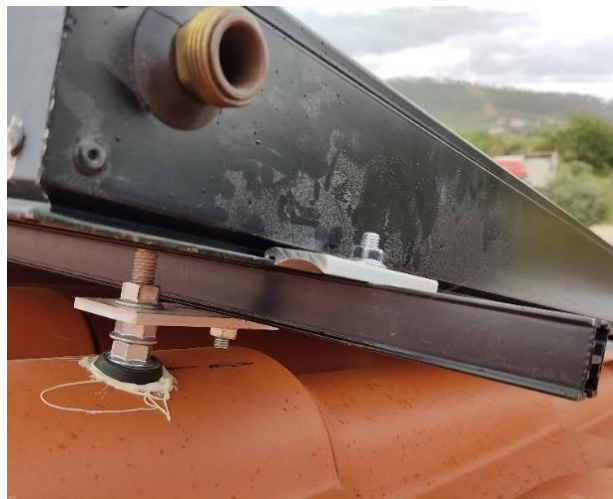
Figura 64 - Fixação dos coletores solares
