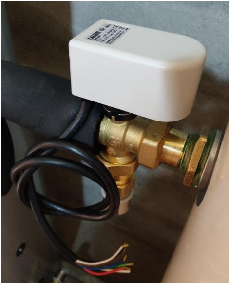
Figura 49 - Instalação da válvula motorizada de três vias
