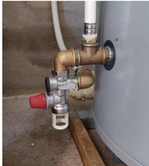
Figura 50 - Instalação do grupo de segurança para termoacumulador
