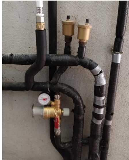
Figura 51 - Interligação de grupo de enchimento automático
