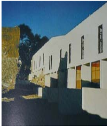
Fig. 5 - São Vitor - SAAL Porto – fotografia em: Portugal: Arquitectura
