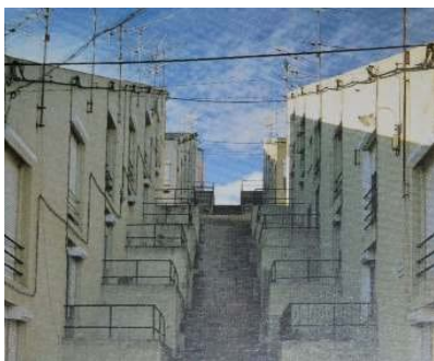
Fig. 10 - Casal Figueiras - Setúbal - SAAL Sul - fotografia em: Portugal: Arquitectura do Século XX
