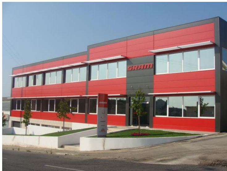
Figura 2-3 - Gabinetes da SRAMPort
