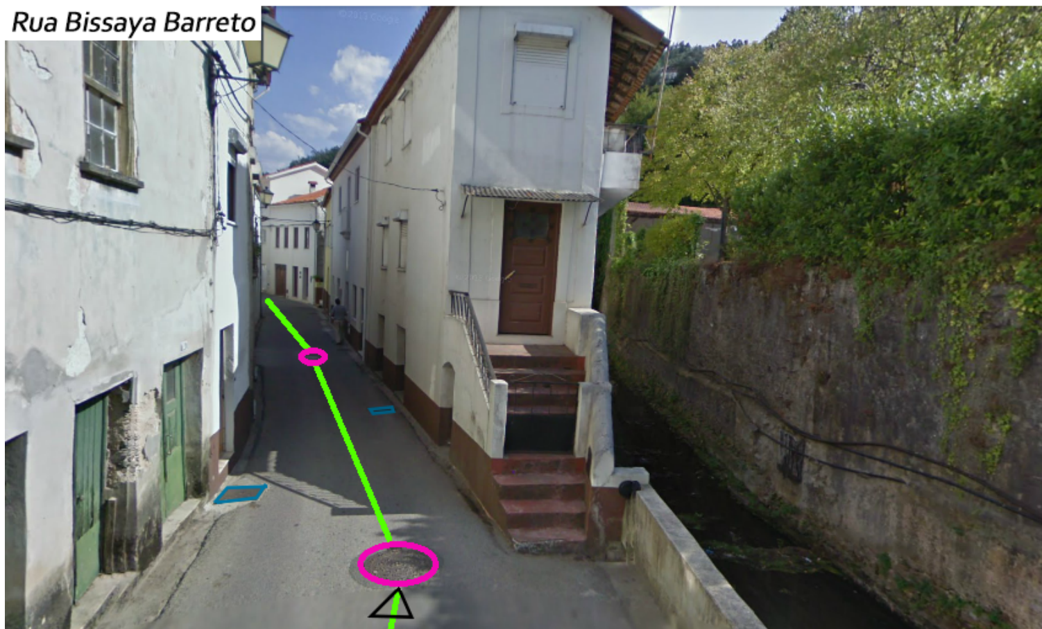
Figura 3.23: Coletores localizados abaixo da cota da ribeira
