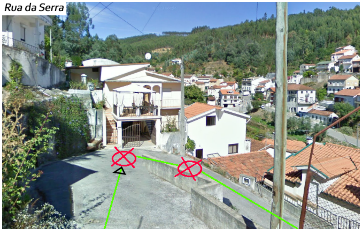
Figura 3.24: Câmaras de visita e caixas de ramal pavimentadas
