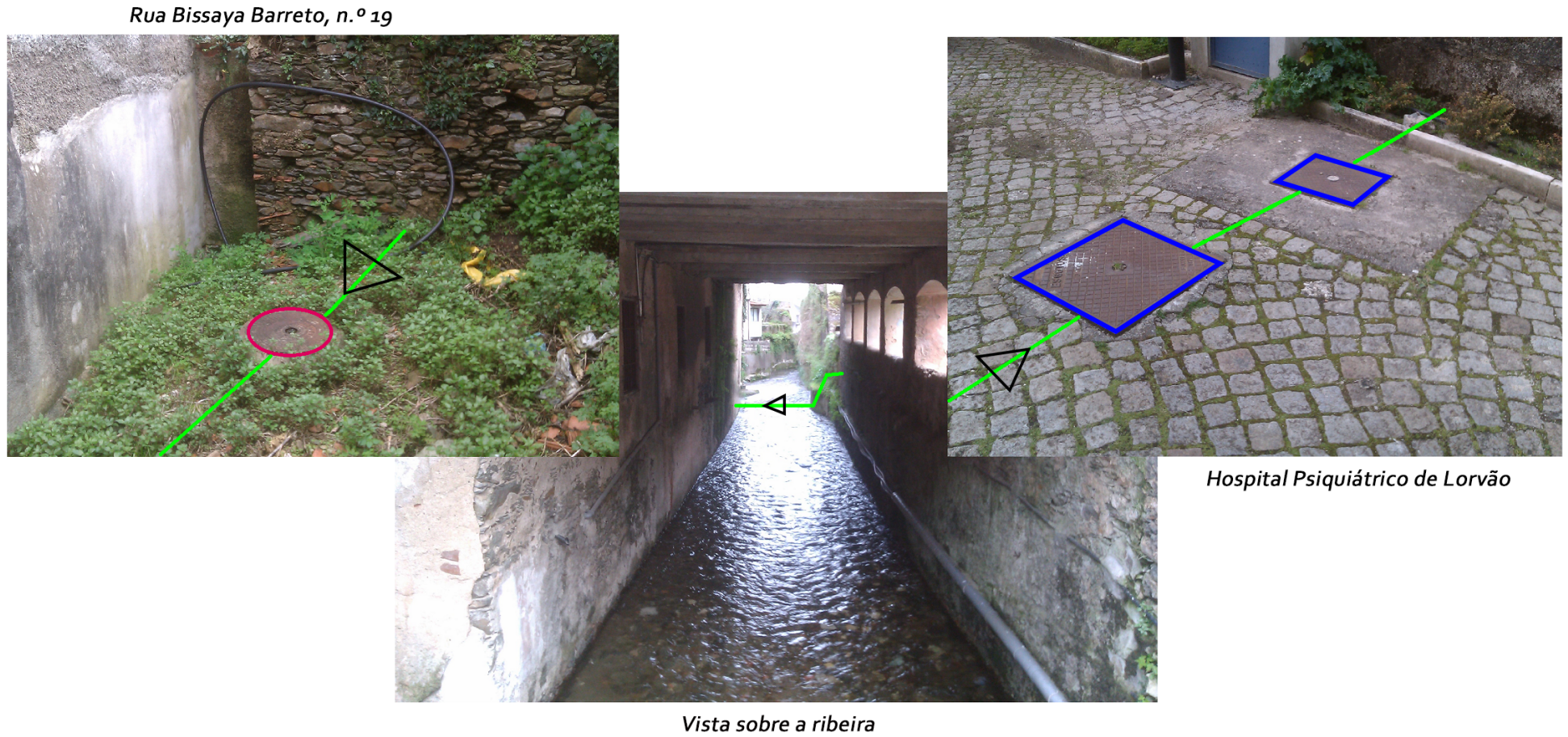
Figura 3.21: Rede de drenagem que provém do Hospital Psiquiátrico de Lorvão, que atravessa a linha de água
