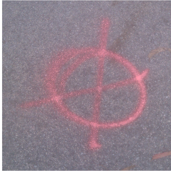
(b) Marcação efetuada no pavimento
