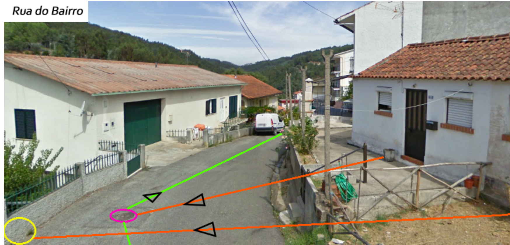
Figura 3.26: Anomalia detetada (fossa séptica usada para fins impróprios)
