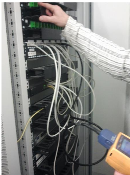
Figura 46 – Verificação de ligações no bastidor de rede.
