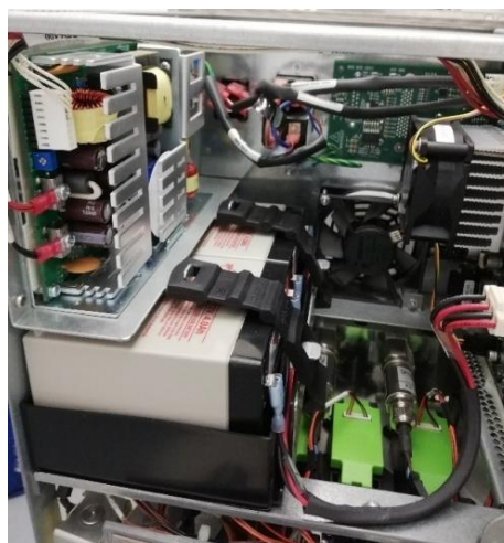
Figura 65 – Substituição de duas baterias do ventilador
