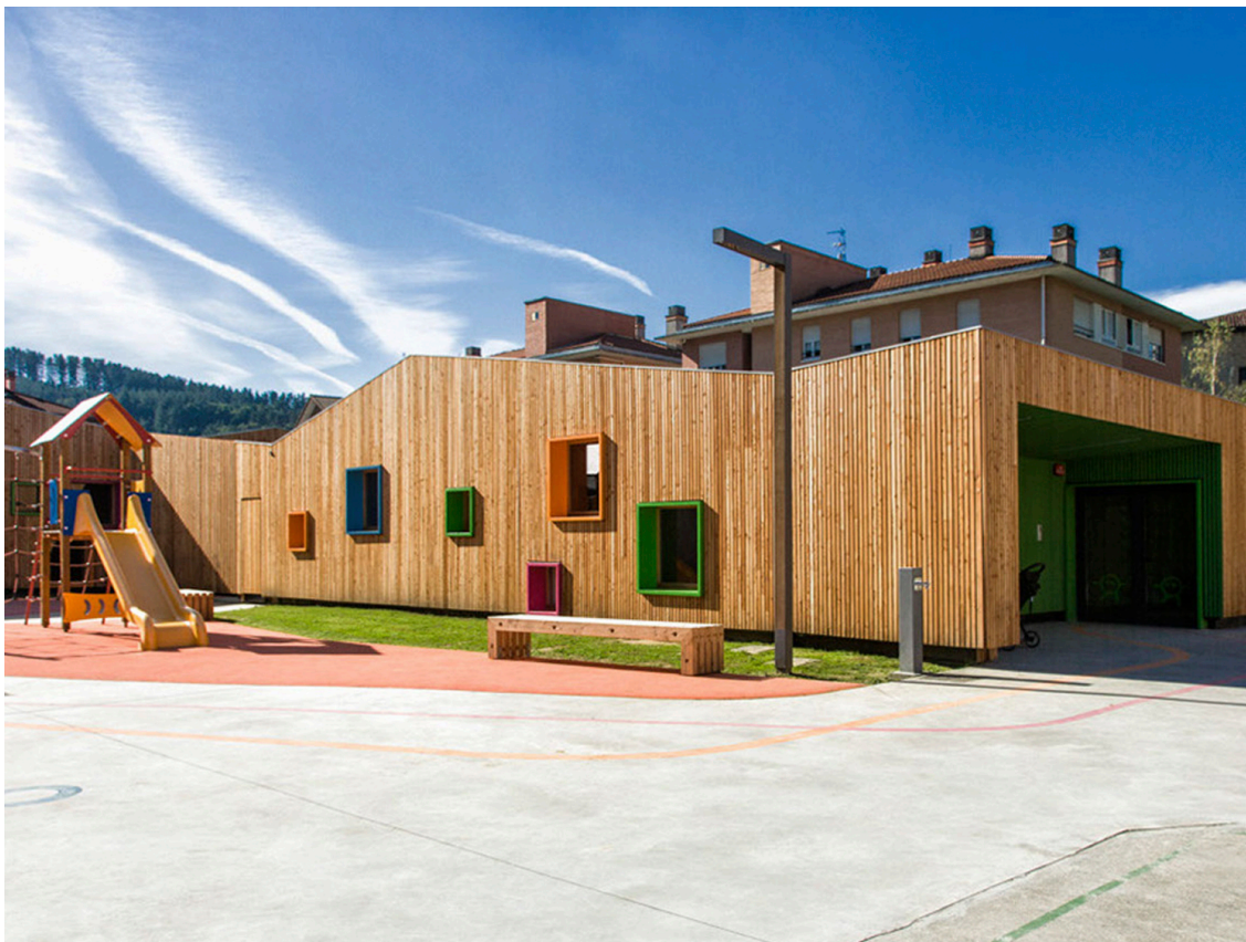
Fig. 14 Nuevo edificio educación infantil y guardería en Zaldibar
