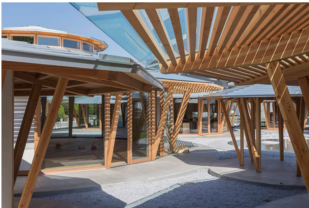
Fig. 64 Madera, vidrio, acero galvanizado y hormigón como materiales principales de construcción
