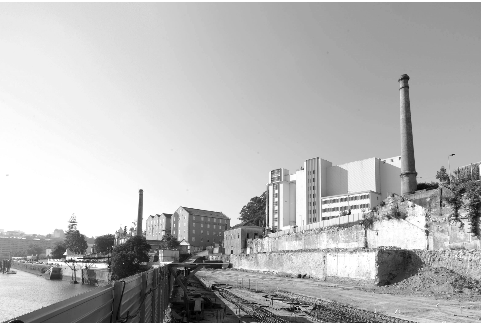
Imagem 12. Demolição da Moagens Harmonia | Nova ala de quartos Hotel Pestana
