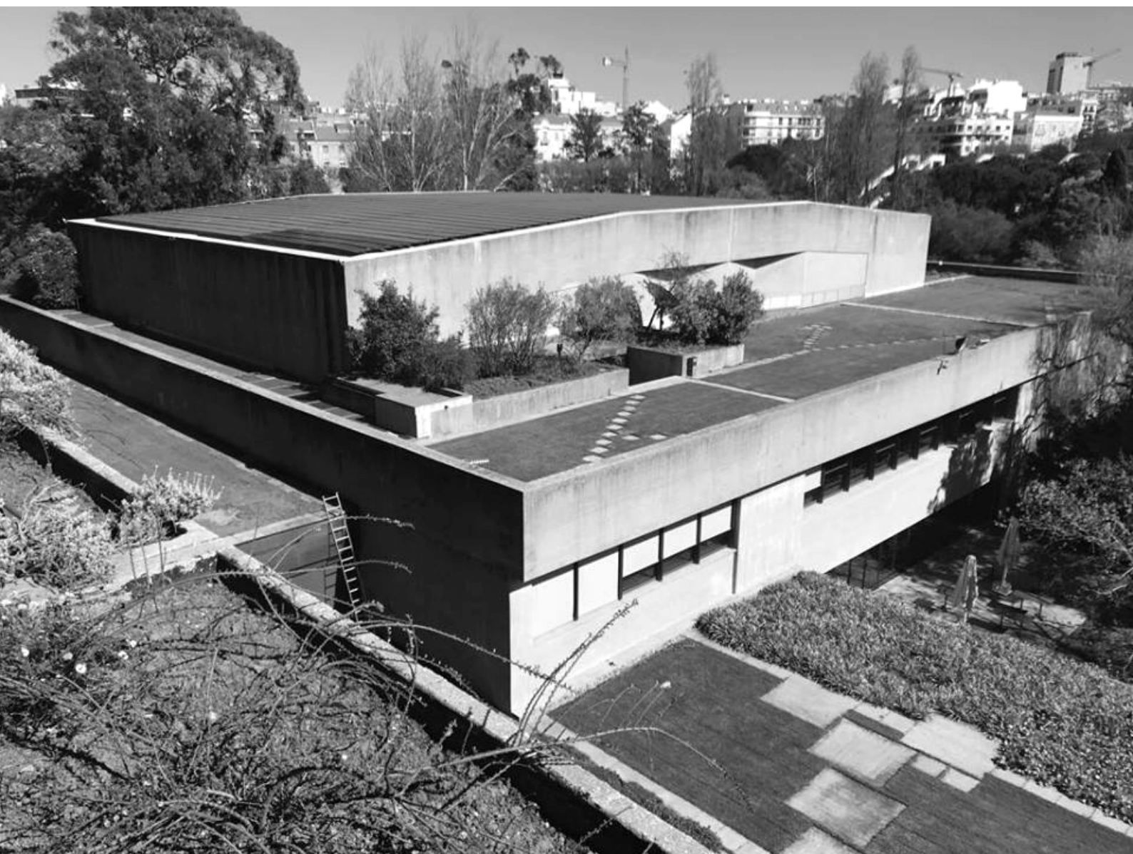
Imagem 20. Cobertura auditório, Fundação Gulbenkian
