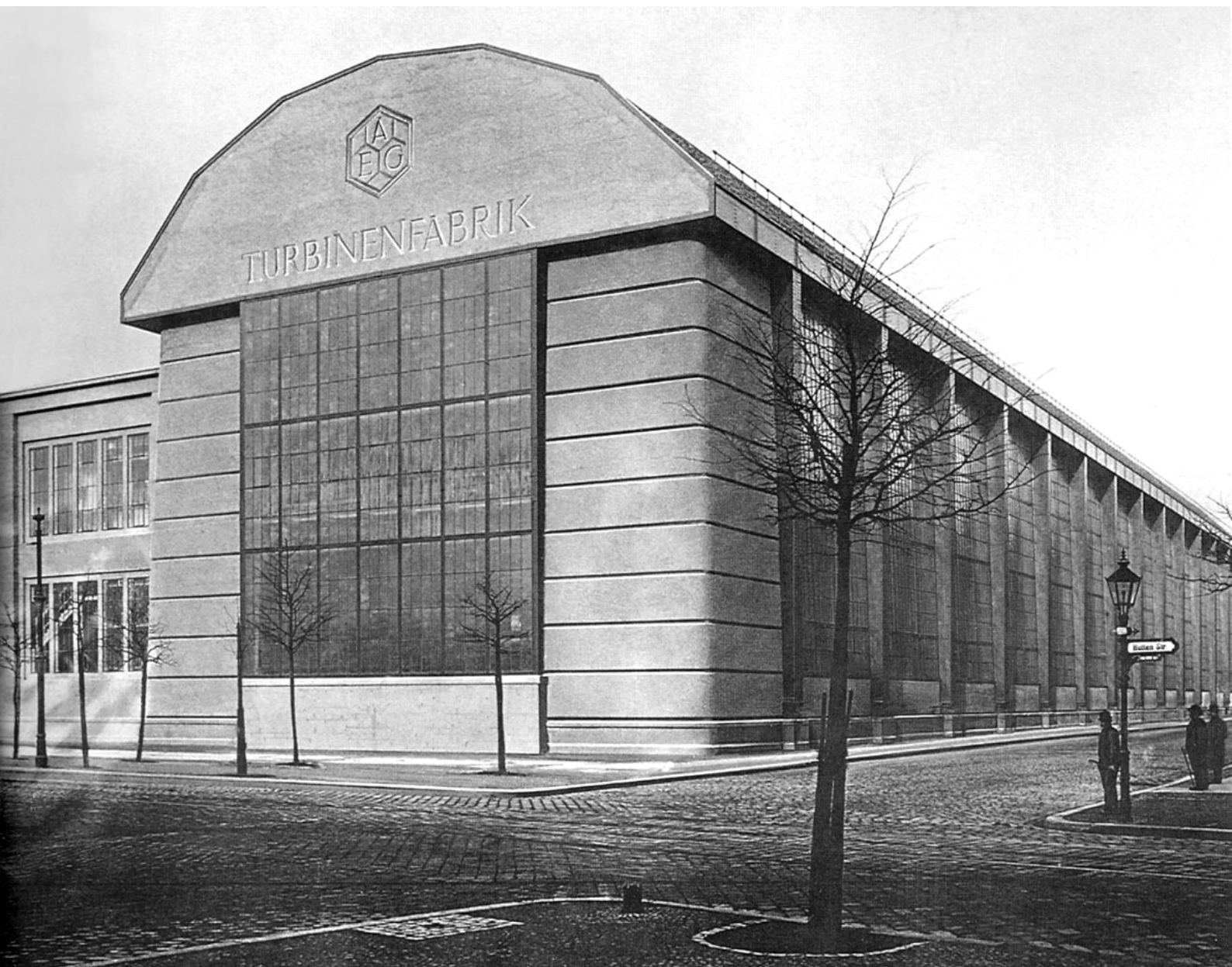
Imagem 5. Fábrica de turbinas AEG, Alemanha, Peter Behrens
