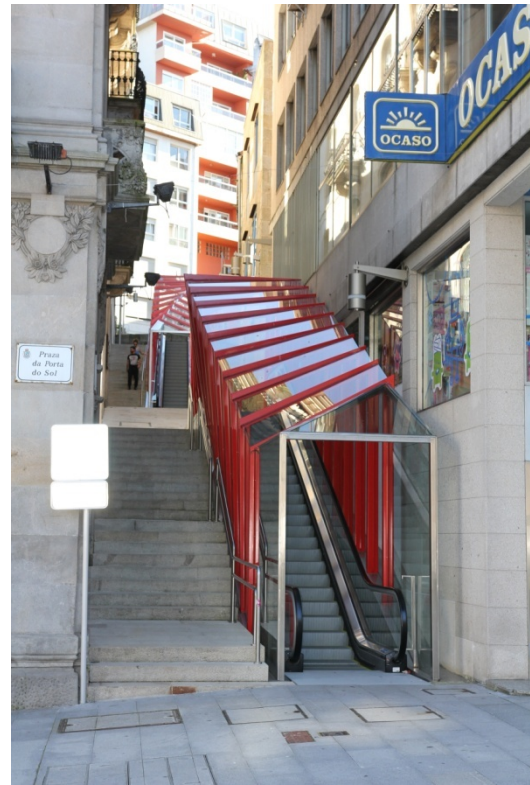
Fig. 4.122. Imagen de los tramos construidos de las escaleras mecánicas de la Puerta del Sol.
