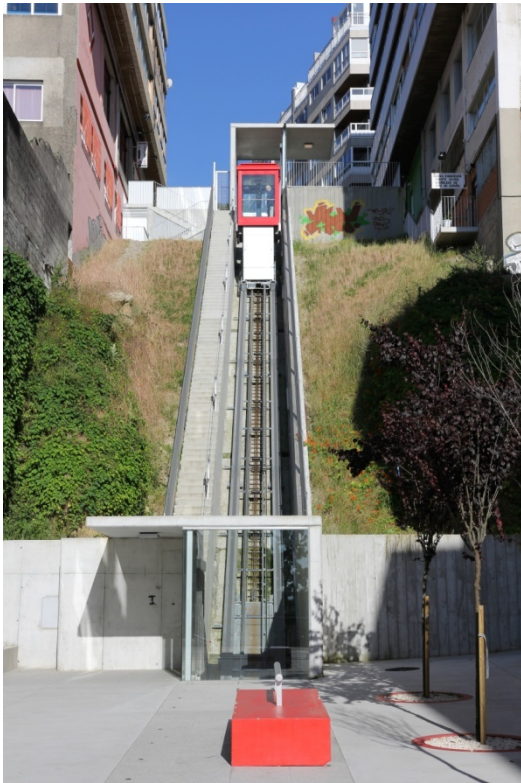
Fig. 4.121. Imagen de la plataforma de acceso al elevador de la Calle Camelias desde la Calle Menéndez Pelayo.
