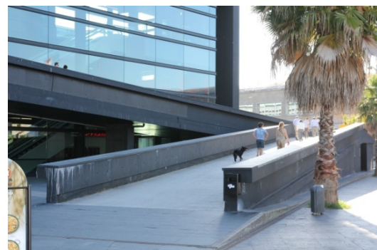
Fig. 4.123. Imagen del arranque de la rampa exterior del centro comercial A Laxe obra del arquitecto Francisco Javier Sáenz de Oiza.
