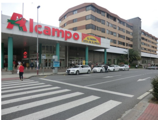
Fig. 4.96. Centro comercial Alcampo de Coia.
