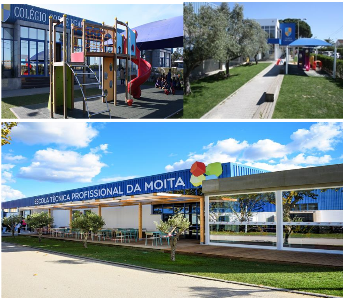
Figura 2 - Instalações Colégio e Escola Técnica Profissional Moita
