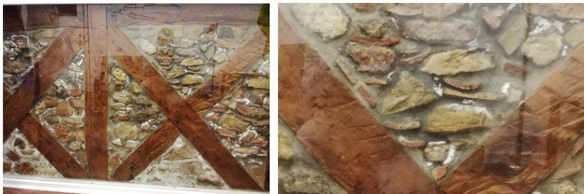
Fig. 37 - Painel na parede que evidencia a “gaiola pombalina” e o seu preenchimento, onde são visíveis, além das pedras, os pedaços de tijolo (Foto do autor, junho 2018)
