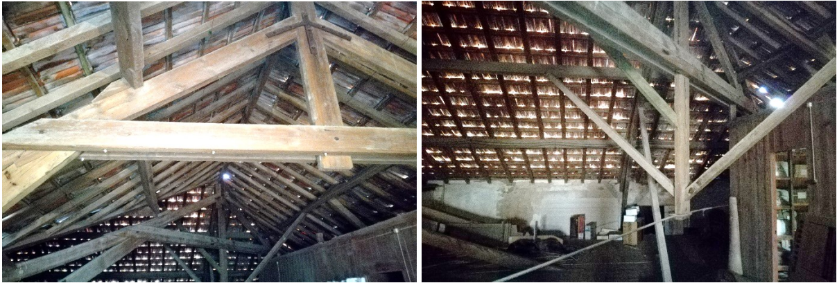
Fig. 40 - Cobertura do edifício (Fotos do autor, junho 2018)
