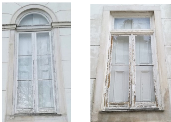
Fig. 41 - Janelas de peitoril com portada interior (Fotos do autor, junho 2018)
