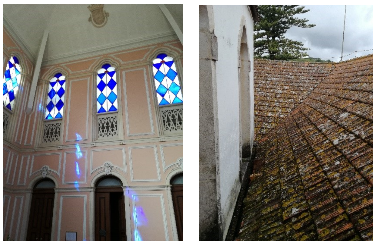
Fig. 36 - Parede exterior PE4, vista interior e exterior (Fotos do autor, junho 2018)
