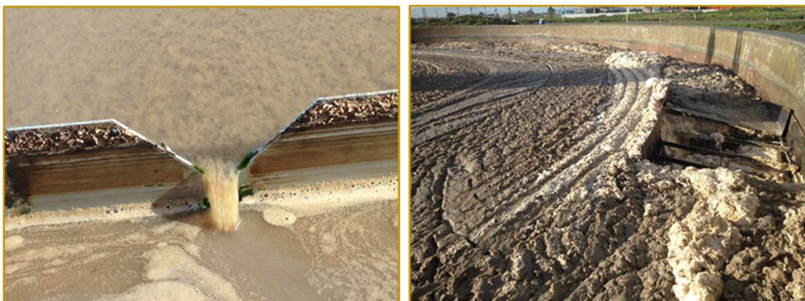
Figura 6: Exemplo de fenómenos bulking (levantamento de lamas) de um descarregador de um decantador numa pequena ETAR da zona sul do município para
