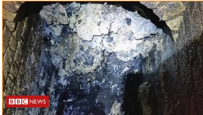
Figura 3: “Monstro de gordura” encontrado a bloquear os esgotos de Londres (“‘Monster’ fatberg found blocking east London sewer”) (BBC News, 12-09-2017)
