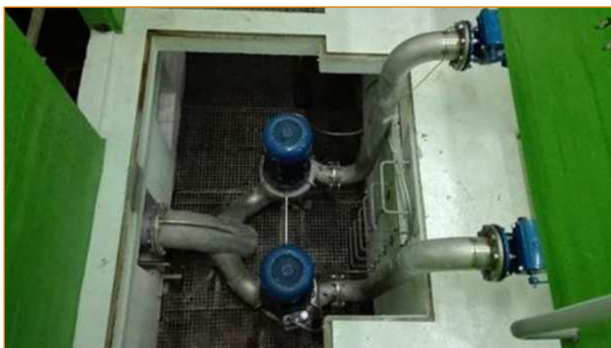
Figura 13: Exemplo de um sistema de bombagem em linha. EEAR da Ponte Galante, zona urbana da Figueira da Foz.
