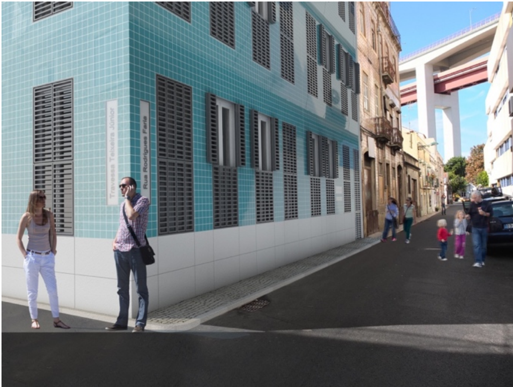
Figura 18 - Visão diurna dos edifícios Factory 1 e 2
