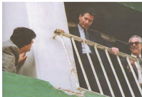
Figura 7 - Investigações à queda do varandim-foto:ND
