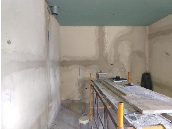
Figura 40: Colocação de teto falso na cozinha
