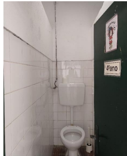
Figura 99: Substituição dos pisos e azulejos
