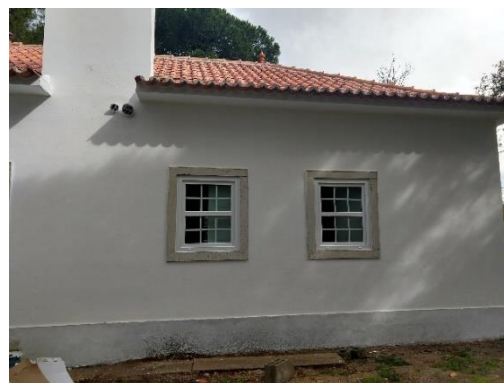
Figura 47: Trabalho de limpeza, conservação e impermeabilização das telhas
