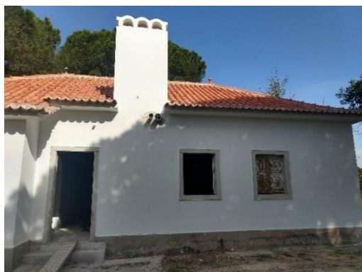
Figura 46: Trabalhos de limpeza realizado na cobertura
