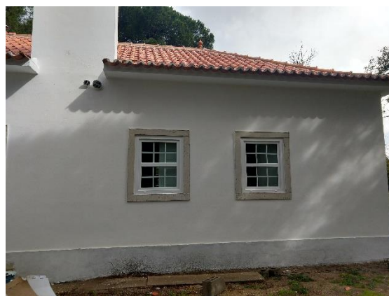
Figura 51: Recuperação das cantarias
