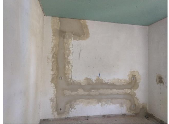
Figura 41: Colocação de teto falso na cozinha
