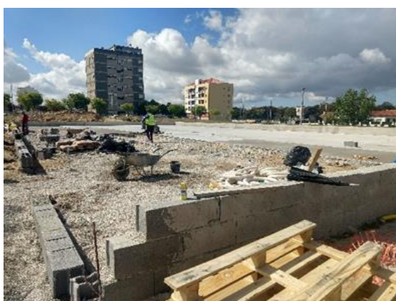
Figura 115: Aplicação do betão poroso
