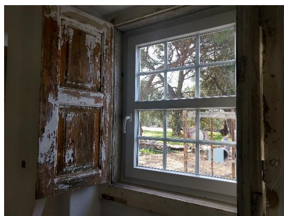
Figura 49: Recuperação das portadas interiores
