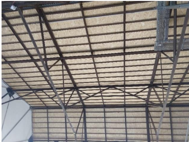
Figura 94: Placas em OSB
