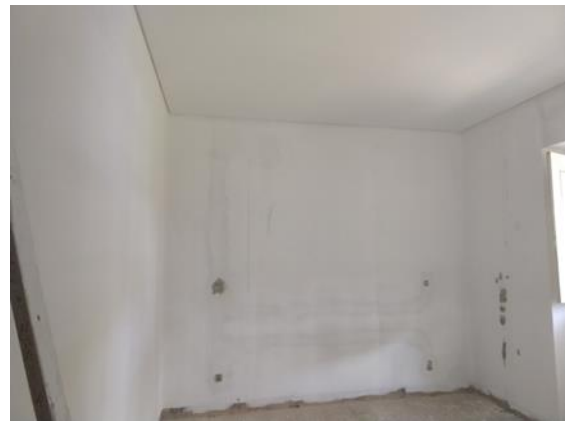
Figura 43: Remate do teto do quarto
