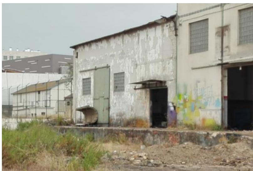
Figura 67: Antigo Armazém de Sulfato, CORPO A - In: Pórtico, Gabinete de Engenharia, LTDA
