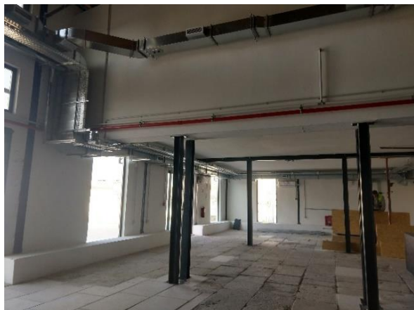
Figura 90: Sala de refeições, piso de lajedo em pedra recuperado
