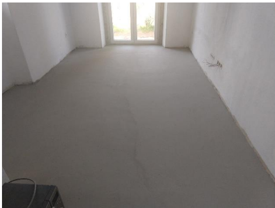
Figura 35: Aplicação de argamassa de regularização - Quarto
