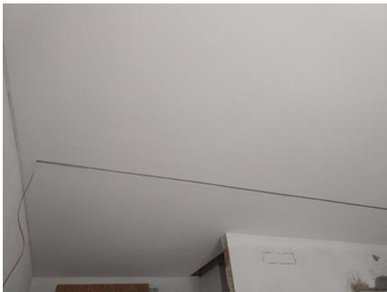
Figura 42: Remate do teto na cozinha
