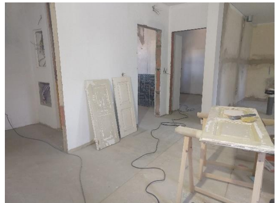
Figura 36: Aplicação de argamassa de regularização - Sala e Cozinha
