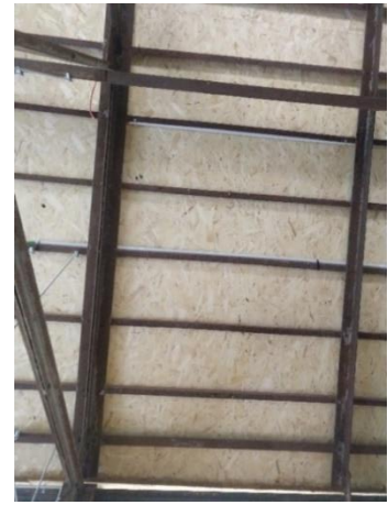
Figura 95: Estrutura metálica a vista
