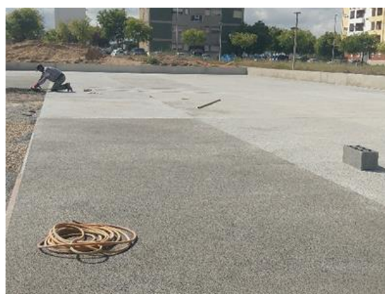
Figura 116: Parte da área do polidesportivo com o betão já aplicado
