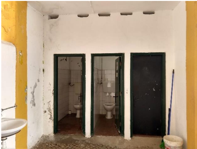
Figura 98: Boxes das Instalações sanitárias -
