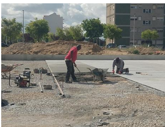
Figura 117: Aplicação do betão sob areia
