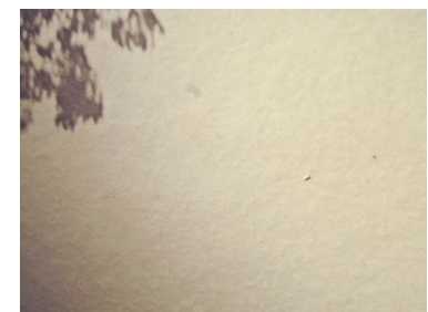
Fig. 69: resultado final com remoção total das manchas
