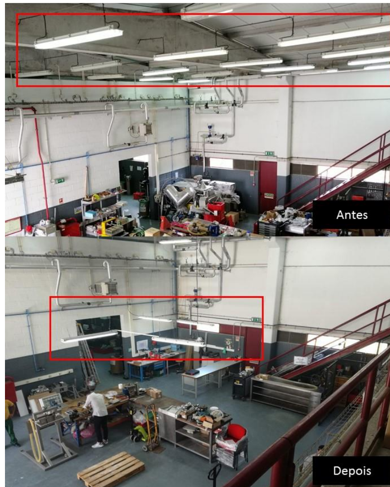
Figura 3.36- Antes e depois do abaixamento das luminárias
