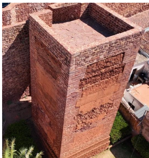
Figura 29: Registo fotográfico aéreo realizado durante a monitorização de monumentos. Fotografia do arquivo do SCR/CMS, 2024.
