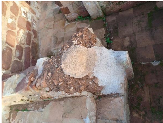
Risco e destacamento do capeamento. Fotografia do arquivo do SCR/CMS, 2024.
