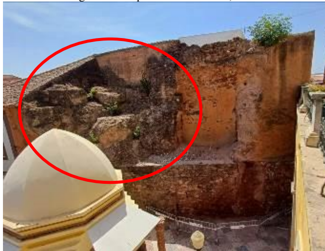
Torre 2. Construída em taipa. Fotografia do arquivo do SCR/CMS, 2024.
