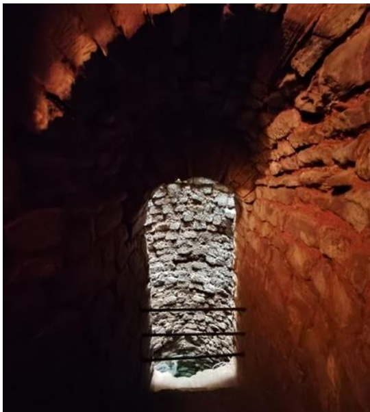
Figura 121: Último patamar do Poço-Cisterna com as barreiras físicas de segurança. Fotografia do arquivo do SCR/CMS, 2023.
