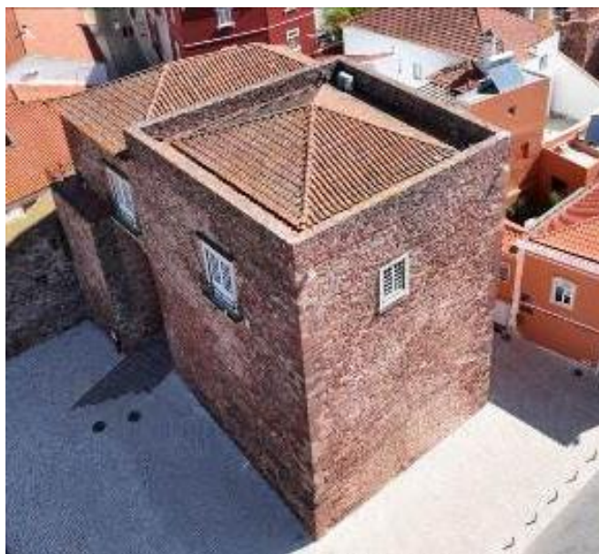
Porta da Almedina ou Torre 1. Porta principal de acesso ao interior da cidade. Fotografia do arquivo do SCR/CMS, 2024
