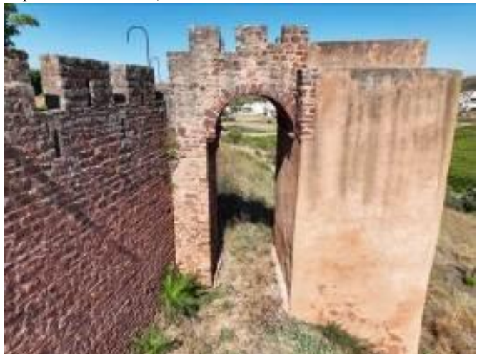
Torre 11 do tipo albarrã revestida com argamassa de cal. O passadiço construído com alvenaria aparelhada com grés de Silves e argamassa de cal. Fotografia do arquivo do SCR/CMS, 2024.
