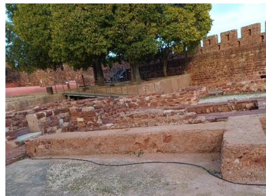
Estrutura em que foi feita consolidação e aplicada cal inject. Fotografias do arquivo do SCR/CMS, 2004.
