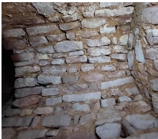
Abertura de juntas, pulverulência, arenização e fissuras nos elementos pétreos, sujidade superficial e presença pontual de sais. Fotografias do arquivo do SCR/CMS, 2024.
