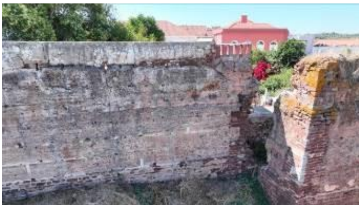
Tramo de muralha identificado como N5 construído em taipa e revestido em argamassa de cal. Observa-se juntas fingidas realizadas com argamassa de cal. Fotografia do arquivo do SCR/CMS, 2024.
