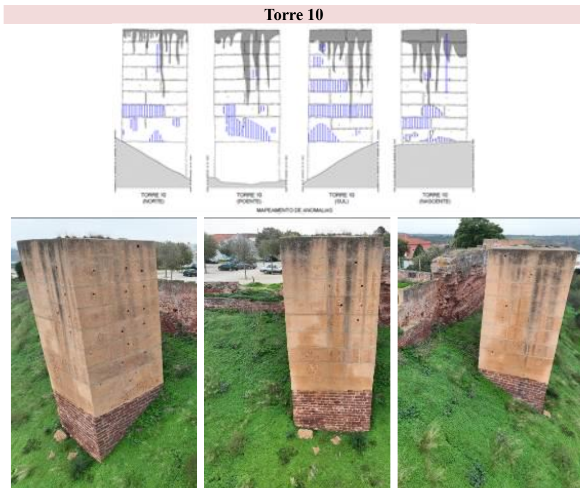
Fotografias com drone da Torre 10. Fotografia do arquivo do SCR/CMS, 2024.
