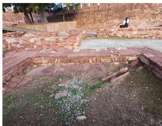
Abertura de juntas na alvenaria do Jardim e aumento da presença de colonização biológica. Fotografia do arquivo do SCR/CMS, 2024.
