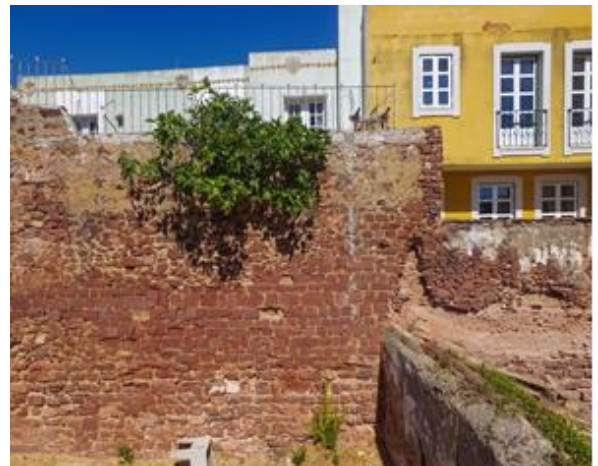
Fotografia do Tramo S8 – LEB, 2017.
