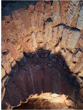
Abertura de juntas, pulverulência, arenização e fissuras nos elementos pétreos, sujidade superficial e presença pontual de sais. Fotografias do arquivo do SCR/CMS, 2024.
