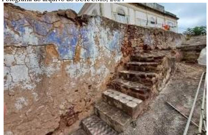
Tramo de muralha S11. Revestido com argamassas cimentícias. Fotografia do arquivo do SCR/CMS, 2024.
