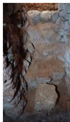
Vão 2. Elevada ausência de argamassas e depósitos decorrentes de arenização dos elementos pétreos e das argamassas de juntas. Fotografia do arquivo do SCR/CMS, 2024.
