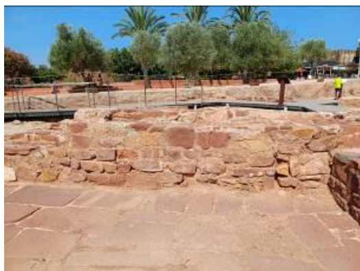
Ausência de argamassa na base da estrutura. Fotografia do arquivo do SCR/CMS, 2024.
