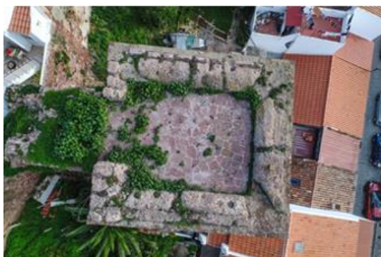
Fotografia com drone da Torre 6 – LEB, 2017.
