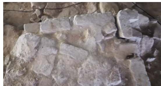
Reforço à torre poligonal em forma triangular construída com grandes blocos de grés talhados e ligados por terra argilosa de cor castanha avermelhada. Fotografia do arquivo do SCR/CMS, 2024.
