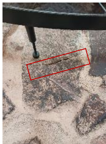
Acumulação pontual de sujidade (gordura), fratura do elemento pétreo e ausência pontual de argamassa. Fotografia do arquivo do SCR/CMS, 2024.
