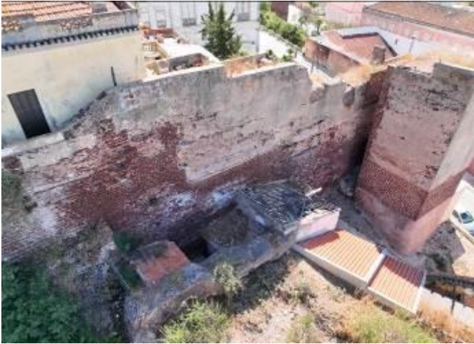
Tramo de muralha O2. Base em alvenaria aparelhada e ordinária e revestido com argamassas à base de cal. Observa-se o estrato interior da estrutura construída em taipa. Fotografia do arquivo do SCR/CMS, 2024.
