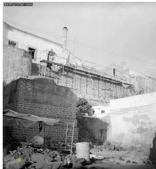
Figura 46: Torre 17 durante a primeira fase de reconstrução. Fotografia do arquivo do SIPA, 1980 - 1989.
