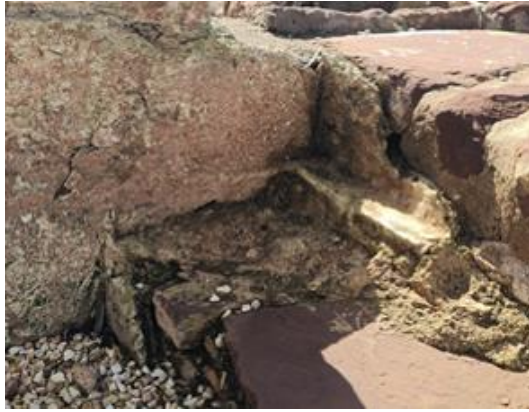
Fissuras e risco de destacamento de estuques. Fotografias do arquivo do SCR/CMS, 2024.
