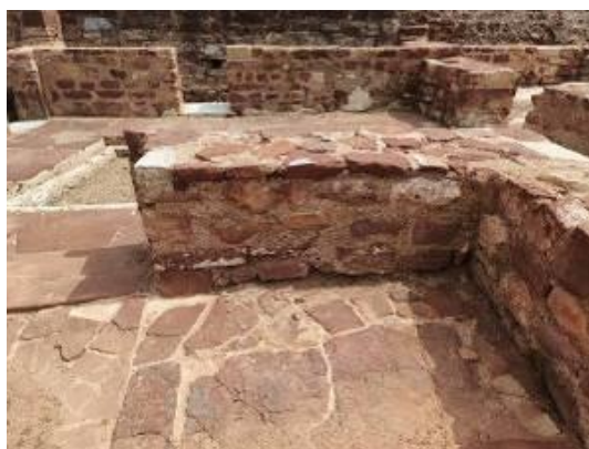
Ausência de argamassa na base do muro. Aumento pontual da desagregação da argamassa. Fotografias do arquivo do SCR/CMS, 2023 à esquerda e 2024 à direita.
