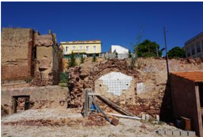
Fotografia do Tramo S11 – LEB, 2017.
