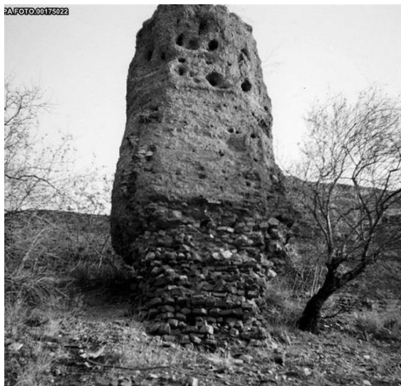
Figura 43: Torre 10 antes da campanha de intervenção da DGEMN no sector norte. Fotografia no arquivo do SIPA, década de 1930 - 1940.
