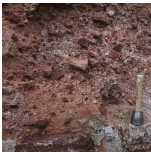
Figura 54: Pormenor da taipa no tramo N6. Fotografia do arquivo do SCR/CMS, 2017.
