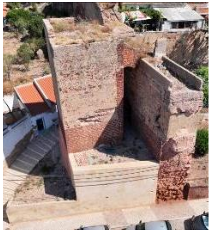
Torre 4 do tipo albarrã, a base foi capeada com alvenaria aparelhada em grés de Silves e argamassa de cal e a parte superior revestida com argamassa de cal com agregados de grés de Silves. Debaixo do revestimento observa-se o estrato interior da torre, taipa. O muro adjacente revestido com argamassa à base de cal de cor da areia de forma a diferenciar do sistema defensivo. Fotografia do arquivo do SCR/CMS, 2024.
