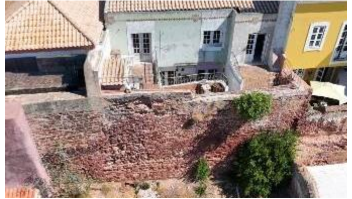
Tramo de muralha S8. Capeamento da muralha original. Alvenaria ordinária com grés de Silves e argamassa à base de cal. Fotografia do arquivo do SCR/CMS, 2024.
