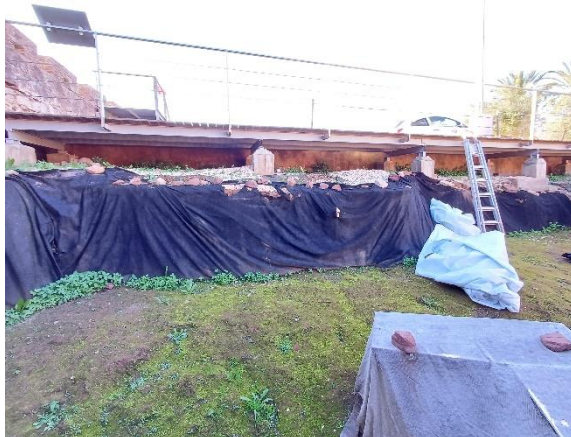
O SCR procedeu à substituição geral do geotêxtil a 10/12/2024. Fotografia do arquivo do SCR/CMS, 2024.
