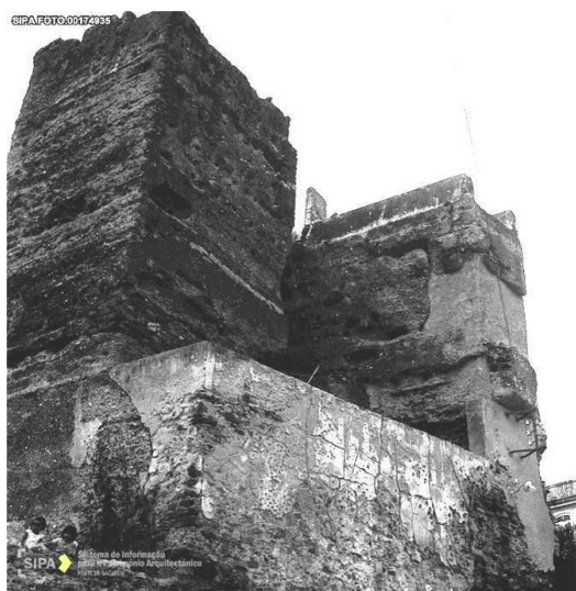
Figura 60: Torre 4 antes das obras realizadas pela DGEMN. Fotografia do arquivo do SIPA, década de 1930 - 1940..
