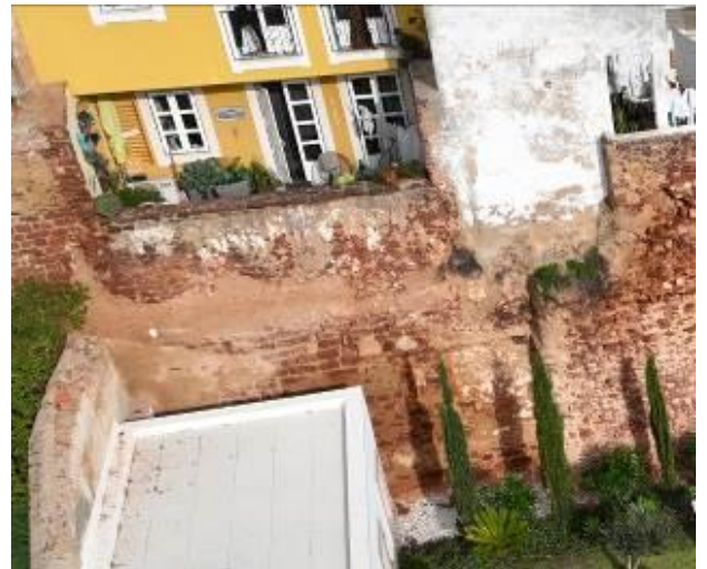
Fotografia do Tramo S7. Fotografia do arquivo do SCR/CMS, 2024.
