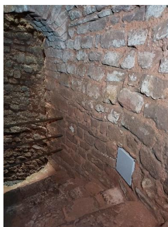
Vão 4. Foi aplicado sistema de segurança para impedir que os visitantes tenham acesso à água. Elevada ausência de argamassa de juntas, o que potencia o risco de destacamento de elementos pétreos. O SCR iniciou o RP da intervenção de conservação e restauro pontual do Poço-Cisterna. Fotografia do arquivo do SCR/CMS, 2024.
