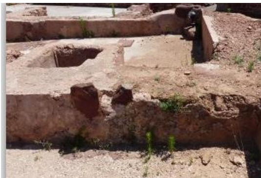
Figura 102: Antes da intervenção. Fotografia do arquivo do SCR/CMS, 2014.
