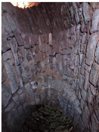
Abertura de juntas, pulverulência, arenização de elementos pétreos, sujidade superficial e presença pontual de sais. Fotografias do arquivo do SCR/CMS, 2024.
