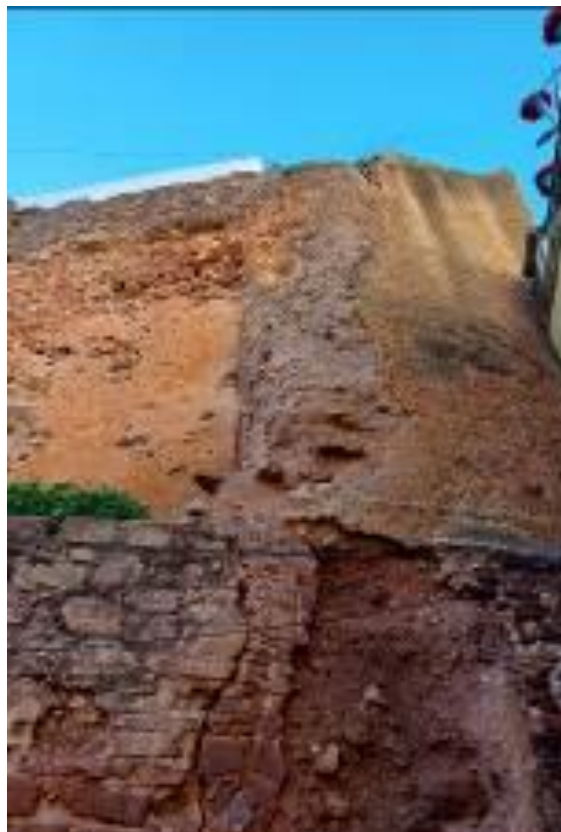
Colocação de baias a 08/2024 para proteção dos trauntes devido a fissura e destacamento de elementos pétreos e taipa. Fotografia do arquivo do SCR/CMS, 2023.
