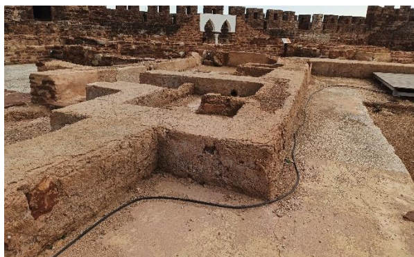
Revestimentos que funcionam como camada de sacrifício do substrato inferior (taipa). Fotografia: autor, 2025.
