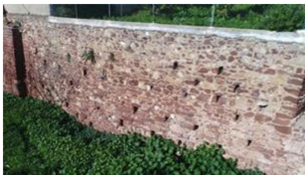
Fotografia do alçado sul do Tramo S2 – LEB, 2017.
