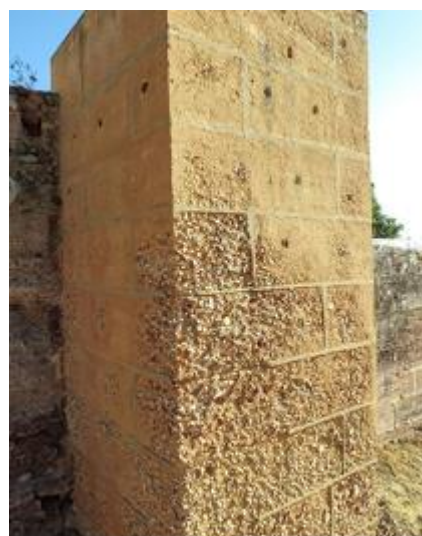
Fotografia do alçado nascente da Torre 9 – LEB, 2017.
