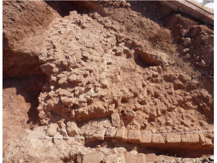
A base da Torre 18 construída com alvenaria em grés de Silves e argamassa de cal. Fotografia do arquivo do SCR/CMS, 2023.
