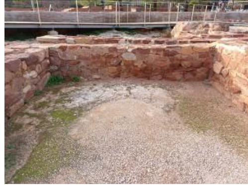
Abertura de juntas e depósitos na base da estrutura resultantes da desagregação das argamassas e elementos pétreos expostos às condições atmosféricas e presença de vegetação. Fotografia do arquivo do SCR/CMS, 2024.
