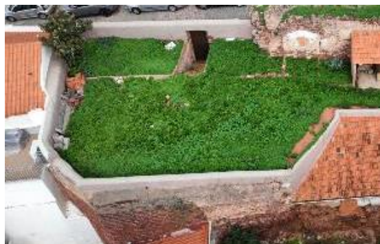
Fotografia da Torre 3. Fotografia do arquivo do SCR/CMS, 2024.
