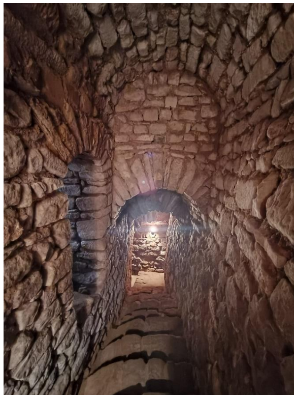
Galeria em espiral o 2º patamar formado por escadaria coberta por abóbadas de tramos segmentados e de perfil semicircular. Fotografia do arquivo do SCR/CMS, 2023.
