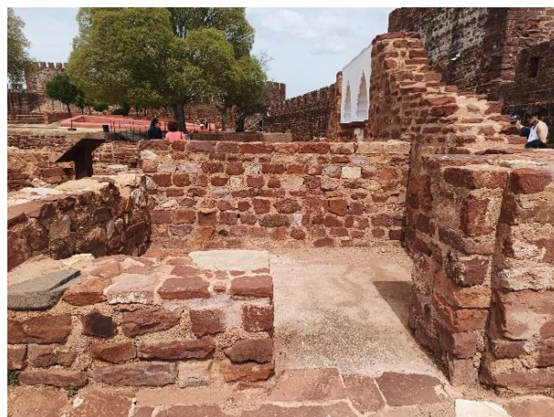
Pavimento regularizado com argamassa com cal e areia e brita. Fotografia: autor, 2025.
