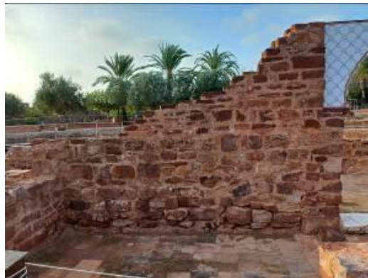
Ausência de argamassa na base do muro que coloca em risco o destacamento de elementos pétreos. Fotografias do arquivo do SCR/CMS, 2023 à esquerda e 2024 à direita.
