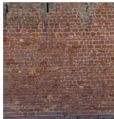
Figura 40: Alvenaria aparelhada de tramo de muralha do sector norte (N11) com um padrão entre as fiadas dos elementos. Fotografia do arquivo do SCR/CMS, 2017.
