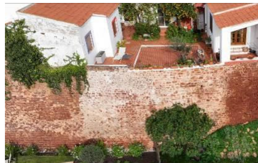
Fotografia dos Tramos S3 e S4. Fotografia do arquivo do SCR/CMS, 2024.
