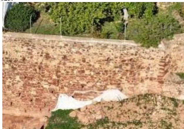
Tramo de muralha S2. Capeamento da muralha original. Alvenaria ordinária com grés de Silves e argamassa à base de cal. Fotografia do arquivo do SCR/CMS, 2023.
