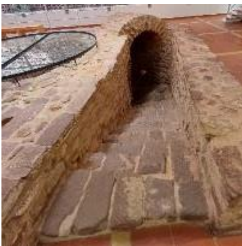
Zona de entrada para o Poço-Cisterna Almóada: blocos médios de grés de Silves ligados por argamassa de cal e areia. Fotografia do arquivo do SCR/CMS, 2024.
