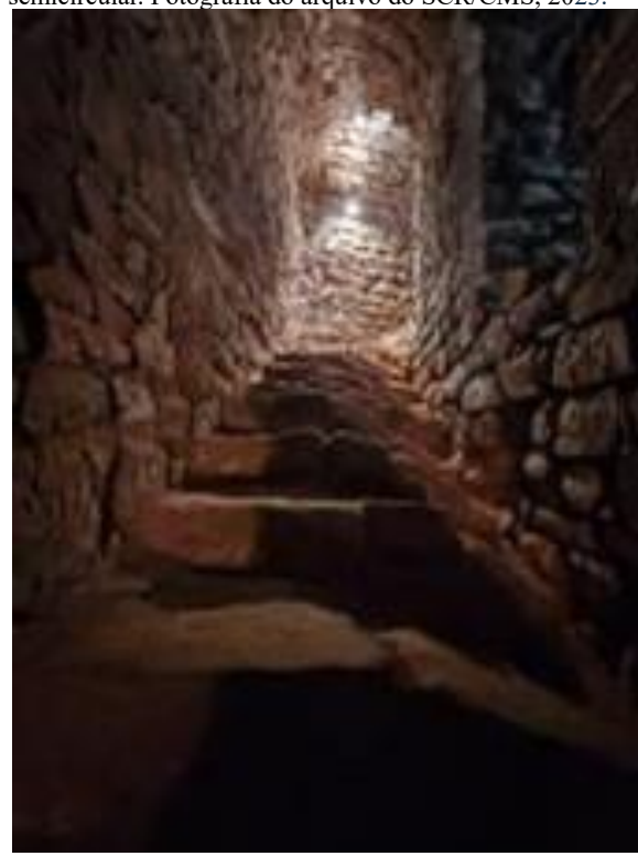
Galeria em espiral do 3º patamar formada por escadaria coberta por abóbadas de tramos segmentados e de perfil semicircular. Fotografia do arquivo do SCR/CMS, 2023.
