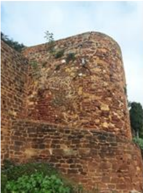
Torre 15 do tipo adossada construído em alvenaria ordinária. O embasamento de alvenaria realizado como reforço de sustentação de terras da encosta é rematado por um pequeno muro com a função de guarda-corpos. Fotografia do arquivo do SCR/CMS, 2023.
