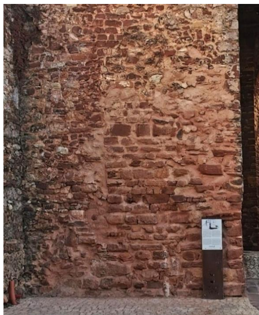
Figura 74: Após intervenção pontual de alçado da Porta da Almedina. Fotografia do arquivo do SCR/CMS, 2024.
