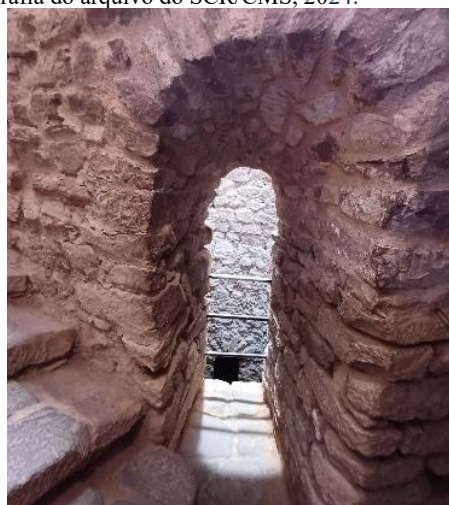
Janela do 1º patamar com abóbada de perfil semicircular, que faz ligação entre a galeria e o poço. Fotografia do arquivo do SCR/CMS, 2024.
