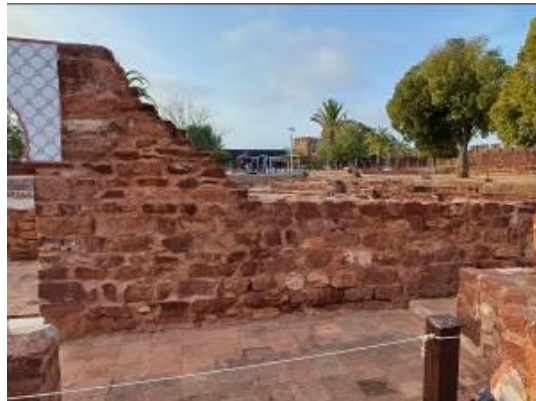
Ausência de argamassa na base do muro que coloca em risco o destacamento de elementos pétreos. O preenchimento de juntas continua mediante disponibilidade do SCR. Fotografias do arquivo do SCR/CMS, 2023 à esquerda e 2024 à direita.
