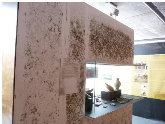
Figura 116: Proliferação de bolor na exposição junto às estruturas arqueológicas. Fotografia do arquivo do SCR/CMS, 2010.
