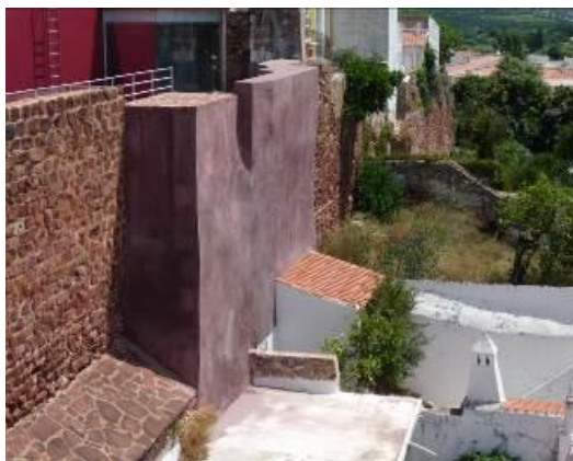
Aumento do destacamento pontual do reboco e e camada de tinta e presença de sais cristalizados à superfície. FotografiaS do arquivo do SCR/CMS, 2018 à esquerda e 2024 à direita.
