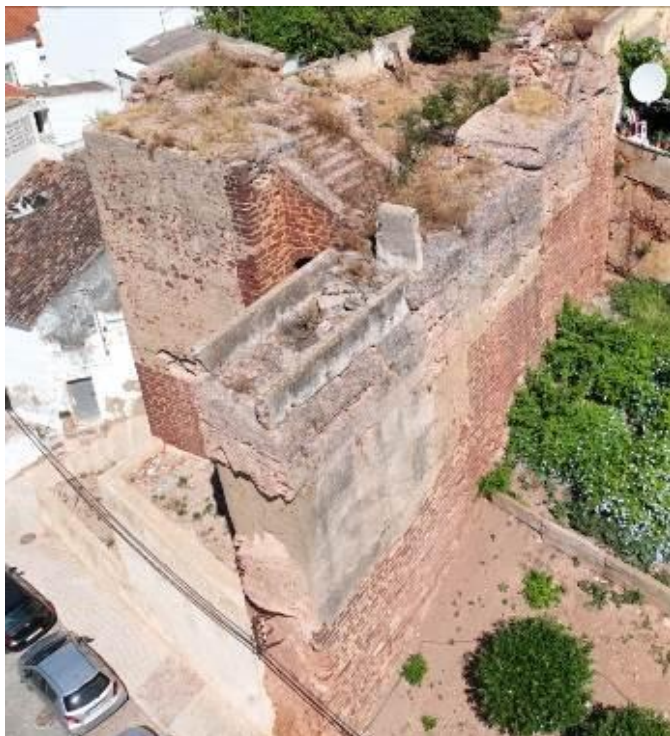
Tramo de muralha O1. Base em alvenaria aparelhada e revestido com argamassas à base de cal. Fotografia do arquivo do SCR/CMS, 2024.
