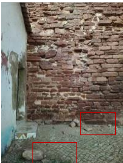
Destacamento de elementos pétreos. Zona com elevado risco de derrocada. Fotografia do arquivo do SCR/CMS, 2023.
