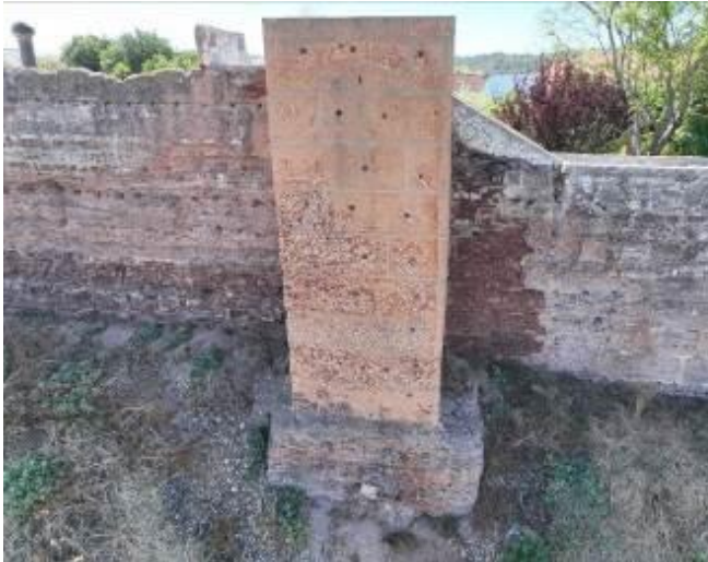
Torre 9 do tipo adossada revestida só com argamassa de cal na parte onde não existia estrutura e com argamassa de cal e brita a revestir a estrutura original. Observa-se a imitação de juntas com o revestimento. Fotografia do arquivo do SCR/CMS, 2024.
