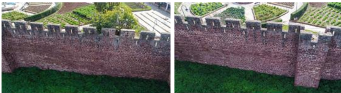
Fotos do alçado norte dos Tramos N11 e N12 – LEB, 2017.
