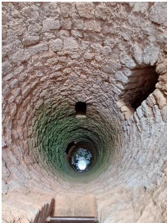
Poço construído com grés e argamassa de cal e terra. Estrutura circular com janelas semicirculares para a sua ventilação e iluminação. Fotografia do arquivo do SCR/CMS, 2024.
