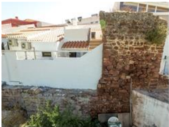
Torre 7 do tipo adossada construída em alvenaria aparelhada e ordinária com grés de Silves e argamassa de cal. Fotografia do arquivo do SCR/CMS, 2017.
