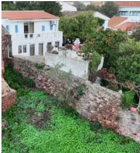
Fotografia do alçado norte do Tramo N4. Fotografia do arquivo do SCR/CMS, 2024.
