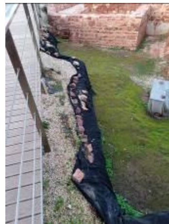
Rasgões e lacunas no geotêxtil e presença de vegetação. Fotografia do arquivo do SCR/CMS, 2024.
