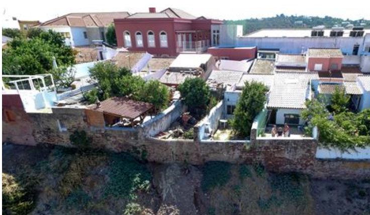
Tramos de muralhas N1, N2 e N3. Inseridos nas construções contemporâneas. Fotografia do arquivo do SCR/CMS, 2017.
