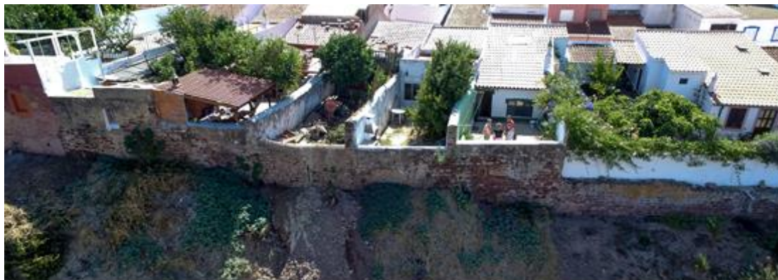
Foto com drone do Tramo N3 – LEB, 2017.
