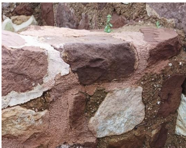
Argamassa de cal e areia de intervenção. Fotografia: autor, 2025.
