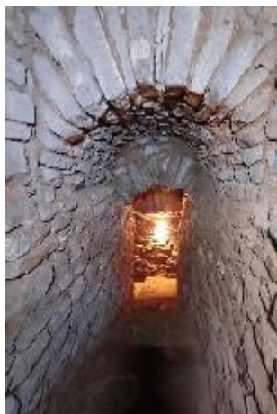
Abertura de juntas, pulverulência, arenização e fissuras nos elementos pétreos, sujidade superficial e presença pontual de sais. Fotografias do arquivo do SCR/CMS, 2024.
