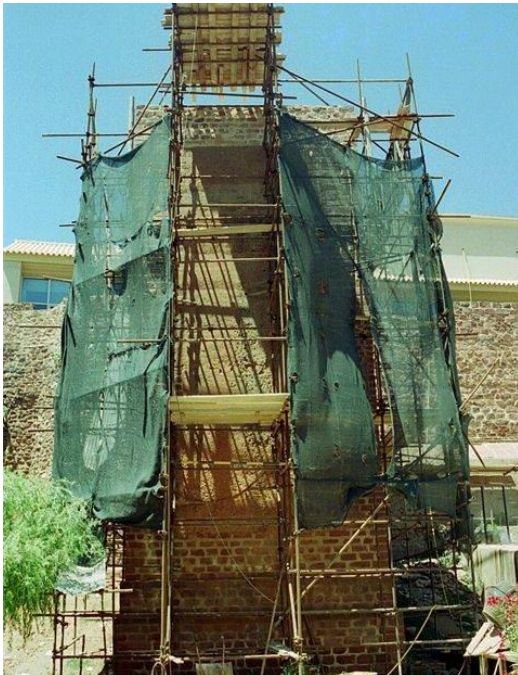
Figura 47: Torre 17 durante a segunda fase de reconstrução. Fotografia do arquivo da SIPA, 1985 - 1990.
