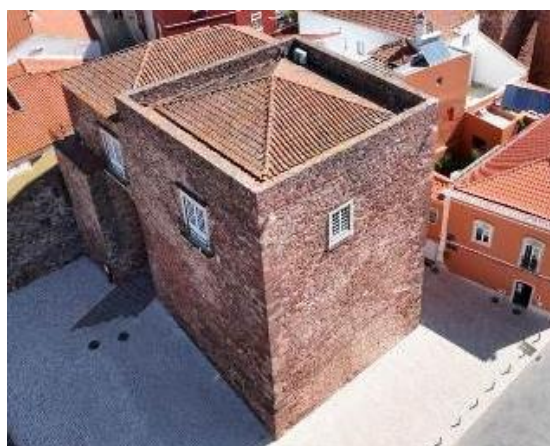
Figura 68: Registro aéreo do alçado poente e sul da Porta da Almedina de Silves. Fotografia do arquivo de SCR/CMS, 2024.
