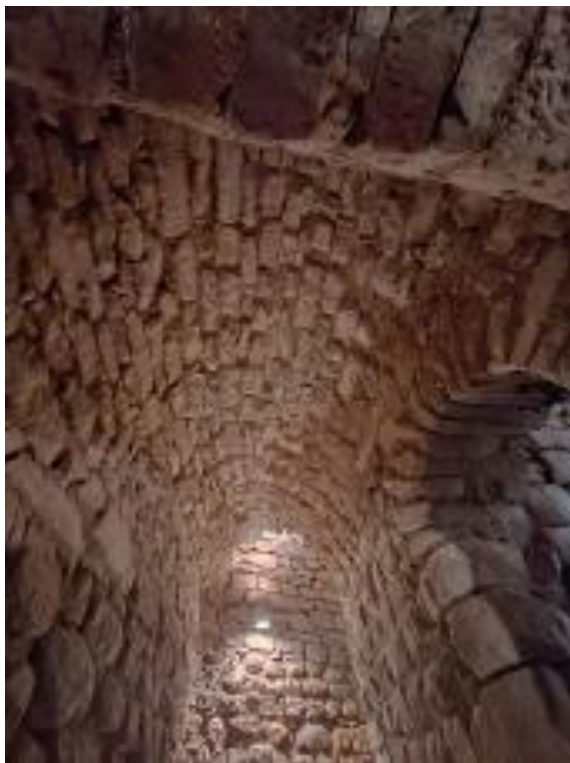
Parte superior coberta por abóbada de perfil semicircular com as pedras de arenito vermelho dispostas em cunha interligadas por argamassa de cal e terra. Fotografia do arquivo do SCR/CMS, 2023.
