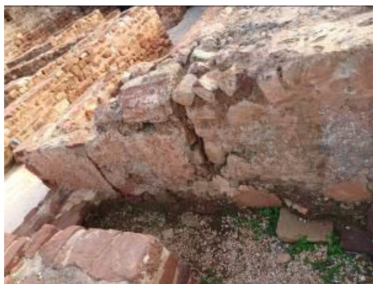
Destacamentos e lacunas da taipa. Fotografias do arquivo do SCR/CMS, 2024.
