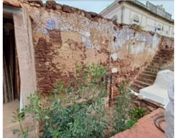
Fotografia do Tramo S11. Fotografia do arquivo do SCR/CMS, 2024.
