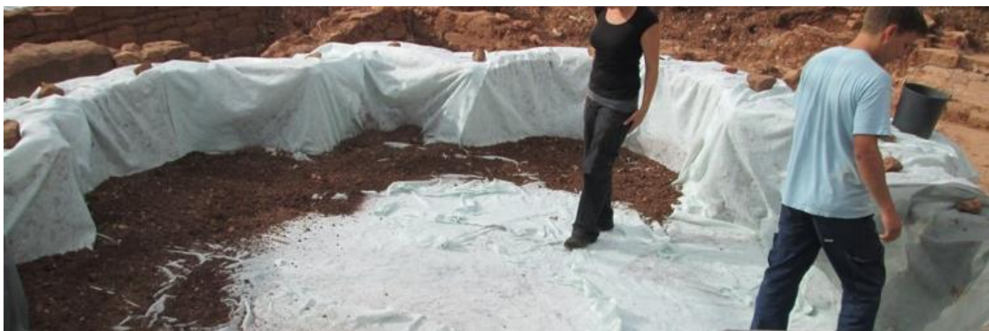
Figura 20: Reenterramento de estrutura arqueológica. Fotografia do arquivo de SA/CMS, 2013 – 2014.
