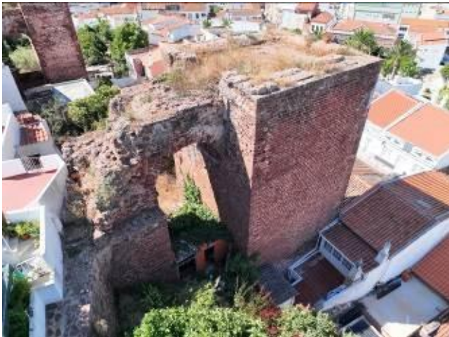
Torre 6 do tipo albarra construída com alvenaria aparelhada e ordinária com grés de Silves e argamassa de cal. Fotografia do arquivo do SCR/CMS, 2024.
