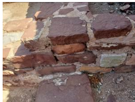
Abertura de juntas. Fotografias do arquivo do SCR/CMS, 2024.
