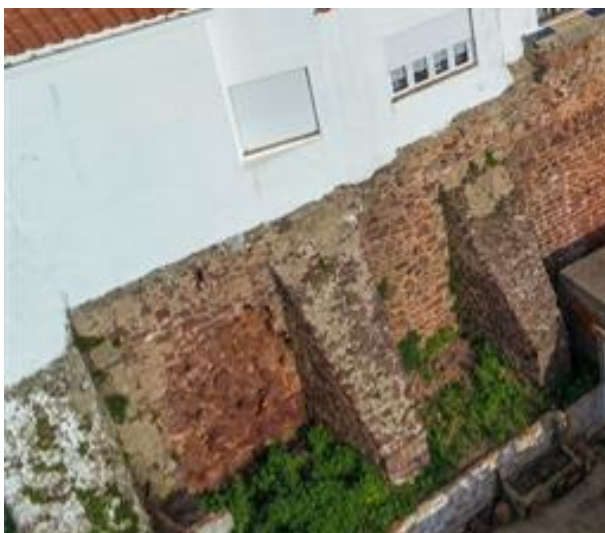
Fotografia do alçado poente do Tramo O5 – LEB, 2017.
