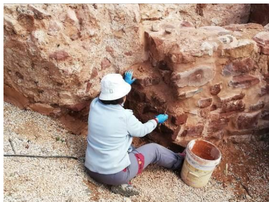
Figura 105: Rejuntamento de muro de alvenaria. Fotografia do arquivo do SCR/CMS, 2022.
