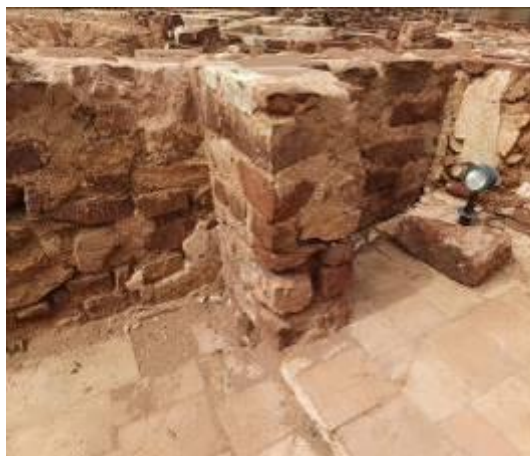
Preenchimento de juntas com argamassa à base de cal hidráulica natural NHL 3,5 (3:1) entre 04/06/2024 e 09/07/2024 pelo SCR. Fotografias do arquivo do SCR/CMS, 2024.
