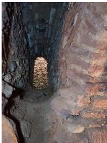
Vão 3. Elevada ausência de argamassas e depósitos decorrentes de arenização dos elementos pétreos e das argamassas de juntas. Fotografia do arquivo do SCR/CMS, 2024.
