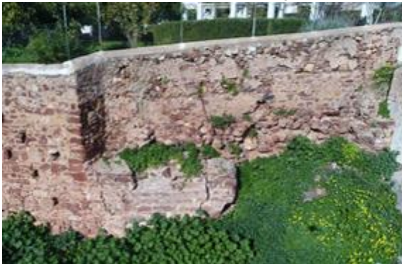
Fotografia do alçado sul do Tramo S1 – LEB, 2017.
