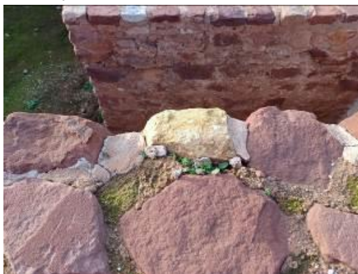
Risco e descolamento de argamassas. Fotografias do arquivo do SCR/CMS, 2024.
