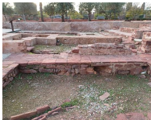
Abertura de juntas na alvenaria do Jardim e aumento da presença de colonização biológica. Fotografia do arquivo do SCR/CMS, 2024.
