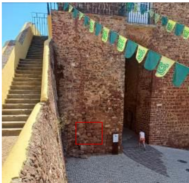
Destacamento de elementos pétreos na fachada poente que deverá ter ocorrido entre 02/08/2024 e 04/08/2024. Devido à localização na via pública e o início da Feira Medieval a 09/08/2024, o SCR procedeu à intervenção pontual urgente de conservação e restauro de 06/08/2024 a 08/08/2024. Fotografia do arquivo do SCR/CMS, 2024.
