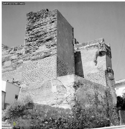
Figura 61: Torre 4 durante as obras realizadas pela DGEMN. Fotografia de 1964. Fotografia do arquivo do SIPA, década de 1930 - 1940. .
