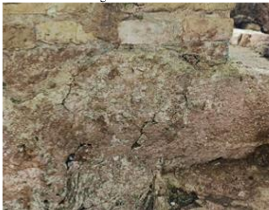
Ausência de argamassa e risco de destacamento de estuque. Fotografias do arquivo do SCR/CMS, 2024.
