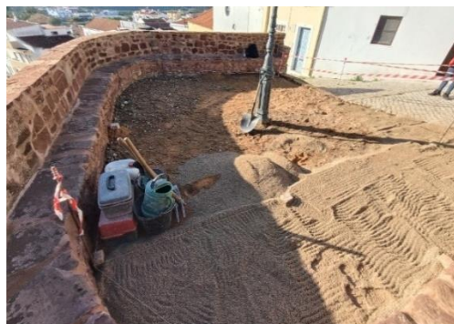
Figura 81: Repavimento da calçada com pendente a 2% para escoar as águas pluviais. Fotografia do arquivo do SCR/CMS, 2024.
