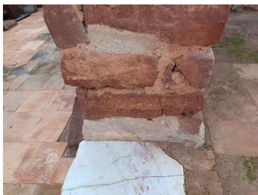
Ausência de argamassa na base do muro que coloca em risco o destacamento de elementos pétreos. O preenchimento de juntas continua mediante disponibilidade do SCR. Fotografias do arquivo do SCR/CMS, 2023 à esquerda e 2024 à direita.
