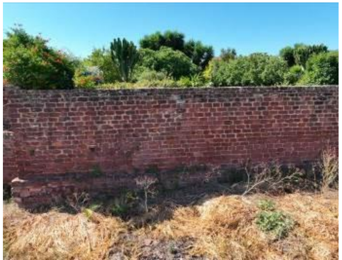
Reconstituição de tramo de muralha identificado como N10 construído com alvenaria aparelhada com grés de Silves e argamassa de cal. Fotografia do arquivo do SCR/CMS, 2024.
