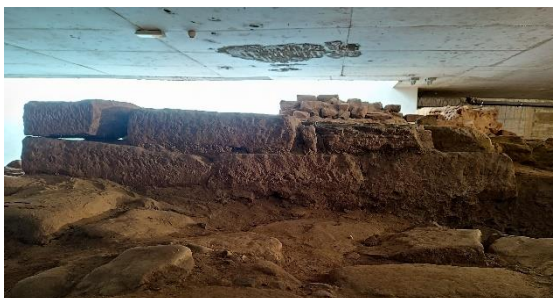
Reforço à torre poligonal . Fotografia do arquivo do SCR/CMS, 2024.
