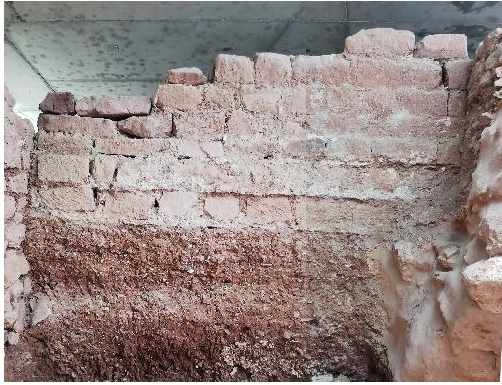
Alçado norte do reforço poligonal construído com grandes blocos de grés, aparelhados, com formas aproximadamente retangulares e quadrangulares ligados por uma argamassa de cal muito dura de cor amarela. Fotografia do arquivo do SCR/CMS, 2024.
