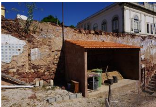
Continuação do tramo de muralha S11 . Fotografia do arquivo do SCR/CMS, 2017.
