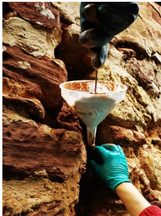
Figura 92: Injeção de argamassa fluída em fenda. Fotografia do arquivo de SCR/CMS, 2024.
