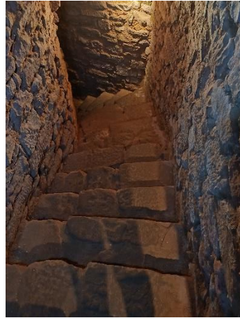
Abertura de juntas, pulverulência, arenização e fissuras nos elementos pétreos, sujidade superficial e presença pontual de sais. Fotografias do arquivo do SCR/CMS, 2024.
