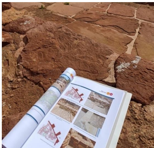
Figura 27: Comparação das patologias identificadas na monitorização anterior. Fotografia do arquivo do SCR/CMS, 2025.
