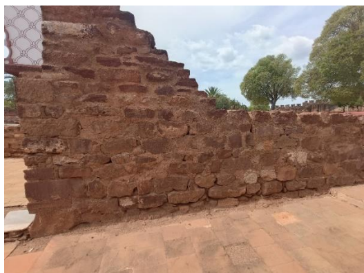
Ausência de argamassa na base do muro que coloca em risco o destacamento de elementos pétreos. O preenchimento de juntas continua mediante disponibilidade do SCR. Fotografias do arquivo do SCR/CMS, 2023 à esquerda e 2024 à direita.
