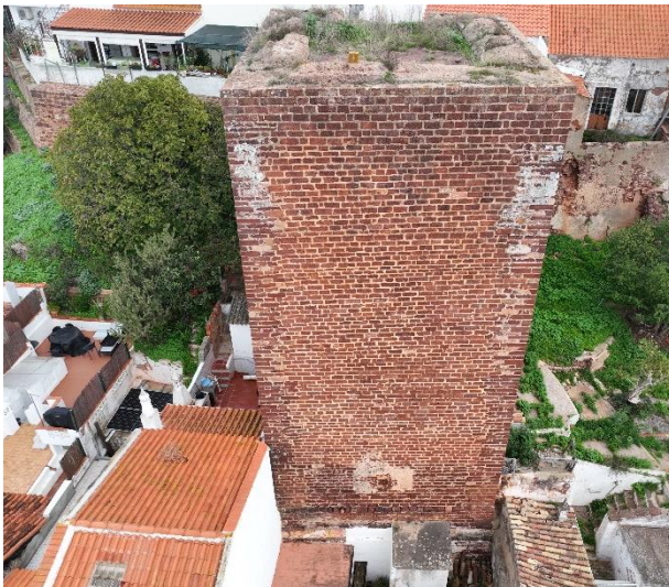
Fotografia do alçado poente da Torre 6. Fotografia do arquivo do SCR/CMS, 2023.
