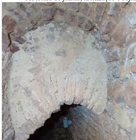
Abertura de juntas, pulverulência, arenização de elementos pétreos, sujidade superficial e presença pontual de sais. Fotografias do arquivo do SCR/CMS, 2024.
