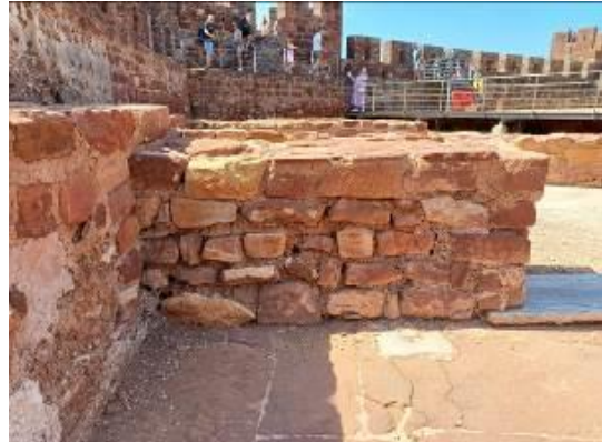
Abertura de juntas e diminuição da presença de colonização biológica. Fotografias do arquivo do SCR/CMS, 2023 à esquerda e 2024 à direita.
