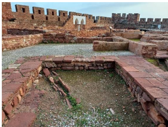
Abertura de juntas na alvenaria do Jardim e aumento da presença de colonização biológica. Fotografia do arquivo do SCR/CMS, 2024.
