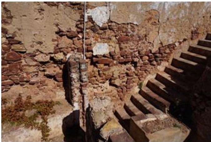
Fotografia do Tramo S11 – LEB, 2017.
