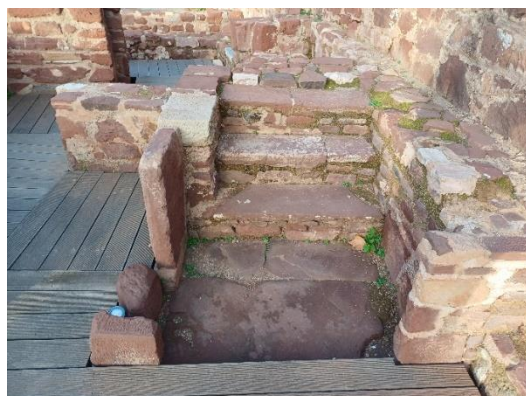
Abertura de juntas nas escadas e ligeiro aumento de colonização biológica. Fotografia do arquivo do SCR/CMS, 2024.
