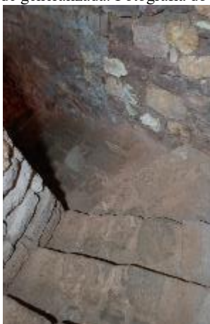
Abertura de juntas, pulverulência, arenização de elementos pétreos, sujidade superficial e presença pontual de sais. Fotografias do arquivo do SCR/CMS, 2024.
