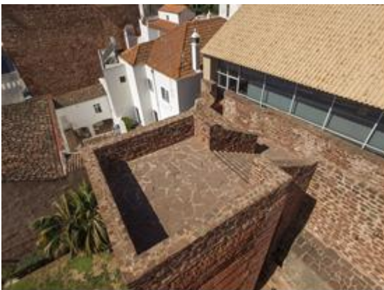
Fotografia com drone da Torre 17 – LEB, 2017.
