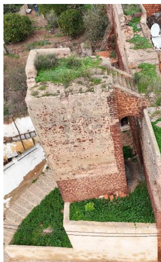
Fotografia do alçado sul da Torre 4. Situação mantém-se. Fotografia do arquivo do SCR/CMS, 2024.
