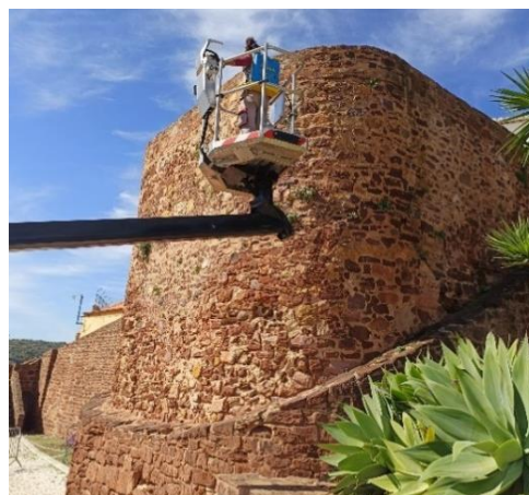
Figura 83: Aplicação de biocida sistémico. Fotografia do arquivo do SCR/CMS, 2023.
