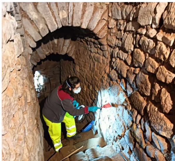
Figura 123: Limpeza mecânica. Fotografia do arquivo do SCR/CMS, 2024.
