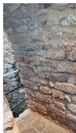
Vão 1. As patologias identificadas são sobretudo abertura de juntas, arenização dos elementos pétreos e argamassas, e sujidades diversas à superfície. Aparece estar estável estruturalmente. Fotografia do arquivo do SCR/CMS, 2024.
