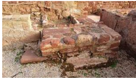
Ausência de argamassa e risco de destacamento de estuque. Fotografias do arquivo do SCR/CMS, 2023 à esquerda e 2024 à direita.
