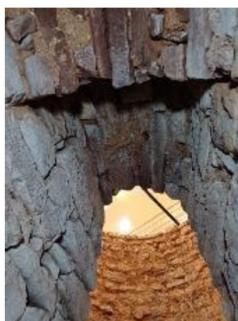
Vão 2. Elevada ausência de argamassas e depósitos decorrentes de arenização dos elementos pétreos e das argamassas de juntas. Fotografia do arquivo do SCR/CMS, 2024.
