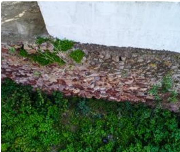
Fotografia do alçado norte do Tramo N4 – LEB, 2017.
