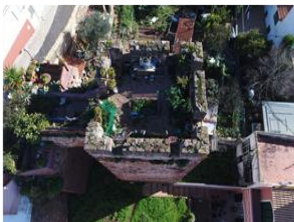
Fotografia com drone da Torre 5. Ocupação abusiva do proprietário – LEB, 2017.
