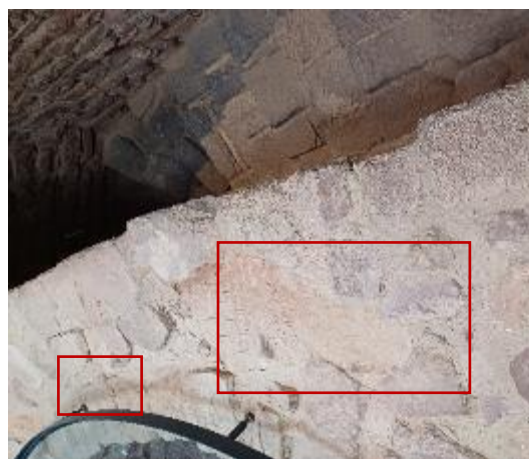
Intervenção de conservação e restauro em que foram assentes elementos pétreos e preenchidas juntas. A conclusão da intervenção aguarda disponibilidade do SCR. Fotografia do arquivo do SCR/CMS, 2024.
