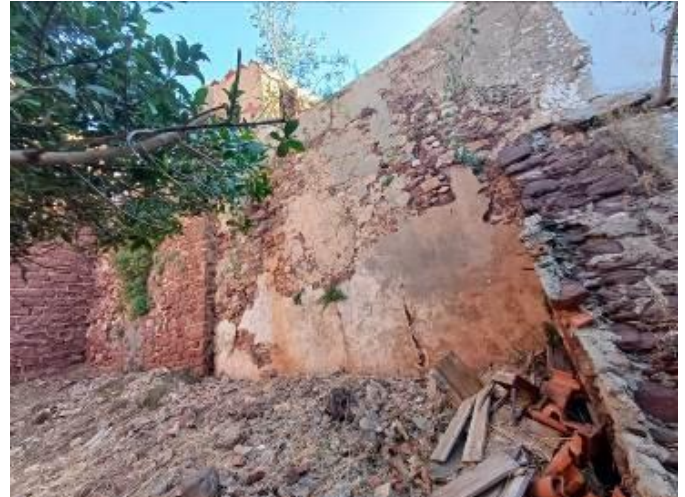
Tramo de muralha O5. Construído em alvenaria ordinária com grés de Silves e argamassa à base de cal e revestido com argamassa à base de cal. Fotografia do arquivo do SCR/CMS, 2024.
