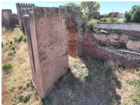
Figura 30: Torre albarra das Muralhas da Almedina. Fotografia do arquivo do SCR/CMS, 2024.
