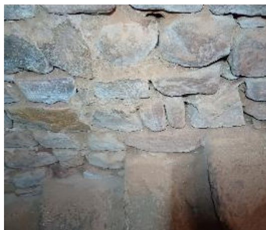
Abertura de juntas, arenização e sujidade generalizada. Fotografia do arquivo do SCR/CMS, 2024.
