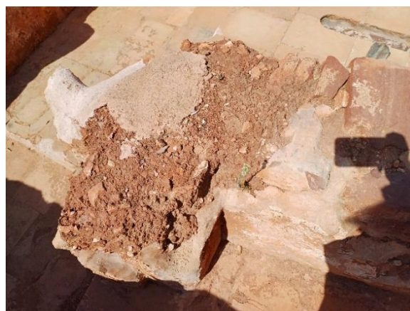
Vestígios de parede de taipa com vestígios de camada de sacrificio de intervenção . Fotografia: autor, 2025.
