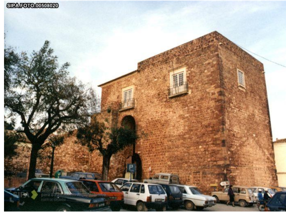
Figura 70: Porta da almedina sem reboco. Fotografia dos anos 80 do arquivo do SCR/CMS.
