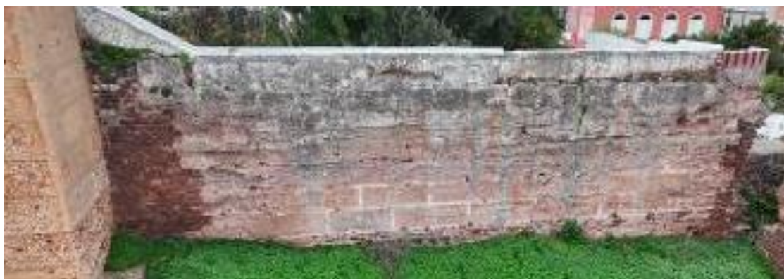
Fotografia com drone do Tramo N5. Fotografia do arquivo do SCR/CMS, 2024.
