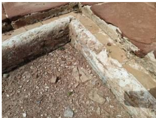
Fendas, fissuras, risco e destacamento do estuque e da argamassa de restauro e aumento da colonização biológica. Fotografias do arquivo do SCR/CMS, 2023 à esquerda e 2024 à direita.
