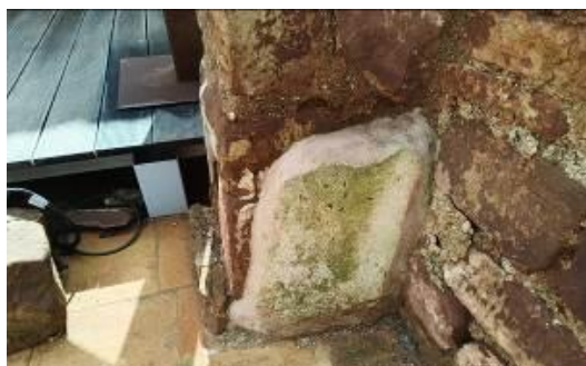
Diminuição da presença de colonização biológica. Fotografias do arquivo do SCR/CMS, 2023 à esquerda e 2024 à direita.
