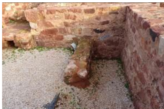
Foram executados trabalhos de conservação com argamassa à base cal hidráulica natural NHL 3,5 (3:1) entre 04/06/2024 e 09/07/2024 pelo SCR. Fotografias do arquivo do SCR/CMS, 2024.
