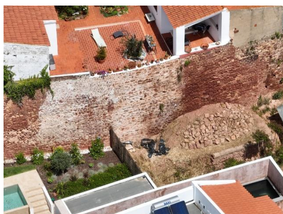
Figura 76: Paramentos de muralha após a intervenção. Fotografia aérea do arquivo de SCR/CMS, 2022.
