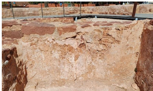
A base das paredes construída em pedra com blocos aparelhados de grés de Silves e rebocadas com argamassas à base de cal e areia e, posteriormente caiada com cor branca. Fotografia: autor, 2025.
