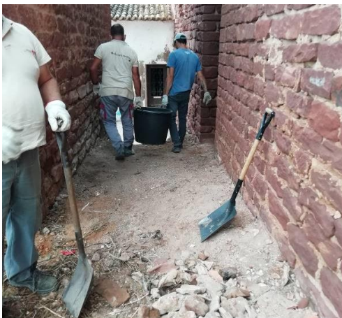
Figura 88: Limpeza de lixo acumulado junto a zonas de muralha. Fotografia do arquivo do SCR/CMS, 2021.
