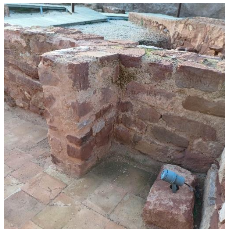
Preenchimento de juntas com argamassa à base de cal hidráulica natural NHL 3,5 (3:1) entre 04/06/2024 e 09/07/2024 pelo SCR. Fotografias do arquivo do SCR/CMS, 2024.
