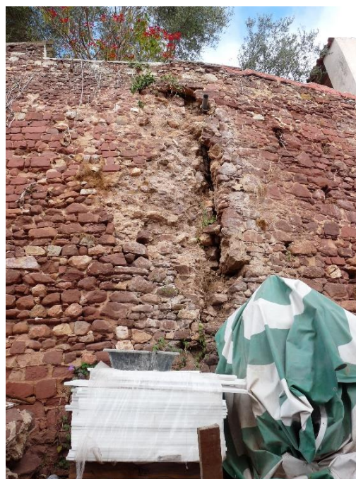
Figura 75: Fenda do logradouro da habitação Rua Portas de Loulé, n.º 34. Antes da intervenção. Fotografia do arquivo do SCR/CMS, 2021.
