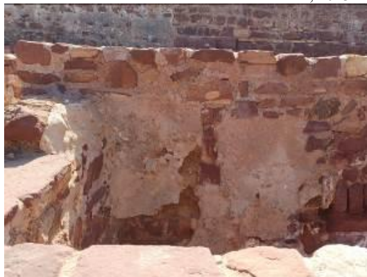
Risco e descolamento de argamassas. Fotografias do arquivo do SCR/CMS, 2024.
