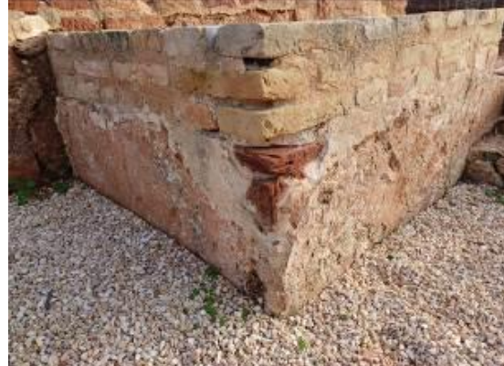
Ausência de argamassa e risco de destacamento de estuque. Fotografias do arquivo do SCR/CMS, 2024.
