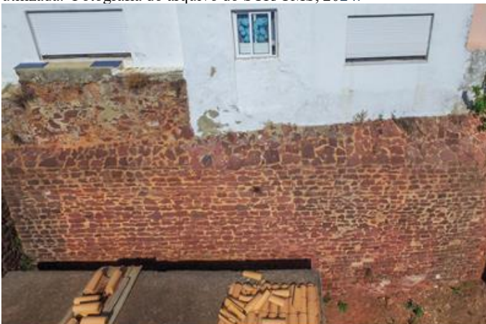
Tramo de muralha O5. Capeamento de muralha. Alvenaria ordinária com grés de Silves e argamassa à base de cal. Fotografia do arquivo do SCR/CMS, 2017.
