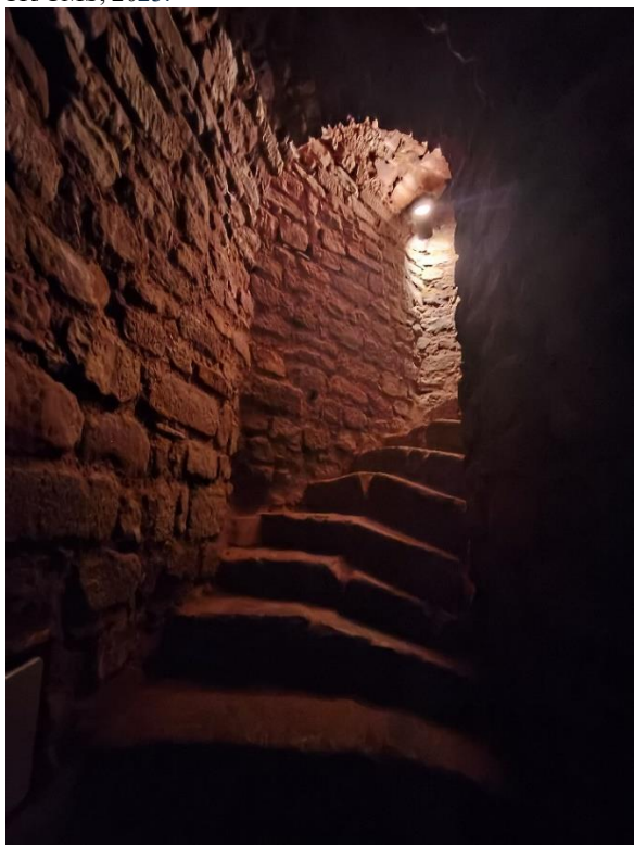
Galeria em espiral do último patamar formada por escadaria coberta por abóbadas de tramos segmentados e de perfil semicircular. Fotografia do arquivo do SCR/CMS, 2023.
