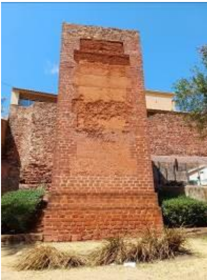
Torre 17. Torre musealizada. Grande parte desta estrutura foi reconstituída nos anos 90 pela equipa coordenada pelos arqueólogos Mário e Rosa Varela Gomes. A torre 17, do tipo albarrã, destaca-se do alinhamento da muralha, sendo constituída originalmente no seu interior em taipa e alvenaria de pedra aparelhada no seu capeamento. Fotografia do arquivo do SCR/CMS, 2024
