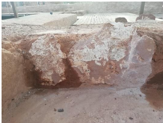
Figura 113: Aspeto final após intervenção. Fotografia do arquivo do SCR/CMS, 2022.
