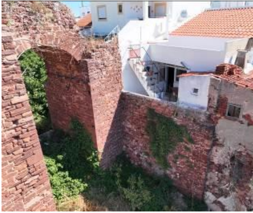
Fotografias do alçado poente do Tramo O5. Abertura de juntas, desagregação da argamassa, presença elevada de colonização biológica e lacunas na alvenaria de pedra. EC5 . Fotografia do arquivo do SCR/CMS, 2024.
