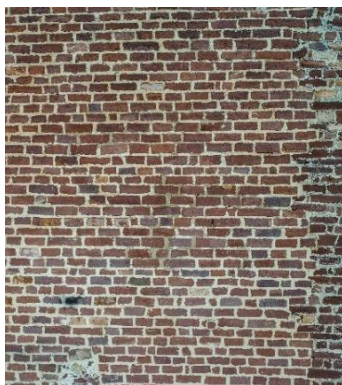
Figura 39: Alvenaria aparelhada de alçado de torre 6 com um padrão regular entre fiadas. Fotografia do arquivo do SCR/CMS, 2017.
