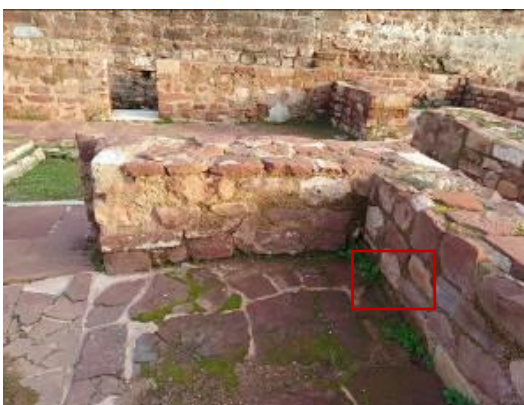
Ausência de argamassa na base do muro. Aumento pontual da desagregação da argamassa. Fotografias do arquivo do SCR/CMS, 2023 à esquerda e 2024 à direita.
