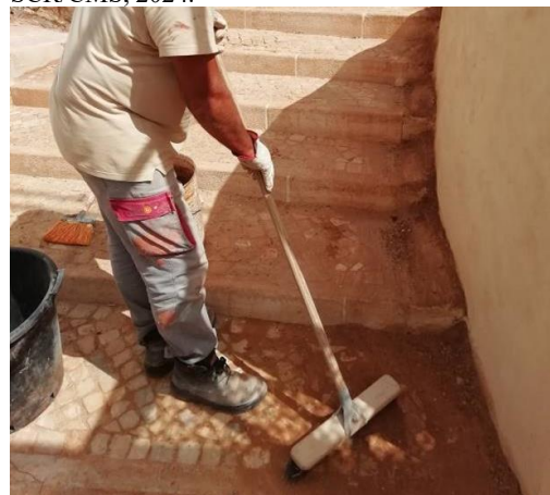
Figura 89: Limpeza da calçada inserida na área de proteção das muralhas. Fotografia do arquivo de SCR/CMS, 2021.
