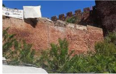
Figura 85: Após aplicação de herbicida e corte de figueira do tramo de muralha. Fotografia do arquivo do SCR/CMS, 2024.
