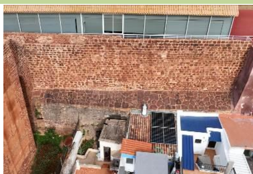
Fotografia do Tramo S9. Fotografia do arquivo do SCR/CMS, 2024.
