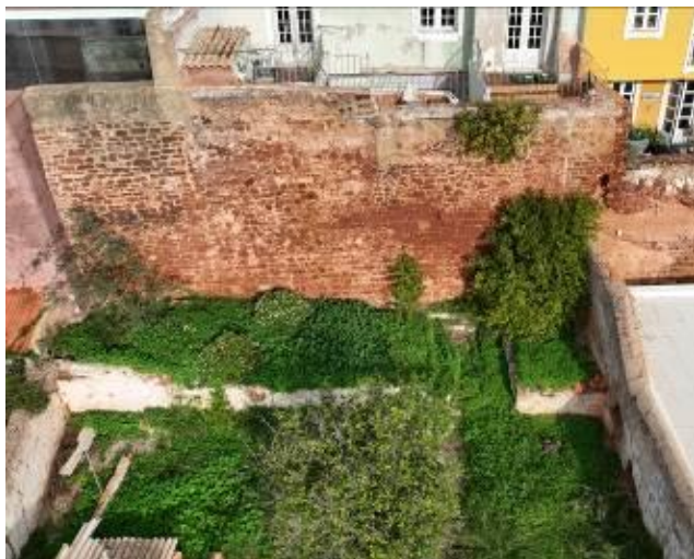
Fotografia do Tramo S8. Fotografia do arquivo do SCR/CMS, 2024.
