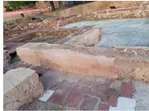
Desmoronamento parcial do capeamento identificado em abril de 2024. Foi efetuada a consolidação com silicato de etilo por pincelagem, injeção de cal inject e aplicação de camada de sacrifício com argamassa à base cal hidráulica (3:1). Fotografias do arquivo do SCR/CMS, 2004.
