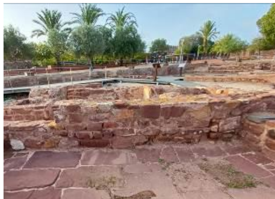
Ausência de argamassa na base da estrutura. Fotografia do arquivo do SCR/CMS, 2024.
