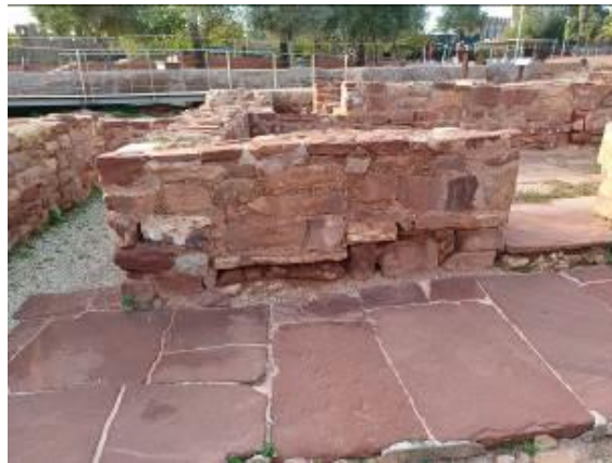
Abertura de juntas e risco de destacamento de elementos pétreos. Fotografia do arquivo do SCR/CMS, 2024.
