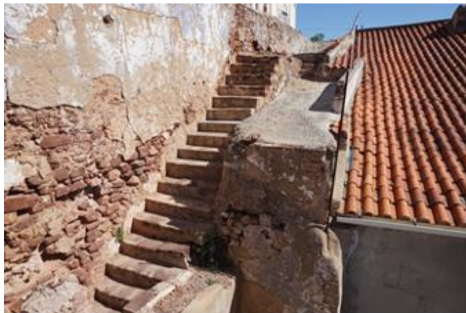
Fotografia do Tramo S11 – LEB, 2017.
