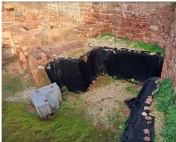
Rasgões e lacunas no geotêxtil e presença de vegetação. Fotografia do arquivo do SCR/CMS, 2024.
