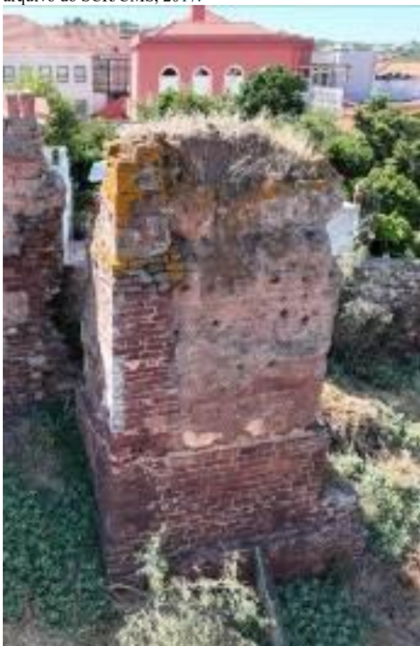
Torre 8 do tipo albarrã construída na base e limites com alvenaria aparelhada e no seu interior com taipa. Fotografia do arquivo do SCR/CMS, 2024.
