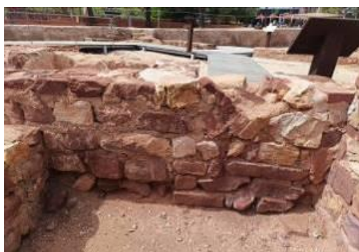
Abertura de juntas que resultam no risco de destacamento de elementos pétreos na área inferior esquerda e colonização biológica na fotografia à direita. Surgimento de elementos pétreos de local desconhecido no chão. Fotografias do arquivo do SCR/CMS, 2023 à esquerda e 2024 à direita.
