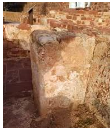
Pulverulência pontual de estuques e trabalhos de conservação inacabados. Fotografias do arquivo do SCR/CMS, 2024.
