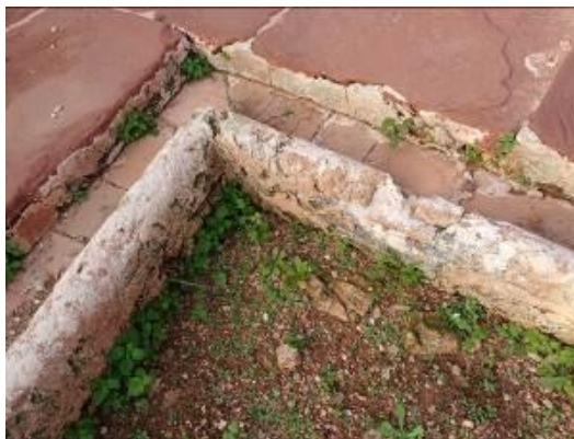
Fendas, fissuras, risco e destacamento do estuque e da argamassa de restauro e aumento da colonização biológica. Fotografias do arquivo do SCR/CMS, 2023 à esquerda e 2024 à direita.
