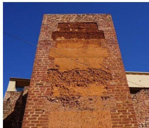
Figura 50: Torre 17 janelas recriadas com a reconstituição volumétrica da torre com o objetivo museológico de demonstrar os diferentes estratos da estrutura. Fotografia: autor, 2024.
