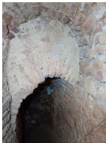
Abertura de juntas e arenização. Fotografia do arquivo do SCR/CMS, 2024.
