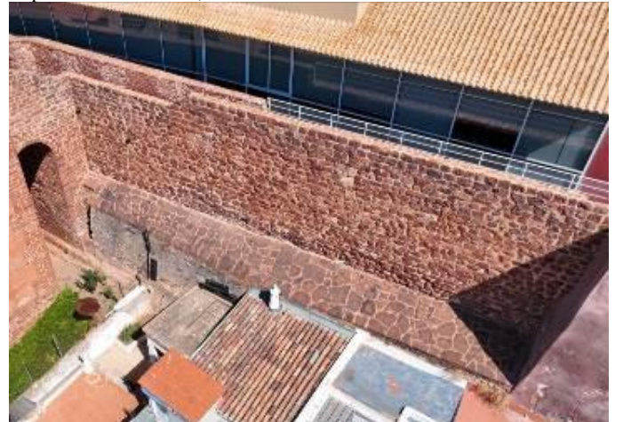
Tramo de muralha S9. Reconstituição volumétrica da continuidade da muralha. Fotografia do arquivo do SCR/CMS, 2024.
