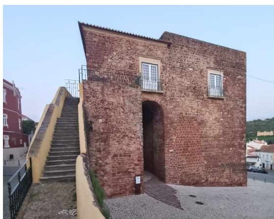
Figura 67: Registro fotográfico do alçado poente da Porta da Almedina de Silves. Fotografia: autor, 2025.
