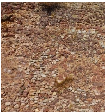
Figura 38: Alvenaria ordinária em tramo de muralha do sector sul (S9). Fotografia do arquivo do SCR/CMS, 2017.
