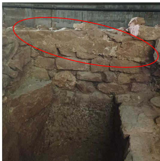
Parte do alçado norte do tramo A que serviu de apoio para a construção de uma das paredes da casa 3 , comprovado pelos vestígios de reboco. Fotografia do arquivo do SCR/CMS, 2024.
