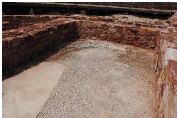
Pavimento com argamassa de cal original do lado esquerdo e brita, areia e terra do lado direito. Fotografia: autor, 2025.
