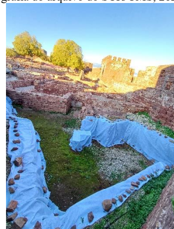
O SCR procedeu à substituição geral do geotêxtil a 10/12/2024. Fotografia do arquivo do SCR/CMS, 2024.
