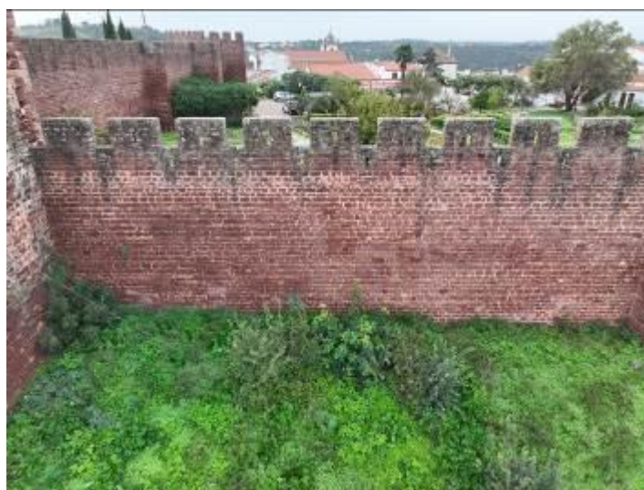
Fotografia do alçado norte dos Tramos N11 e N12. Fotografia do arquivo do SCR/CMS, 2024.
