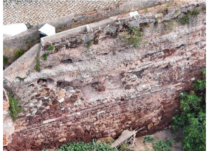
Taipa do tramo de muralha O2 . Fotografia do arquivo do SCR/CMS, 2025.
