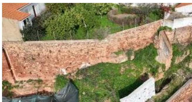
Fotografia do alçado sul do Tramo S2. Fotografia do arquivo do SCR/CMS, 2024.
