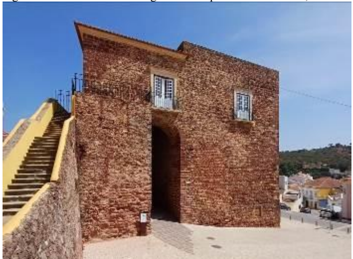
Porta da Almedina ou Torre 1. Torre construída em alvenaria aparelhada e ordinária com grés de Silves e argamassa à base de cal. Fotografia do arquivo do SCR/CMS, 2024
