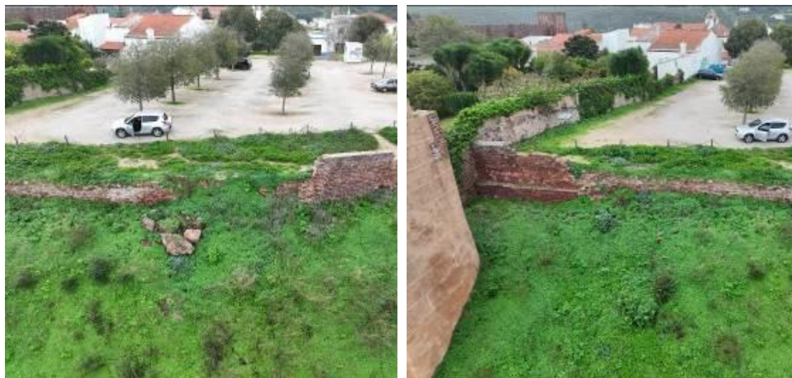
Fotografias com drone do Tramo N8. Situação mantém-se. Fotografia do arquivo do SCR/CMS, 2024.
