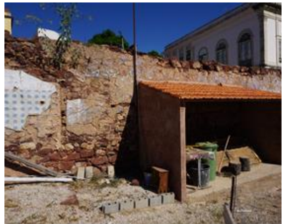
Fotografia do Tramo S11 – LEB, 2017.
