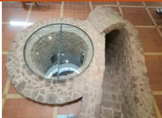
Parte superior do Poço-Cisterna: lajes e blocos médios de grés de Silves ligados por argamassa de cal e areia. Fotografia do arquivo do SCR/CMS, 2024.
