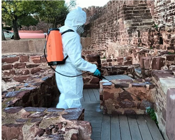
O SCR procedeu à aplicação geral de biocida a 11/12/2024. Fotografia do arquivo do SCR/CMS, 2024.
