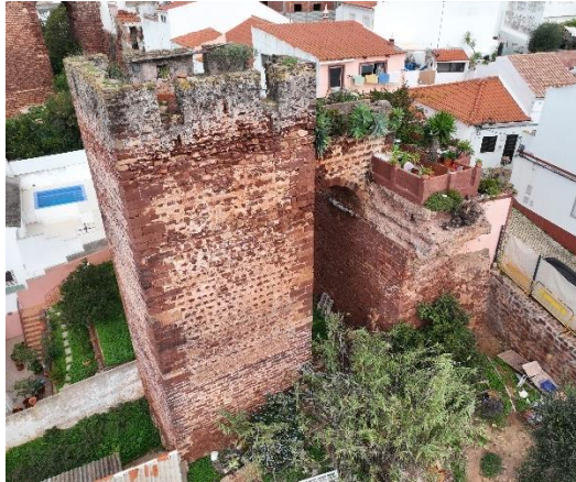
Fotografia do alçado sul da Torre 5. Fotografia do arquivo do SCR/CMS, 2024.
