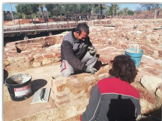
Figura 104: Rejuntamento de muro de alvenaria. Fotografia do arquivo do SCR/CMS, 2019.
