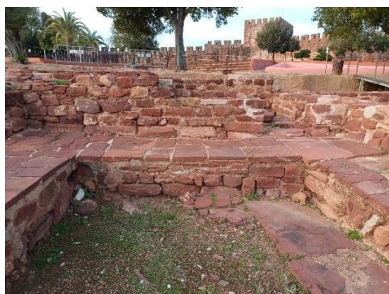
Abertura de juntas na alvenaria do Jardim e aumento da presença de colonização biológica. Fotografia do arquivo do SCR/CMS, 2024.
