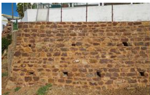
Fotografia do alçado poente do Tramo O6 – LEB, 2017.
