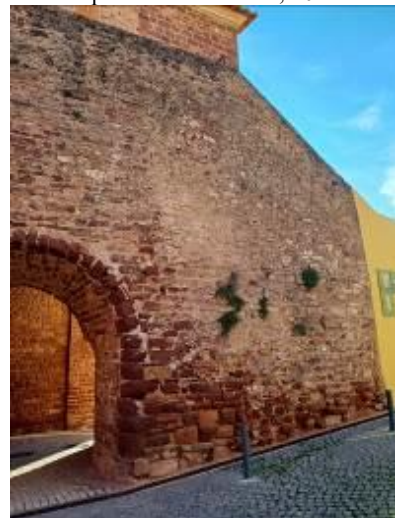
Alçado norte: ausência das juntas e dos elementos pétreos, alveolização, pulverulência das juntas e dos elementos pétreos, risco e destacamento de elementos pétreos e plantas superiores. Fotografia do arquivo do SCR/CMS, 2024.
