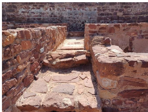
Corredor com as paredes laterais em alvenaria e o pavimento com lajes de grés de Silves. Fotografia: autor, 2025.
