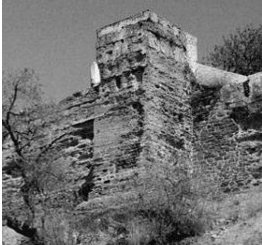
Figura 41: Torre 9 antes da campanha de intervenção da DGEMN no sector norte. Fotografia no arquivo do SIPA, década de 1930 - 1940.
