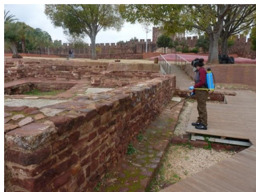
Figura 96: Aplicação de biocida sistémico. Fotografia do arquivo do SCR/CMS, 2017.
