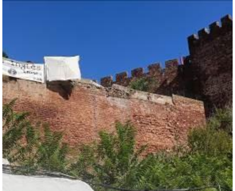
Tramo de muralha do sector este construído em alvenaria ordinária e aparelhada com grés de Silves e argamassa de cal. Fotografia do arquivo do SCR/CMS, 2024.
