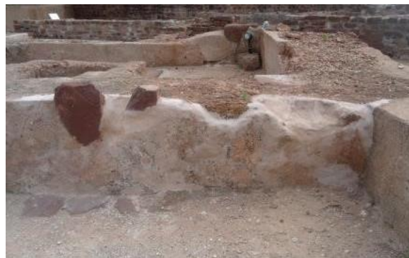
Figura 103: Depois da intervenção. Fotografia do arquivo do SCR/CMS, 2014.
