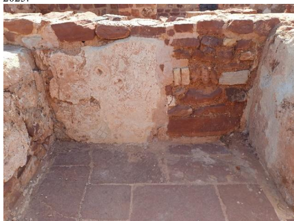
A base das paredes construída em pedra com blocos aparelhados de grés de Silves e rebocadas com argamassas de cal e areia fina e, posteriormente caiada com cor branca. O pavimento é coberto com lajes de grés de Silves. Fotografia: autor, 2025.
