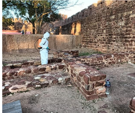
O SCR procedeu à aplicação geral de biocida a 11/12/2024. Fotografia do arquivo do SCR/CMS, 2024.
