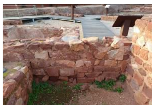
Abertura de juntas que resultam no risco de destacamento de elementos pétreos na área inferior esquerda e colonização biológica na fotografia à direita. Surgimento de elementos pétreos de local desconhecido no chão. Fotografias do arquivo do SCR/CMS, 2023 à esquerda e 2024 à direita.
