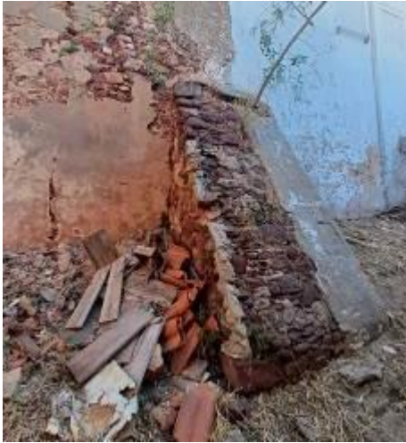
Contraforte construído com alvenaria ordinária em grés de Silves e argamassa de cal. Fotografia do arquivo do SCR/CMS, 2024.
