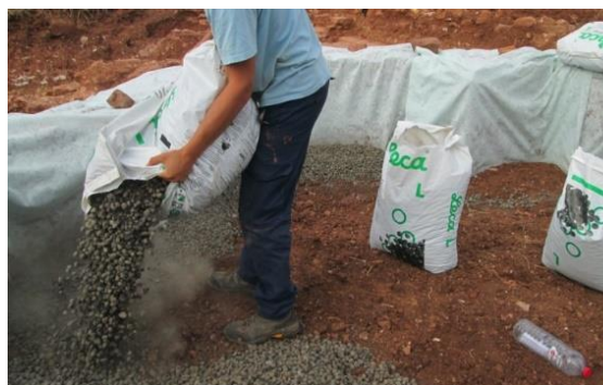
Figura 22: Utilização de agregado inorgânico após a aplicação de camada de terra. Fotografia do arquivo de SA/CMS, 2013 – 2014.
