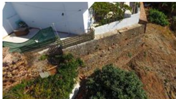
Fotografia do alçado poente do Tramo O7 – LEB, 2017.
