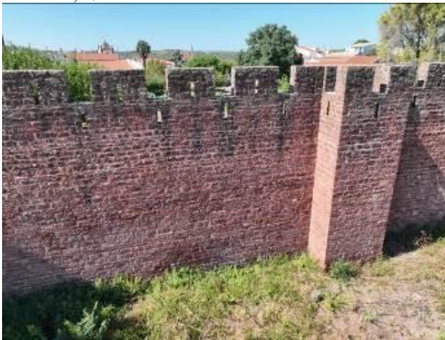
Tramo de muralha N11 e N12. Construído em alvenaria aparelhada com grés de Silves e argamassa de cal. Fotografia do arquivo do SCR/CMS, 2024.
