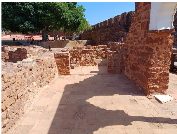
Bases das paredes em alvenaria de grés e pavimento em ladrilhos de cor bege. Fotografia: autor, 2025.
