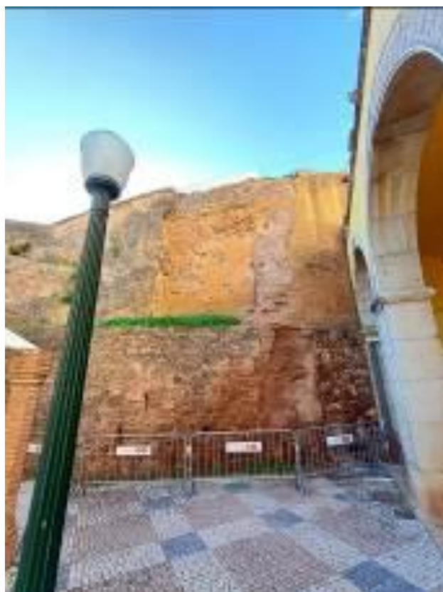
Colocação de baias a 08/2024 para proteção dos trauntes devido a fissura e destacamento de elementos pétreos e taipa. Fotografia do arquivo do SCR/CMS, 2023.
