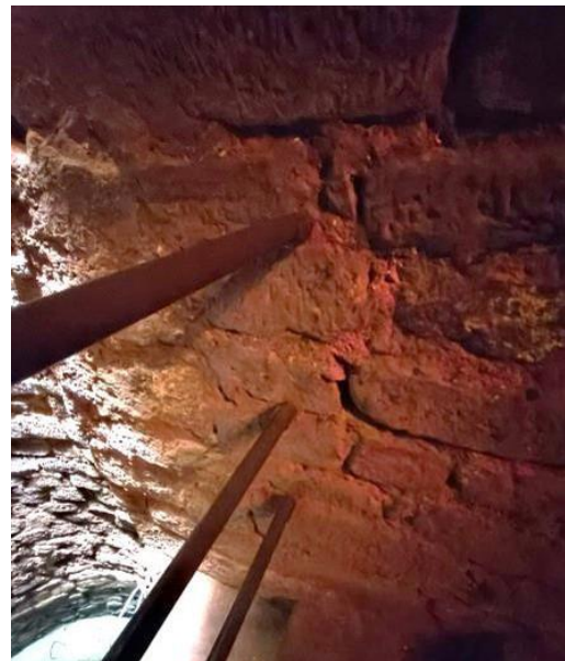
Figura 122: 3 barras de alumínio amovíveis fixas com parafuso e porca a suportes do mesmo material, colocadas nas juntas das pedras. Fotografia do arquivo do SCR/CMS, 2023.
