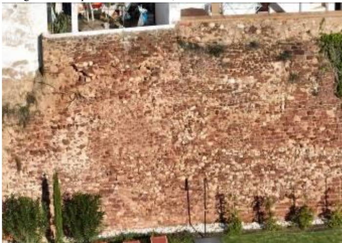
Tramo de muralha S5. Capeamento da muralha original. Alvenaria ordinária com grés de Silves e argamassa à base de cal. Fotografia do arquivo do SCR/CMS, 2023.
