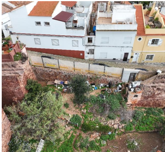
Fotografia do alçado poente dos Tramos O3 e O4. Situação mantém-se. Fotografia do arquivo do SCR/CMS, 2024.
