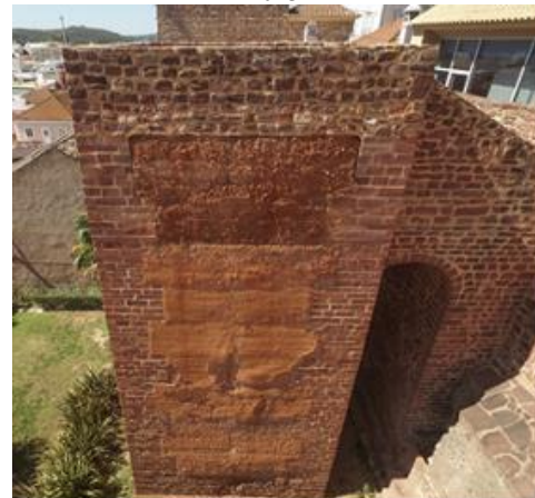
Fotografia do alçado nascente da Torre 17 – LEB, 2017.
