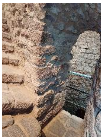
Vão 1. As patologias identificadas são sobretudo abertura de juntas, arenização dos elementos pétreos e argamassas, e sujidades diversas à superfície. Aparece estar estável estruturalmente. Fotografia do arquivo do SCR/CMS, 2024.
