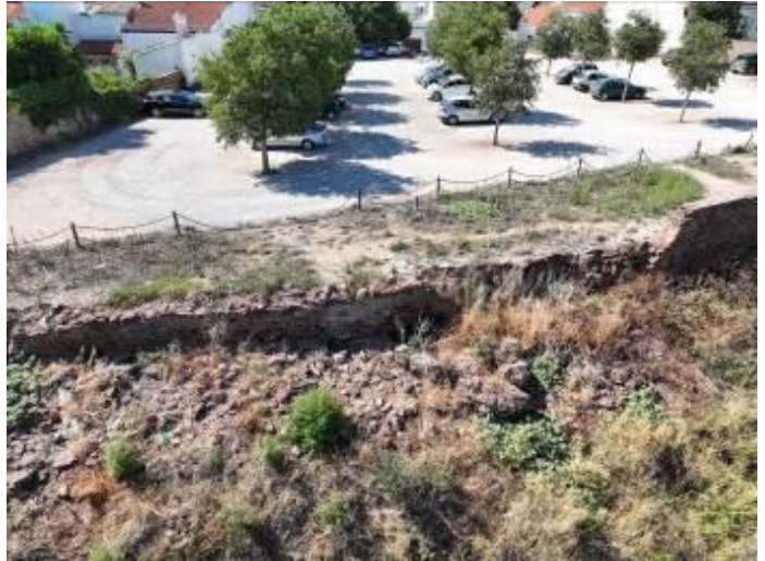
Vestígios do muro de alvenaria que dava continuidade à muralha. Fotografia do arquivo do SCR/CMS, 2024.
