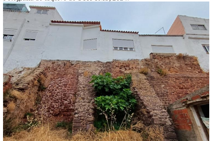
Continuação do tramo O5 com a presença de contrafortes. Alvenaria ordinária com grés de Silves e argamassa à base de cal. Os contrafortes encontram-se revestidos. Fotografia do arquivo do SCR/CMS, 2024.
