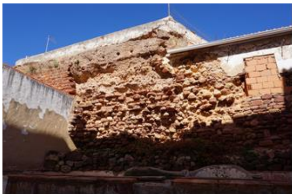
Fotografia da Torre 3 – LEB, 2017.
