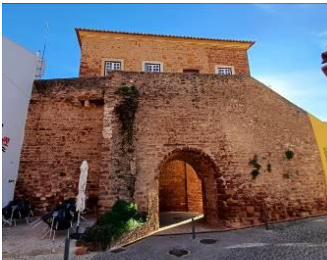
Alçado norte: ausência das juntas e dos elementos pétreos, alveolização, pulverulência das juntas e dos elementos pétreos, risco e destacamento de elementos pétreos e plantas superiores. Fotografia do arquivo do SCR/CMS, 2024.
