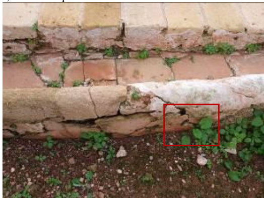
Fendas, fissuras, risco e destacamento do estuque e da argamassa de restauro. Ligeiro aumento pontual das fissuras e consequente risco de destacamento. Fotografias do arquivo do SCR/CMS, 2023 à esquerda e 2024 à direita.
