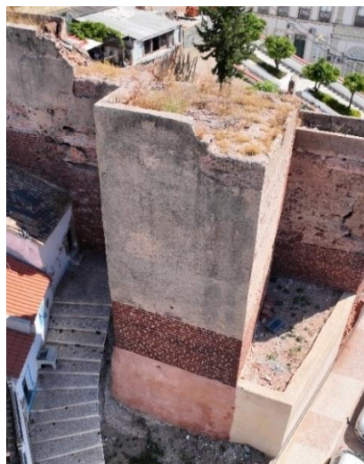
Figura 59: Torre 4, tramos O1 e O2 e muro adjacente através de fotografia aérea. Fotografia do arquivo de SCR/CMS, 2024
