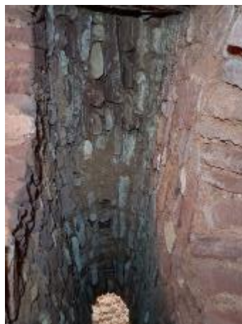
Vão 3. Elevada ausência de argamassas e depósitos decorrentes de arenização dos elementos pétreos e das argamassas de juntas. Fotografia do arquivo do SCR/CMS, 2024.
