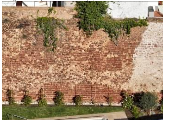
Tramo de muralha de S6. Capeamento da muralha original. Alvenaria ordinária com Grés de Silves e argamassa à base de cal. Fotografia do arquivo do SCR/CMS, 2023.
