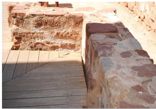
Figura 107: Depois da manutenção do muro de alvenaria. Fotografia do arquivo do SCR/CMS, 2016.
