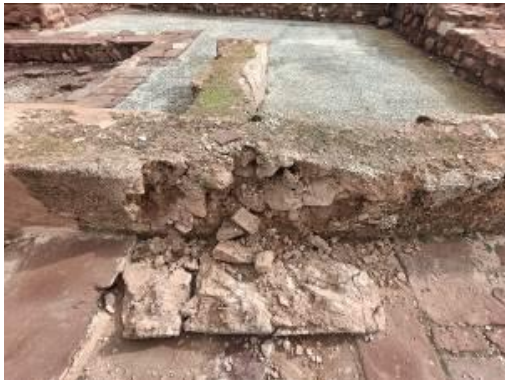
Desmoronamento parcial do capeamento identificado em abril de 2024. Foi efetuada a consolidação com silicato de etilo por pincelagem, injeção de cal inject e aplicação de camada de sacrifício com argamassa à base cal hidráulica (3:1). Fotografias do arquivo do SCR/CMS, 2004.
