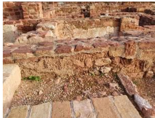
Ausência de argamassa. Fotografias do arquivo do SCR/CMS, 2023 à esquerda e 2024 à direita.
