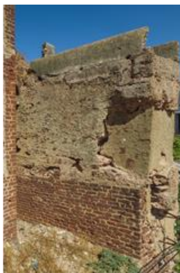
Fotografia do alçado poente do Tramo O1 – LEB, 2017.
