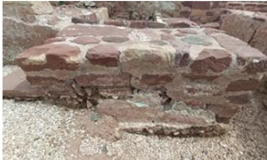
Ausência de argamassa e risco de destacamento de estuque. Fotografias do arquivo do SCR/CMS, 2023 à esquerda e 2024 à direita.
