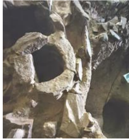
Fossa com uma boca tendencialmente circular, construída com blocos de grés, unidos por argamassa de cal. As paredes encontram-se revestidas com elementos pétreos de menor dimensão de grés e calcário não aparelhados. Fotografia do arquivo do SCR/CMS, 2024.
