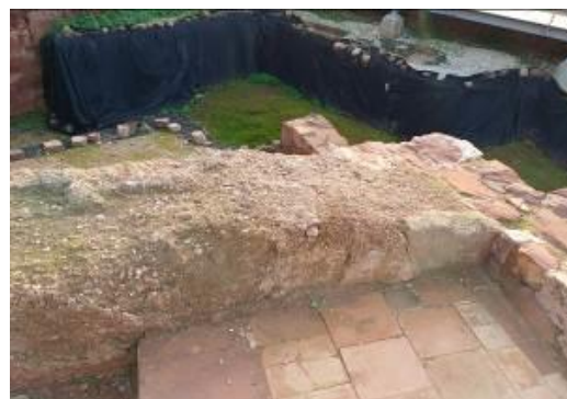
Fissuras, risco e descolamento de argamassas de sacrifício e pulverulência da taipa. Fotografias do arquivo do SCR/CMS, 2023 à esquerda e 2024 à direita.
