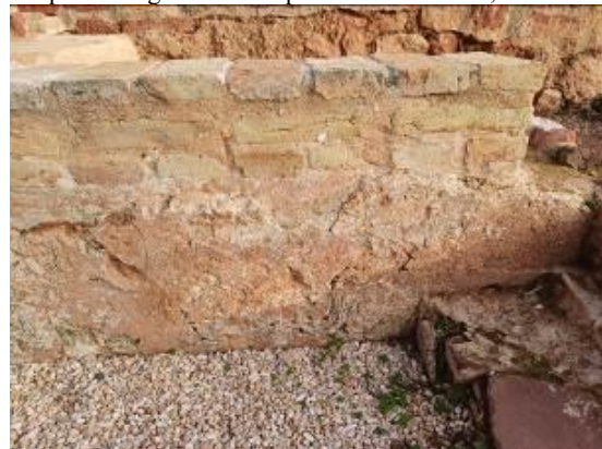
Ausência de argamassa e risco de destacamento de estuque. Fotografias do arquivo do SCR/CMS, 2024.
