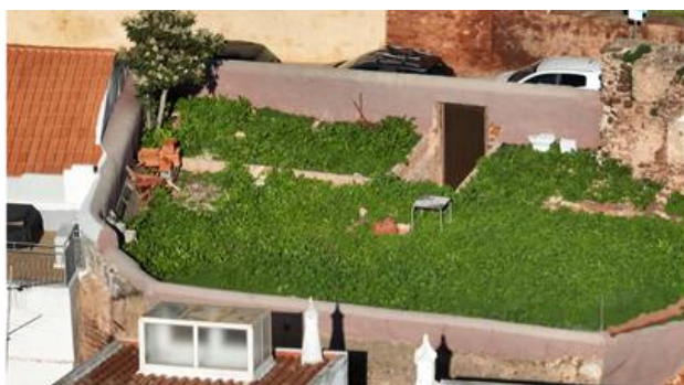
Fotografia do topo da Torre 3. Fotografia do arquivo do SCR/CMS, 2023.
