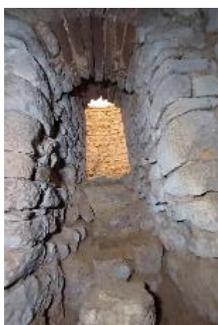
Vão 2. Elevada ausência de argamassas e depósitos decorrentes de arenização dos elementos pétreos e das argamassas de juntas. Fotografia do arquivo do SCR/CMS, 2024.
