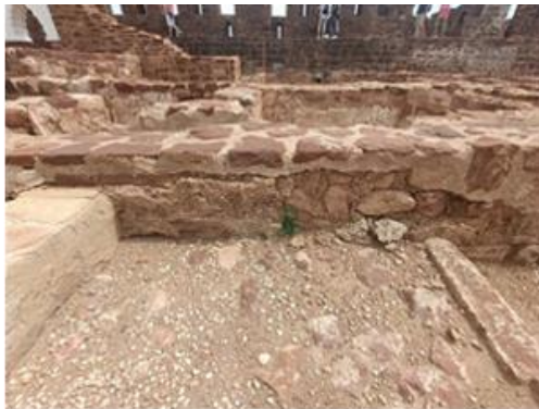
Ausência de argamassa. Fotografias do arquivo do SCR/CMS, 2023 à esquerda e 2024 à direita.
