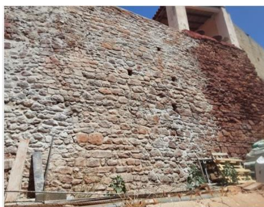
Figura 77: Após a intervenção da ligação entre os alçados identificados como S3 e S4. Fotografia aérea do arquivo de SCR/CMS, 2022.
