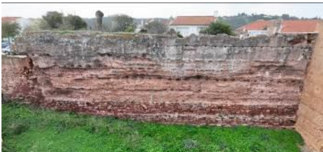
Fotografia do alçado norte do Tramo N6. Situação mantém-se. Fotografia do arquivo do SCR/CMS, 2024.
