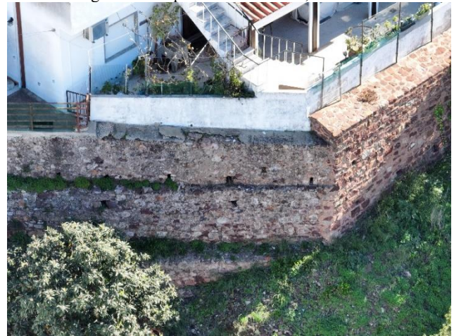
Tramo de muralha O6. À direita, reconstituição de muro de alvenaria que simula a continuidade da muralha. À esquerda, capeamento de tramo em alvenaria ordinária revestida com argamassas. Fotografia do arquivo do SCR/CMS, 2025.
