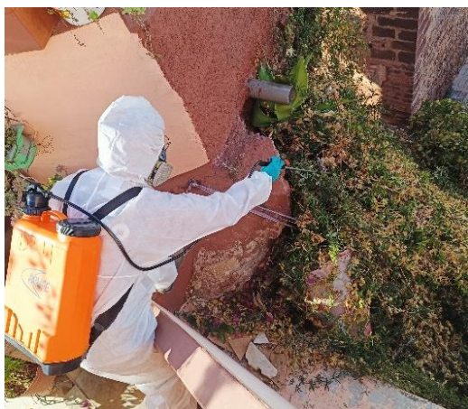
Figura 82: Aplicação de herbicida sistémico em vegetação. Fotografia do arquivo do SCR/CMS, 2024.
