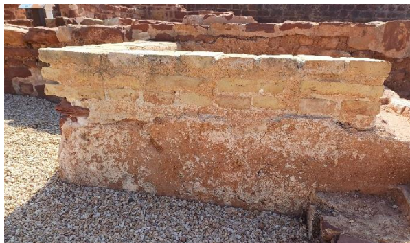
Revestimento com argamassa de cal e areia fina sobre ladrilho de cor branca. Fotografia: autor, 2025.
