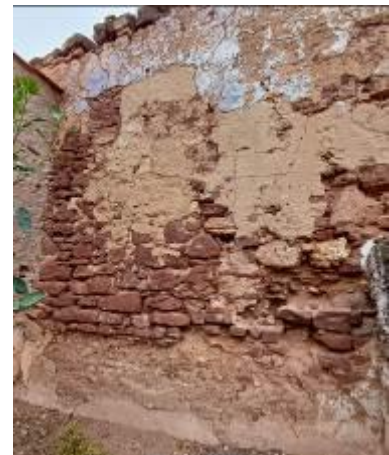
Fotografia do Tramo S11. Fotografia do arquivo do SCR/CMS, 2024.
