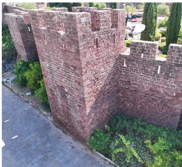
Figura 1: Torre adossada da Alcáçova de Silves. Fotografia do arquivo do SCR/CMS, 2024.
