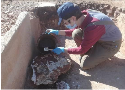
Figura 110: Consolidação dos revestimentos com silicato de etilo após a limpeza da superfície e dos excessos nos suportes. Fotografia do arquivo do SCR/CMS, 2022.
