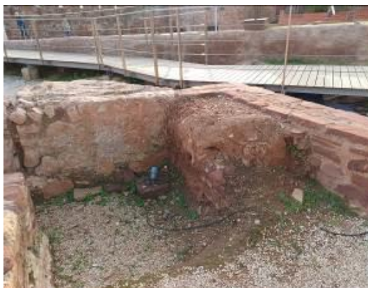
Destacamentos e lacunas da taipa. Fotografias do arquivo do SCR/CMS, 2024.
