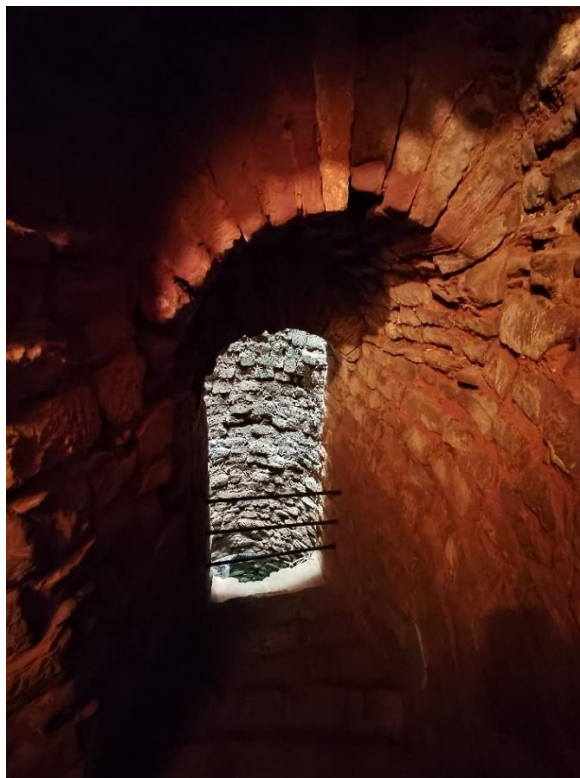
Abertura final que dá acesso à água do poço. Fotografia do arquivo do SCR/CMS, 2023.
