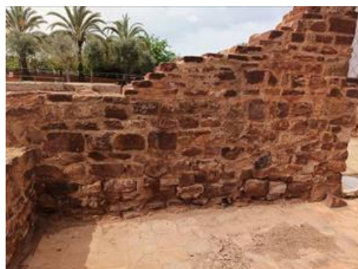
Ausência de argamassa na base do muro que coloca em risco o destacamento de elementos pétreos. Fotografias do arquivo do SCR/CMS, 2023 à esquerda e 2024 à direita.
