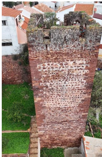
Fotografia do alçado norte da Torre 5. Fotografia do arquivo do SCR/CMS, 2024.
