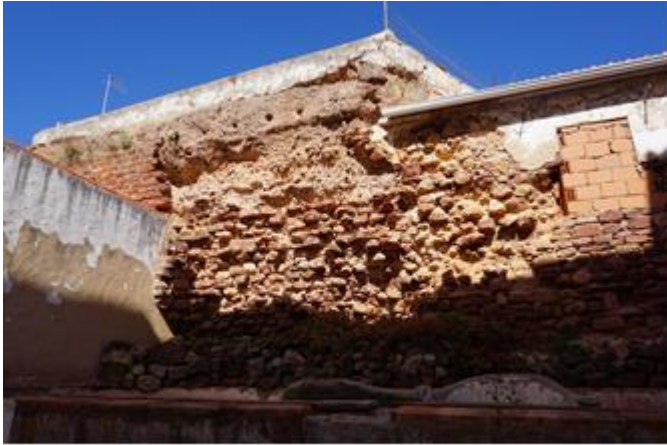
Torre 3. Construída a sua base com alvenaria em grés de Silves e argamassa de cal e a continuação em taipa. Fotografia do arquivo do SCR/CMS, 2017.
