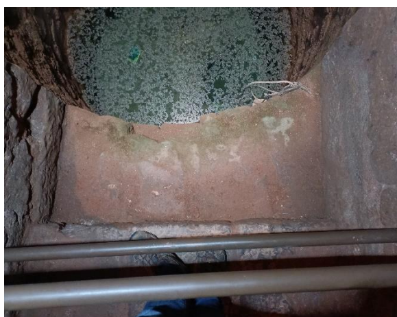
Será feita a instalação da sinalética junto à guarda por parte de empresa externa. Fotografia do arquivo do SCR/CMS, 2024.
