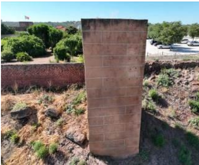
Torre 10 do tipo albarrã revestida com argamassa de cal e com imitação de juntas no revestimento. Fotografia do arquivo do SCR/CMS, 2024.
