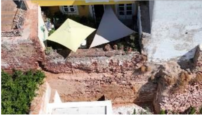
Tramo de muralha S7. Capeamento da muralha original. Devido ao destacamento de materiais pétreos observa-se o interior da muralha em taipa. Fotografia do arquivo do SCR/CMS, 2024.
