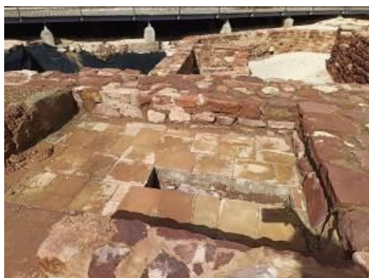
Abertura de juntas e risco de descolamento. Fotografias do arquivo do SCR/CMS, 2024.
