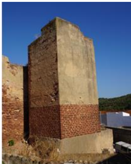
Fotografia da Torre 4 – LEB, 2017.
