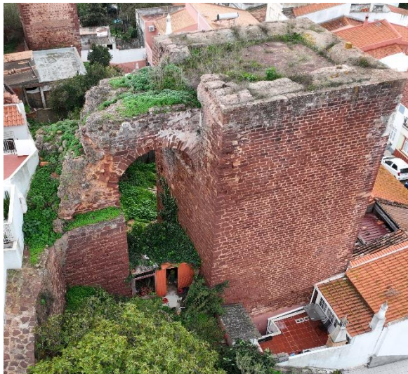
Fotografia do alçado norte da Torre 6. Fotografia do arquivo do SCR/CMS, 2024.
