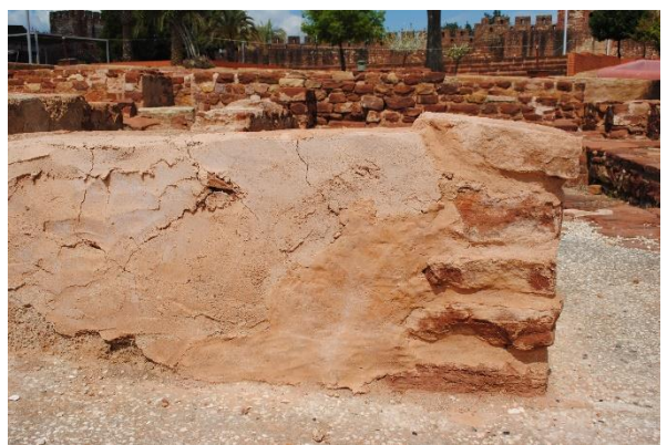
Reboco com argamassa de cal e areia de intervenção. Fotografia: autor, 2025.
