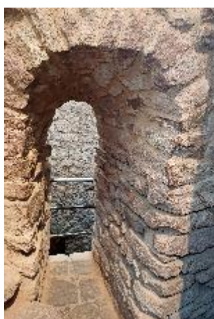
Vão 1. As patologias identificadas são sobretudo abertura de juntas, arenização dos elementos pétreos e argamassas, e sujidades diversas à superfície. Aparece estar estável estruturalmente. Fotografia do arquivo do SCR/CMS, 2024.
