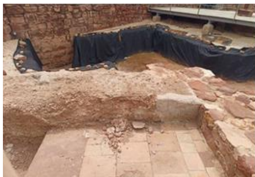
Fissuras, risco e descolamento de argamassas de sacrifício e pulverulência da taipa. Fotografias do arquivo do SCR/CMS, 2023 à esquerda e 2024 à direita.
