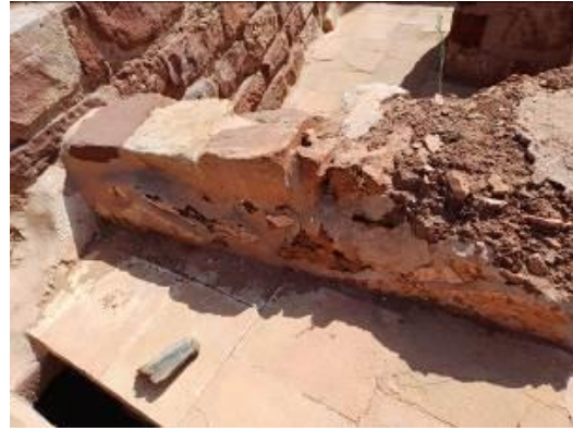
Risco e destacamento do capeamento. Fotografia do arquivo do SCR/CMS, 2024.
