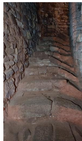
Abertura de juntas, pulverulência, arenização e fissuras nos elementos pétreos, sujidade superficial e presença pontual de sais. Fotografias do arquivo do SCR/CMS, 2024.
