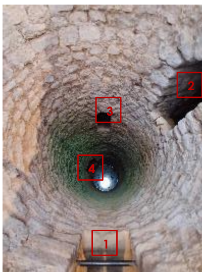
O Poço-Cisterna é constituído por 4 vãos (aberturas para o seu interior). O vão 1 corresponde ao local onde foi tirada a fotografia. Vista geral do estado de conservação do interior. Fotografia do arquivo do SCR/CMS, 2024.
