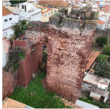
Fotografia do alçado norte da Torre 5. Fotografia do arquivo do SCR/CMS, 2024.
