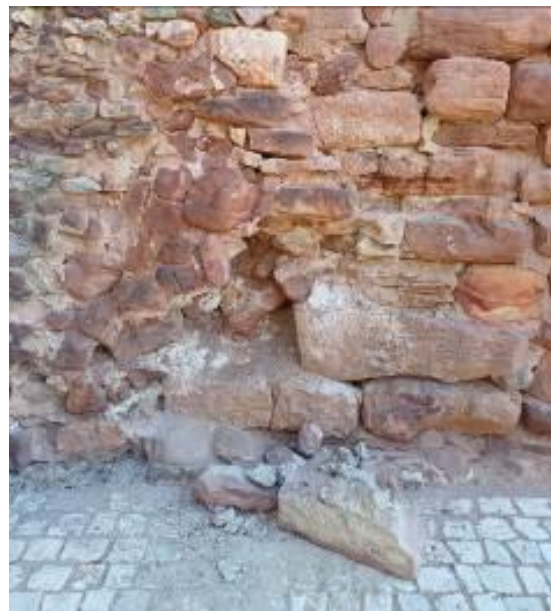
Destacamento de elementos pétreos na fachada poente que deverá ter ocorrido entre 02/08/2024 e 04/08/2024. Devido à localização na via pública e o início da Feira Medieval a 09/08/2024, o SCR procedeu à intervenção pontual urgente de conservação e restauro de 06/08/2024 a 08/08/2024. Fotografia do arquivo do SCR/CMS, 2024.
