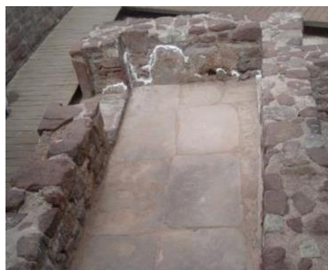
Figura 98: Depois da limpeza mecânica de depósitos e, da fixação de revestimentos parietais com PLM-AL. Fotografia do arquivo do SCR/CMS, 2016.
