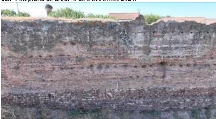
Tramo de muralha N6. Construído na base em alvenaria e erguido em taipa na parte superior. Fotografia do arquivo do SCR/CMS, 2024.
