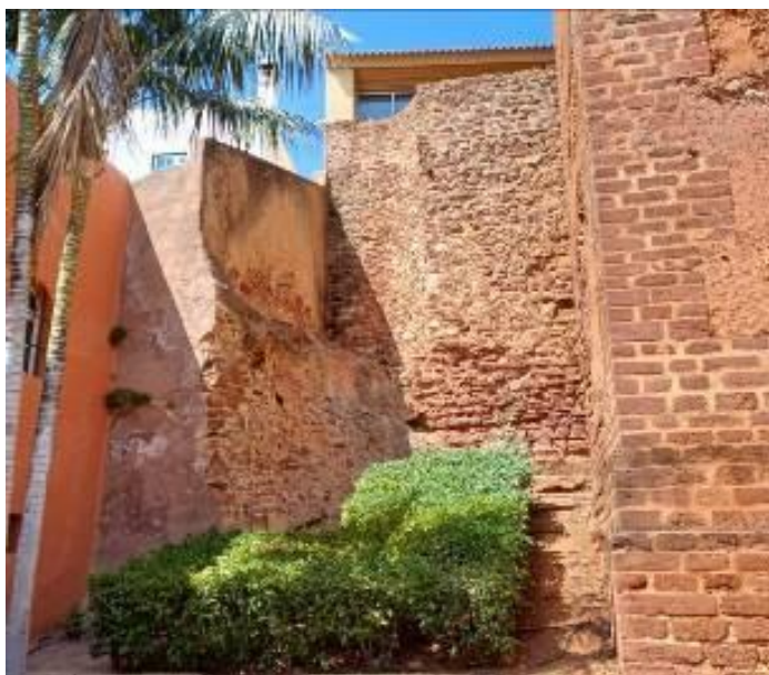
Tramo de muralha S10. Alvenaria ordinária com grés de Silves e argamassa à base de cal. Fotografia do arquivo do SCR/CMS, 2024
