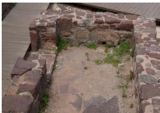
Figura 97: Antes da limpeza mecânica de depósitos. Fotografia do arquivo do SCR/CMS, 2016.
