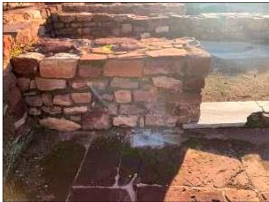
Abertura de juntas e diminuição da presença de colonização biológica. Fotografias do arquivo do SCR/CMS, 2023 à esquerda e 2024 à direita.
