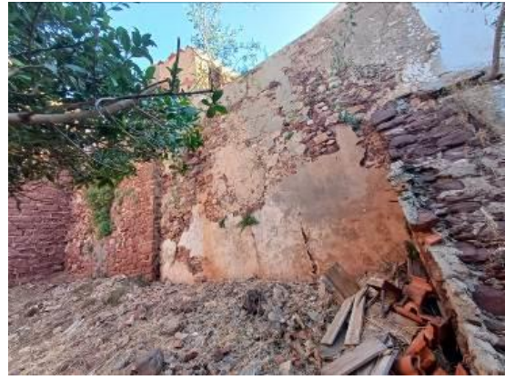
Fotografias do alçado poente do Tramo O5. Abertura de juntas, desagregação da argamassa, presença elevada de colonização biológica e lacunas na alvenaria de pedra. EC5 . Fotografia do arquivo do SCR/CMS, 2024.
