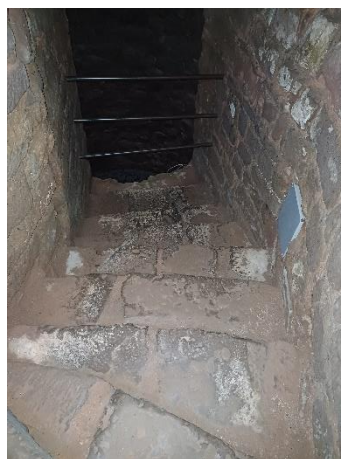
Abertura de juntas, pulverulência, arenização de elementos pétreos, sujidade superficial e presença pontual de sais. Fotografias do arquivo do SCR/CMS, 2024.
