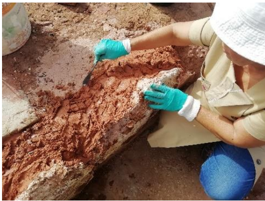
Figura 112: Readesão do suporte com aplicação de calda por camadas e posterior regularização da última camada com argamassa à base de cal. Fotografia do arquivo do SCR/CMS, 2022.
