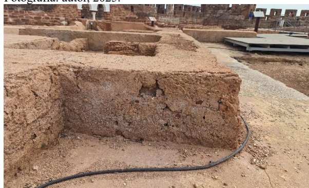
Camada de sacrifício de intervenção realizada com argamassa de cal e areia grossa e agregados. Fotografia: autor, 2025.
