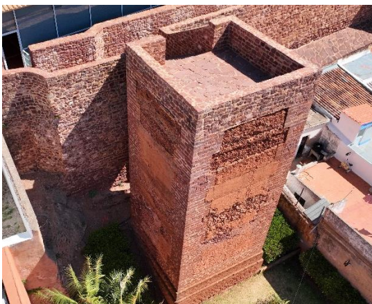
Figura 49: Último patamar da Torre 17. Fotografia do arquivo do SCR/CMS, 2024.
