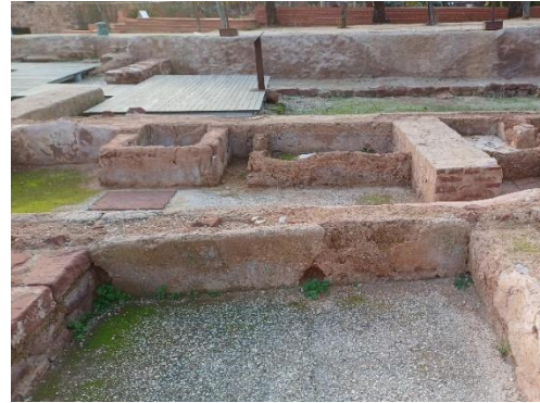
Fendas, risco e destacamento de argamassas de sacrifício aplicadas na taipa. Foi aplicado silicato de etilo para consolidar a taipa. Fotografias do arquivo do SCR/CMS, 2023 à esquerda e 2024 à direita.
