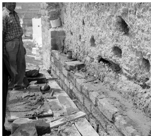
Figura 35: Intervenção realizada pela DGEMN. Capeamento em pedra de alçado da Torre 6. Fotografia do arquivo do SIPA, década de 1930 – 1940.
