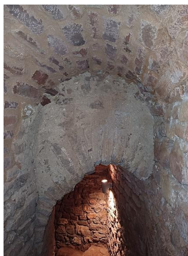
Figura 118: Argamassas aplicadas durante a escavação arqueológica dos anos 80. Fotografia do arquivo do SCR/CMS, 2024.
