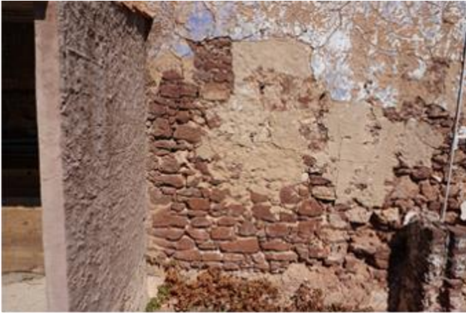
Fotografia do Tramo S11 – LEB , 2017.
