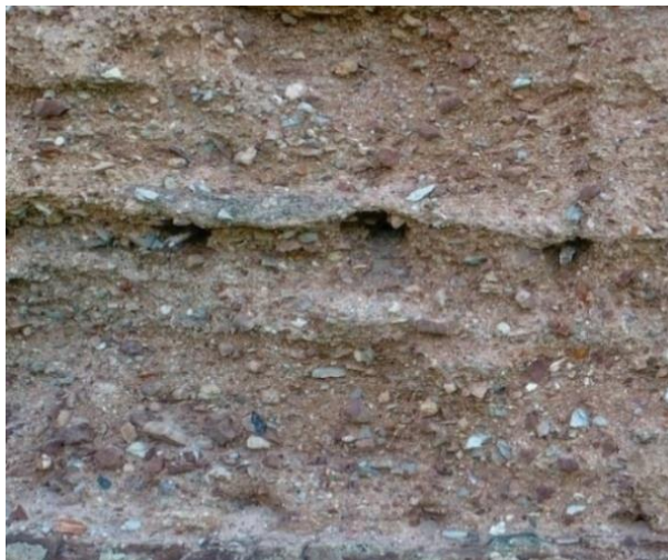
Figura 55: Pormenor das agulhas do taipal no tramo N6. Fotografia do arquivo do SCR/CMS, 2017.
