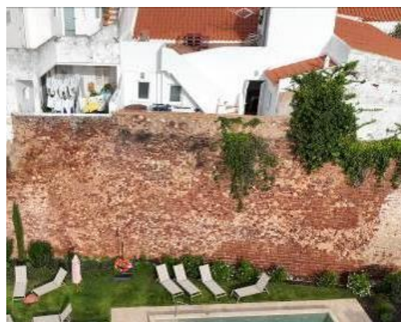
Fotografia dos Tramos S5 e S6. Fotografia do arquivo do SCR/CMS, 2024.
