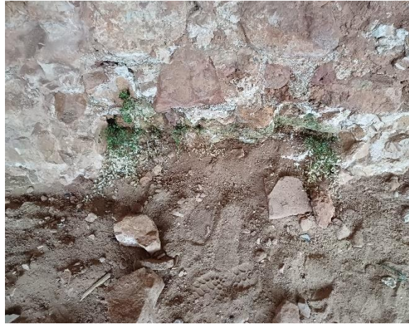
Após a aplicação de biocida onde se verifica o resultado positivo do produto. Fotografias do arquivo do SCR/CMS, 2024.
