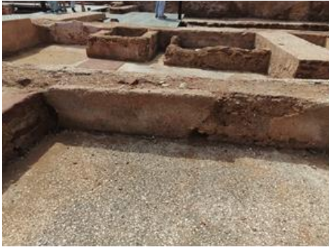
Fendas, risco e destacamento de argamassas de sacrifício aplicadas na taipa. Foi aplicado silicato de etilo para consolidar a taipa. Fotografias do arquivo do SCR/CMS, 2023 à esquerda e 2024 à direita.
