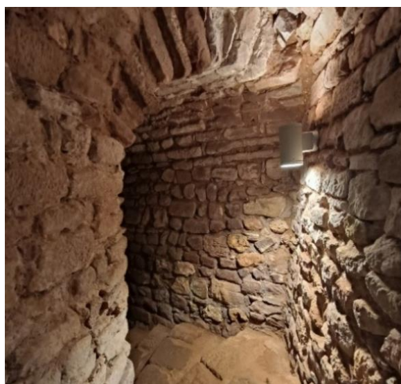
Figura 9: Arco da estrutura do Poço-Cisterna em grés de Silves. Fotografia: autor, 2024.
