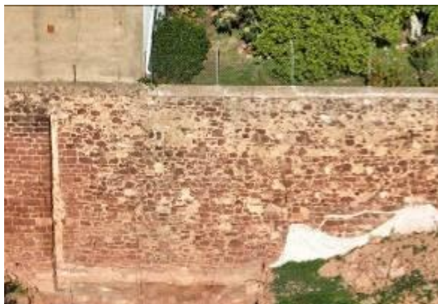
Tramo de muralha S2. Capeamento da muralha original. Alvenaria ordinária com grés de Silves e argamassa à base de cal. Fotografia do arquivo do SCR/CMS, 2023.
