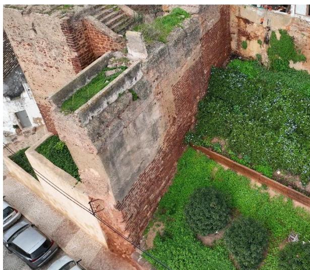
Fotografia do alçado nascente do Tramo O1. Fotografia do arquivo do SCR/CMS, 2024.
