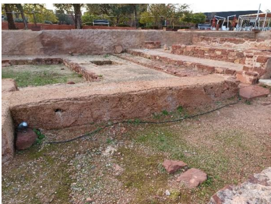
Estrutura em que foi feita consolidação e aplicada cal inject. Fotografias do arquivo do SCR/CMS, 2004.
