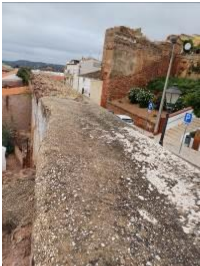
Topo do Tramo S11. Fotografia do arquivo do SCR/CMS, 2024.
