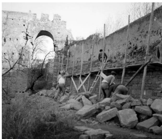
Figura 34: Intervenção realizada pela DGEMN. Capeamento em pedra do tramo N11. Fotografia do arquivo do SIPA, década de 1930 – 1940.
