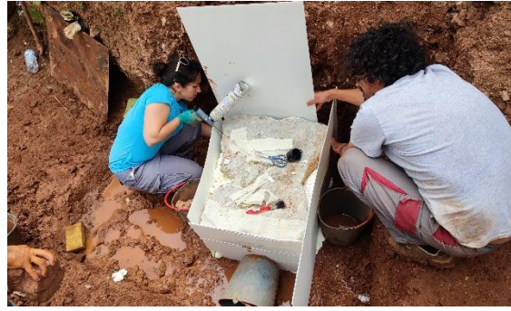
Figura 19: Levantamento de merlão na ruína do Arrabalde de Silves. Fotografia do arquivo do SA/CMS, 2024.
