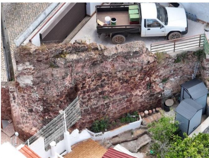
Tramo de muralha O7. Construído em alvenaria ordinária e aparelhada com grés de Silves e argamassa à base de cal, na parte superior a estrutura era construída em taipa. Fotografia do arquivo do SCR/CMS, 2025.
