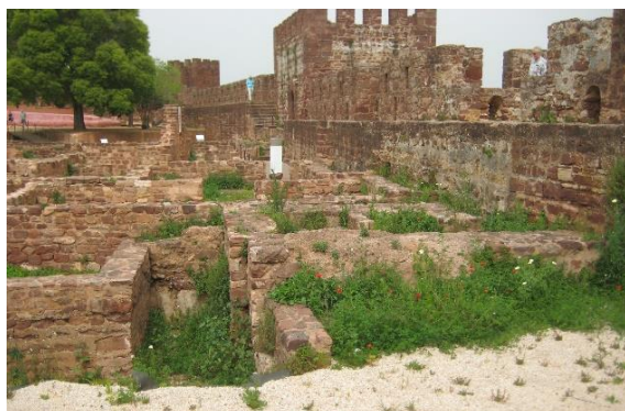
Figura 95: Colonização biológica. Fotografia do arquivo do SCR/CMS, 2011.
