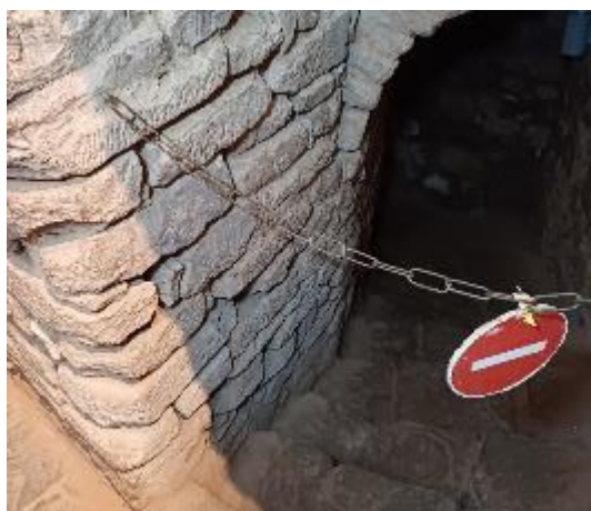
Abertura de juntas, arenização e sujidade generalizada. Fotografia do arquivo do SCR/CMS, 2024.
