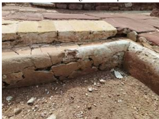
Fendas, fissuras, risco e destacamento do estuque e da argamassa de restauro. Ligeiro aumento pontual das fissuras e consequente risco de destacamento. Fotografias do arquivo do SCR/CMS, 2023 à esquerda e 2024 à direita.
