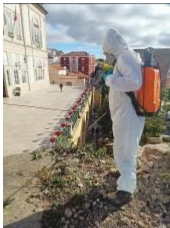
Segunda aplicação de herbicida e corte da figueira, uma vez que a primeira aplicação não teve qualquer efeito. O SCR irá aplicar novamente. Para além da figueira, verificam-se outras plantas superiores. Fotografia do arquivo do SCR/CMS, 2024.
