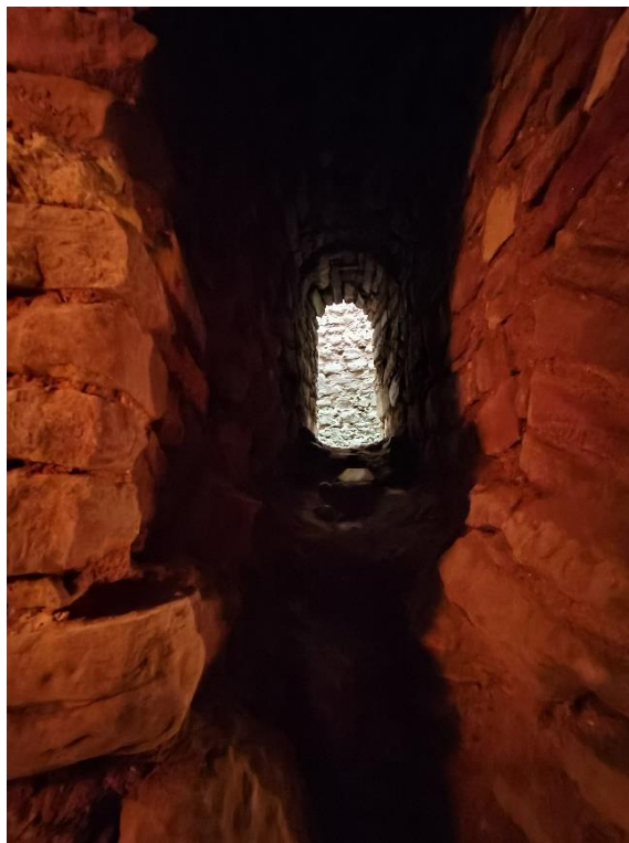
Janela do 3º patamar com abóbada de perfil semicircular, que faz ligação entre a galeria e o poço. Fotografia do arquivo do SCR/CMS, 2023.
