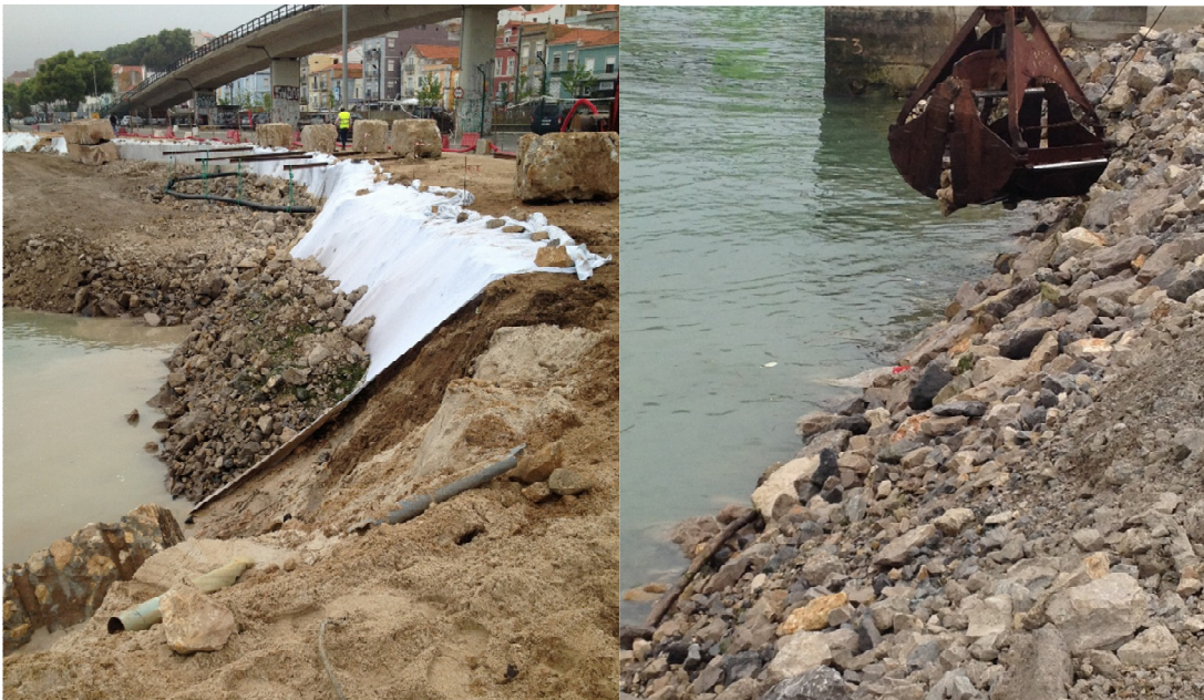
Figura 21 – Colocação de enrocamento no talude
