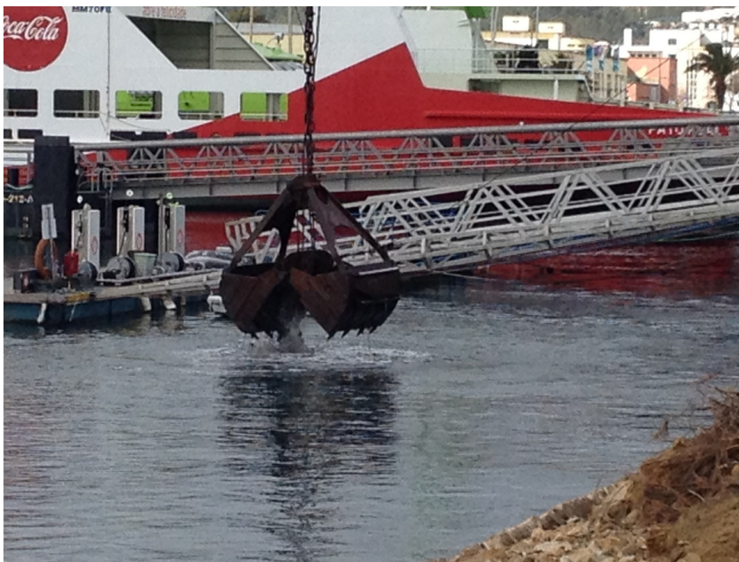
Figura 16 – Execução de dragagem com balde Clamshell
