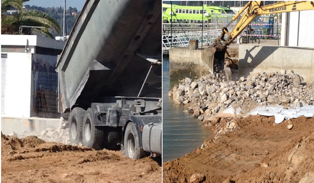
Figura 20 – Transporte e colocação do enrocamento em obra
