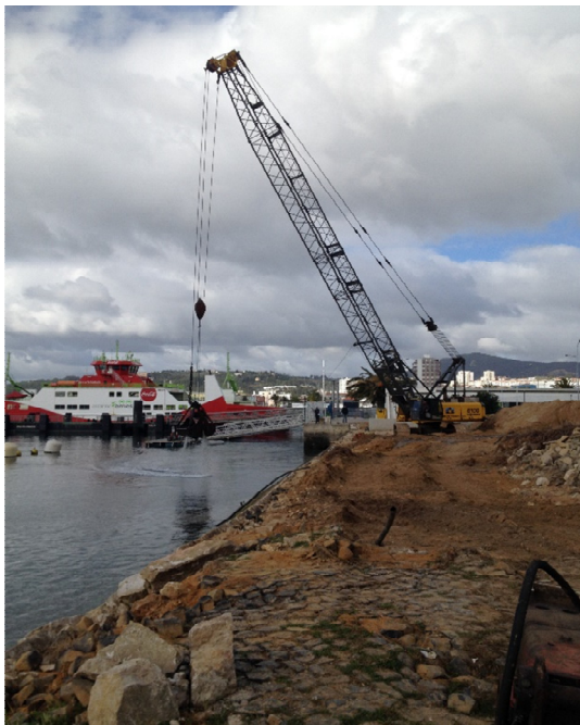
Figura 17 – Dragagem com grua de rastos
