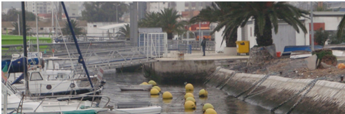
Figura 13 – Vista no sentido nascente-poente, da retenção marginal e do muro cais
