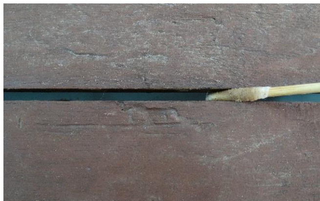
Figura 67 – Remoção de adesivo antigo e sujidade desagregada pela ranhura entre as duas tábuas, A. P.
