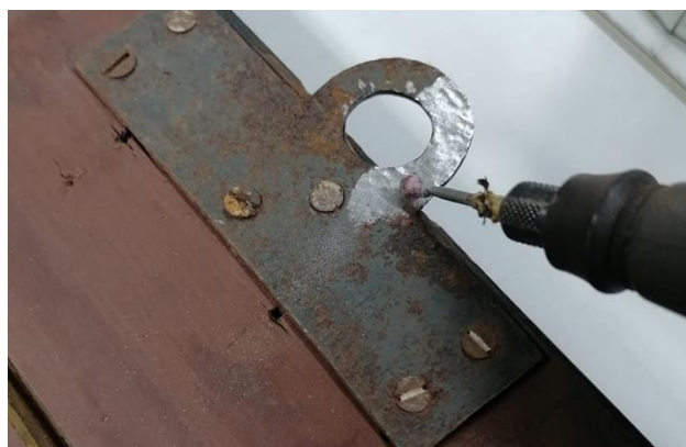
Figura 58 – Remoção dos produtos de corrosão com mini berbequim, A. P.
