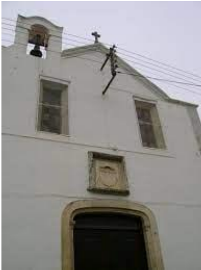
Figura D2 – Fachada principal da capela do Senhor dos Passos, C.F.: Prof. Vitor Serrão
