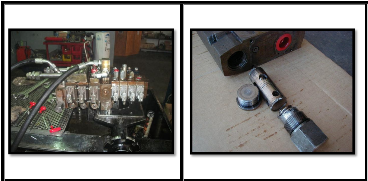
Figura 4.19. Intervenção no distribuidor hidráulico
