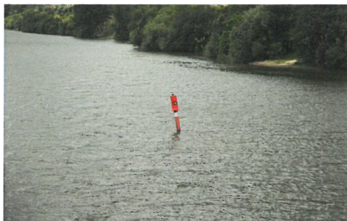
Figura 14 – Marcas danificadas que criam situações de risco (Fotografia cedida pelo IH - CFR Maurício Camilo)
