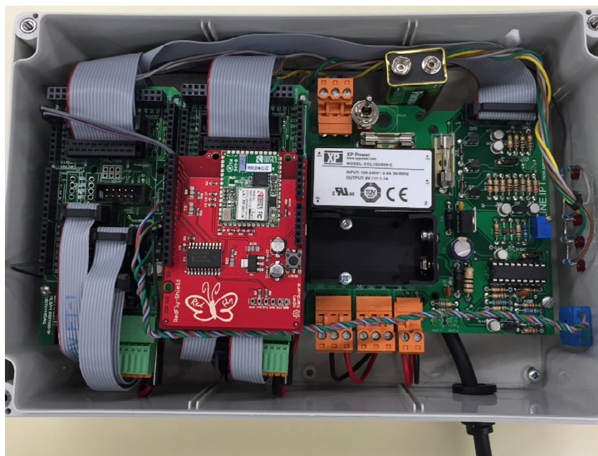
Figura 118 - Vista dos circuitos internos do protótipo.
