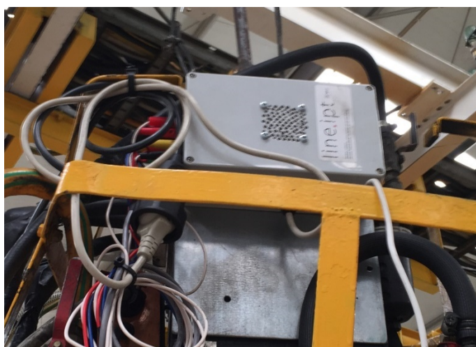
Figura 89 - Módulo "SLAVE" do secundário do protótipo 1 instalado.
