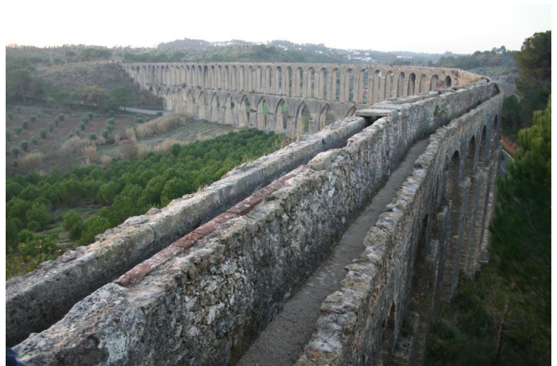
Foto 33: Aqueduto dos Pegões ou do Convento, também conhecido como Aqueduto Filipino
