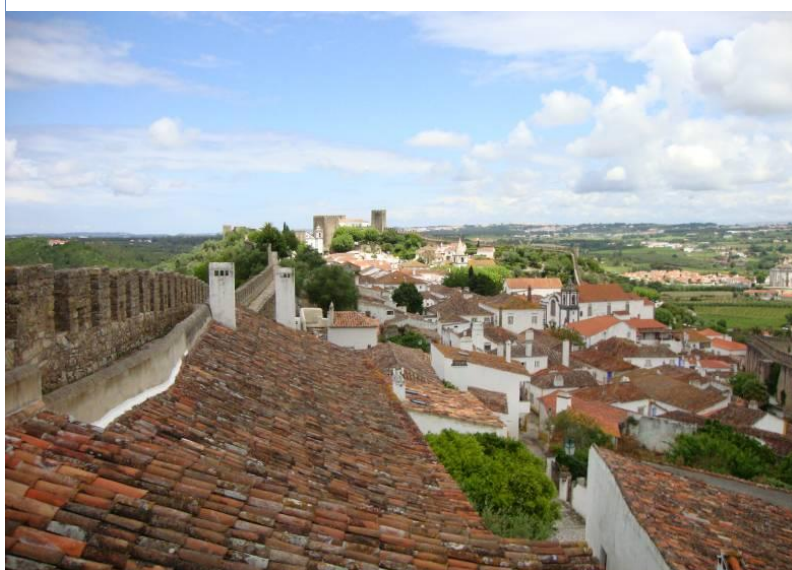
Foto 2: Vista superior do interior da muralha
