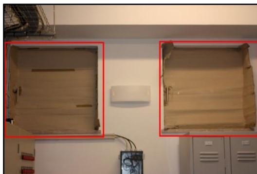
Figura 182 – Sala de quarentena, janelas
