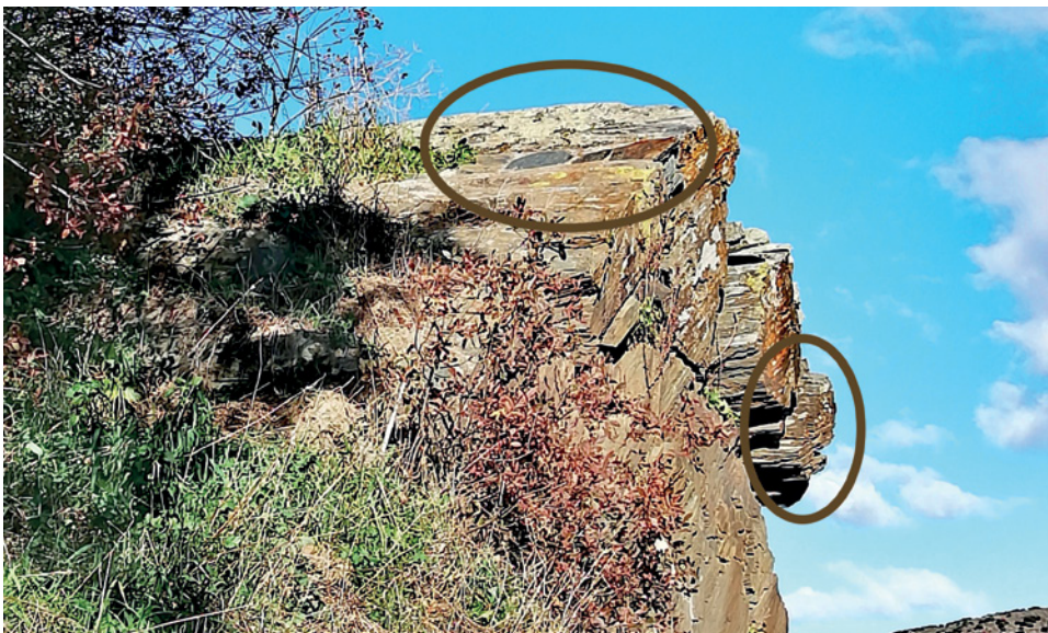
Figura 1: Rocha-tipo intervencionada no Núcleo de Arte Rupestre da Canada do Inferno. Está assinalada a área onde o início de fractura foi coberto por três placas de xisto (ao centro na imagem), assim como o bloco em toppling na parte superior do afloramento que foi recuado para a posição onde ainda hoje se encontra (à direita na imagem). Foto: © António Batarda Fernandes.
