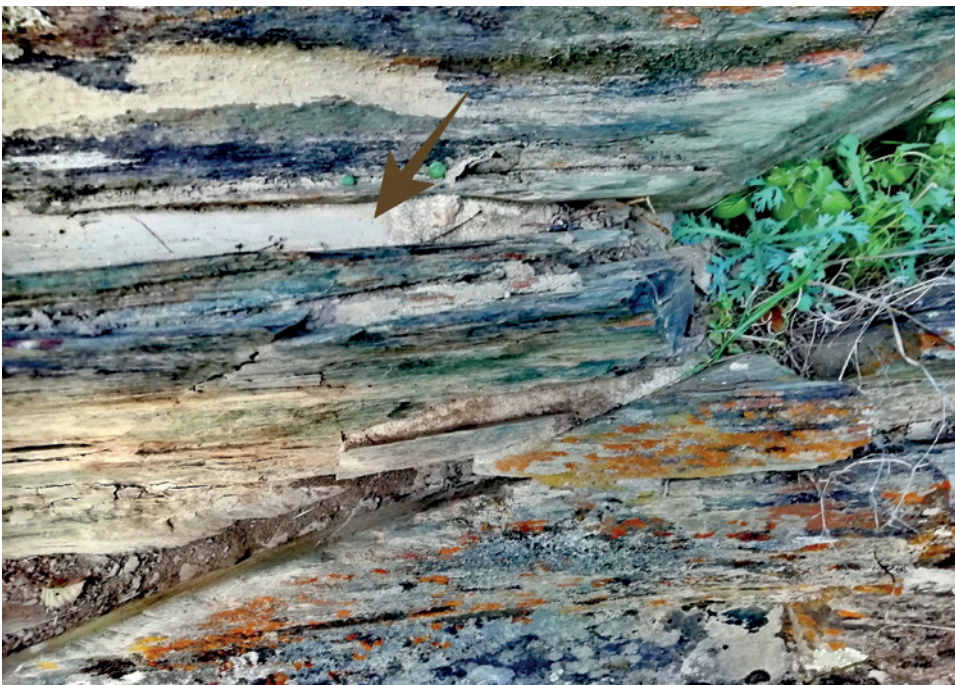
Figura 5: Rocha-tipo intervencionada no Núcleo de Arte Rupestre da Penascosa. Assinala-se uma das fraturas preenchida com diferentes argamassas. Note-se o facto de o processo de "renaturalização" ter dificultado a localização das intervenções ilustradas aqui realizadas. Foto: © António Batarda Fernandes.
