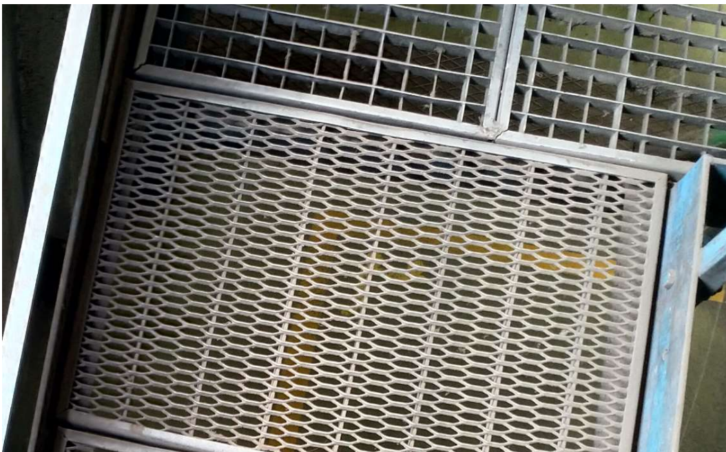
Figura 3.3.10 – Exemplos de chapa expandida presentes na empresa
