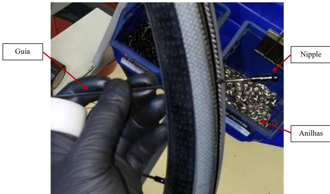
Figura 3.1.3 – Posicionamento do nipple e anilha na guia
