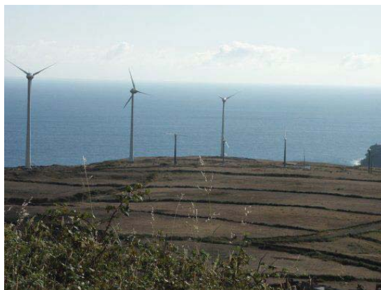
Figura 2.2- Parque eólico do Figueiral
