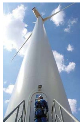
Figura 2.10-torre tubular em aço
