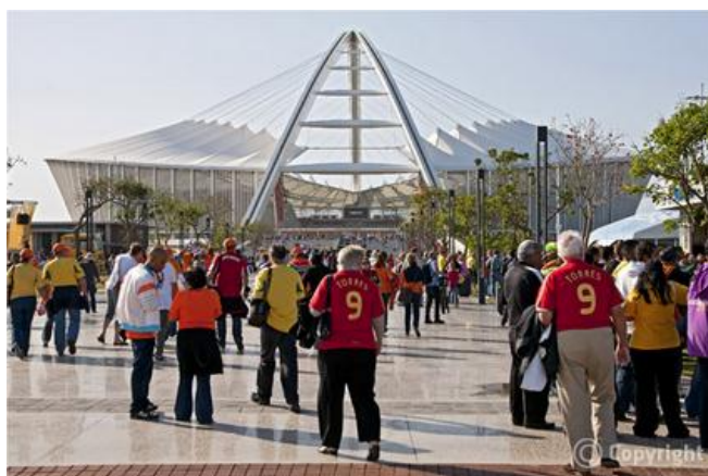
Figura 24 - Moses Mabhida Stadium, em Durban [40]
