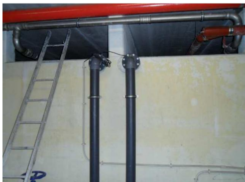
Figura 65 - Acesso ao reservatório com duas células
