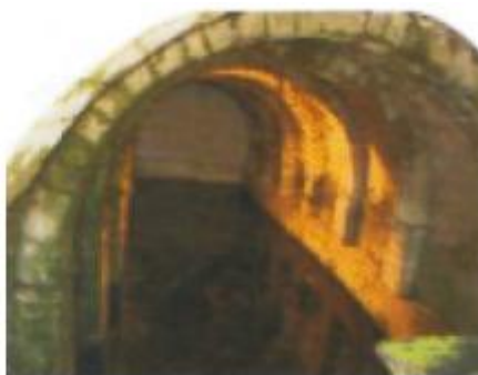
Figura 15 - Cisterna na vila de Monsaraz [16]
