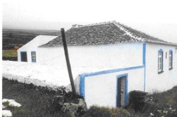
Figura 18 - Cisterna de uma moradia de Santa Bárbara, na Ilha Terceira [18]
