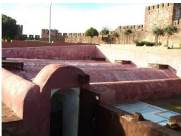
Figura 16 - Cisterna do Castelo de Silves [16]
