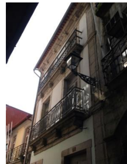
Figura A7.348 | P 12, Rua da Reboleira.
