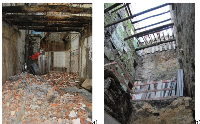
Figura 4.46 | Interior da parcela durante a fase de demolições: a) onde é visível a estrutura do pavimento original; b) escoramento das paredes [01].
