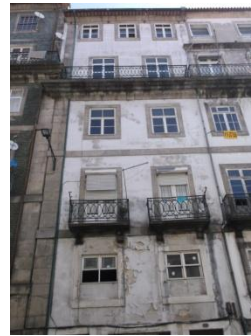
Figura A7.63 | P 11, Rua S. João.
