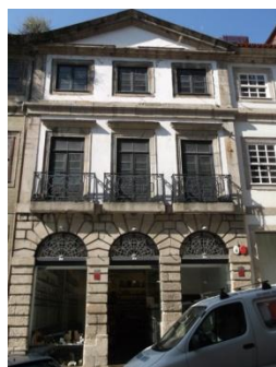
Figura A7.266 | P 03, Rua S. João.
