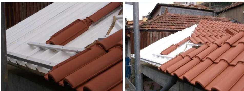
Figura 4.21 | Colocação do ripado de PVC e das telhas cerâmicas.
