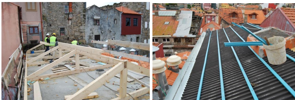
Figura 4.50 | Trabalhos de execução da nova cobertura do edifício [01].
