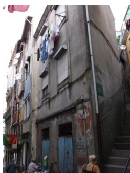
Figura A7.163 | P 01, Rua do Souto.
