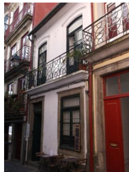
Figura A7.346 | P 10, Rua da Reboleira.
