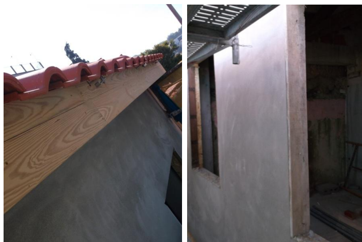
Figura 4.31 | Parede de “tabique” rebocada.
