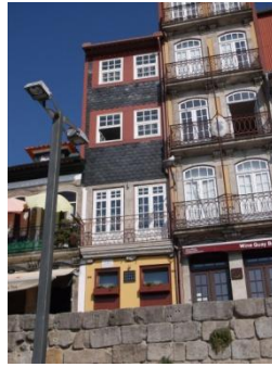
Figura A7.334 | P 18, Muro Bacalhoeiros.
