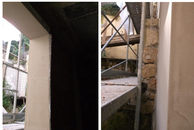
Figura 4.24 Parede tardoz com o sistema de revestimento de isolamento térmico pelo exterior aplicado.
