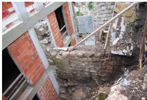
Figura 4.23 Parede do alçado tardoz ainda apenas em alvenaria de tijolo [01].
