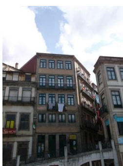
Figura A7.168 | P 06, Rua do Souto.
