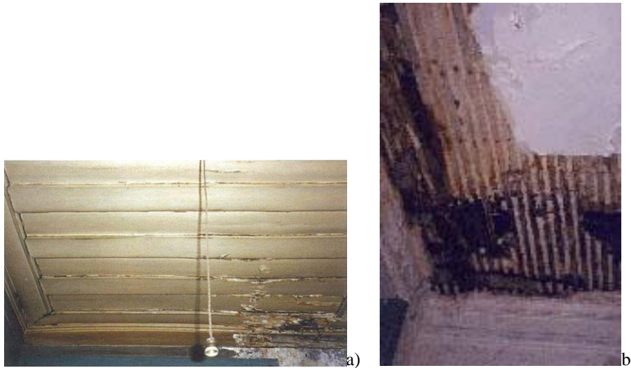
Figura A5.7 | Exemplos de acabamentos de tetos em madeira: a) em forma de "camisa e saia" [08]; b) com estuque [04].
