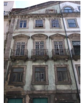
Figura A7.68 | P 16, Rua S. João
