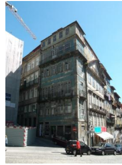
Figura A7.75 | P 23, Travessa da Bainharia.
