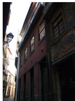
Figura A7.297| P 04, Rua da Reboleira.
