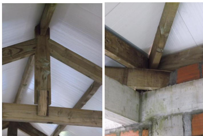
Figura 4.17| Pormenores da estrutura da cobertura.
