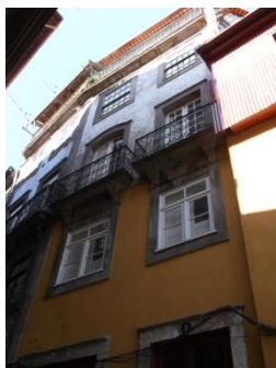
Figura A7.295| P 02, Rua da Reboleira.
