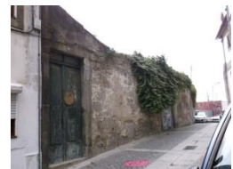
Figura A7.432 | P 05, Rua da Vitória.
