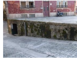
Figura A7.352 | P 03, Rua da Reboleira.
