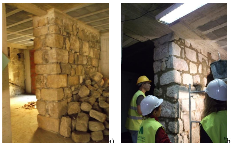
Figura 4.32 | Parede meeira: a) após reconstrução; b) durante os trabalhos de preenchimento das juntas e limpeza
