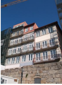
Figura A7.317| P 01, Muro Bacalhoeiros.
