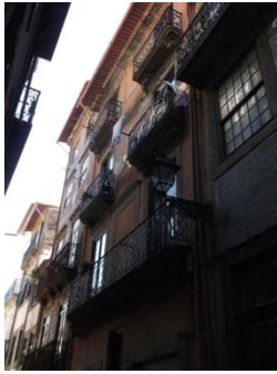
Figura A7.341 | P 05, Rua da Reboleira.
