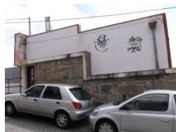
Figura A7.430 | P 03, Rua da Vitória.
