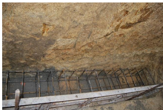
Figura 4.47 | Trabalhos de execução de sapatas [01].
