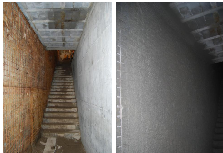
Figura 4.49 | Trabalhos de execução dos elementos em betão armado e do reforço das paredes meeiras [01].
