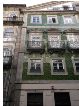
Figura A7.103 | P 24, Rua S. João.
