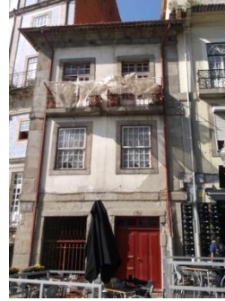
Figura A7.270 | P 07, Rua S. João.
