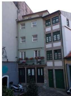
Figura A7.307 | P 14, Rua da Reboleira.
