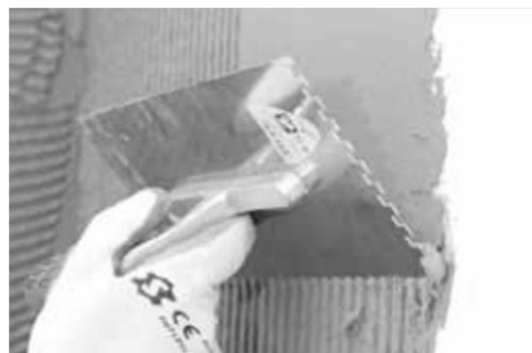
Figura A6.14 | Aplicação da camada de base com a rede de fibra de vidro embebida [04].
