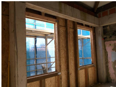
Figura 4.29 | Parede de “tabique” já com a colocação da estrutura dos vãos e das placas de OSB.
