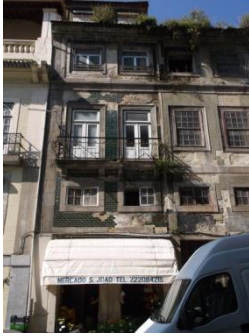
Figura A7.268 | P 05, Rua S. João.
