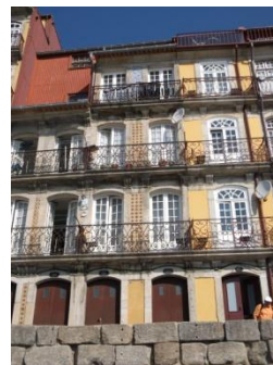
Figura A7.331| P 15, Muro Bacalhoeiros.
