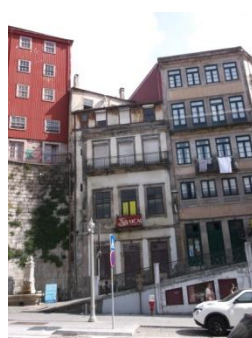
Figura A7.169 | P 07, Rua do Souto.
