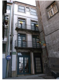
Figura A7.304 | P 11, Rua da Reboleira
