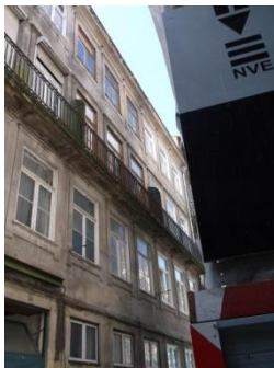
Figura A7.77 | P 25, Travessa da Bainharia.
