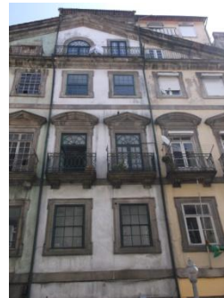
Figura A7.67 | P 15, Rua S. João
