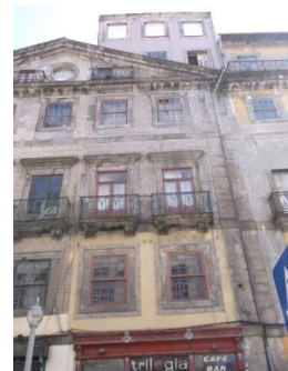
Figura A7.56| P 04, Rua S. João.
