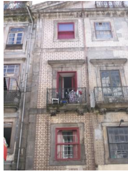
Figura A7.58 | P 06, Rua S. João.
