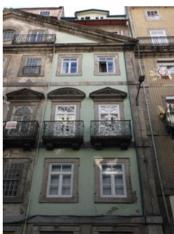
Figura A7.100 | P 21, Rua S. João.
