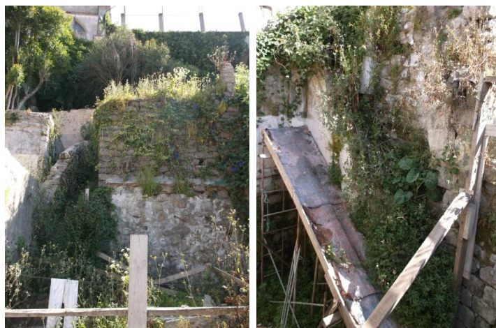
Figura 4.38| Estado do logradouro no final do acompanhamento da obra.
