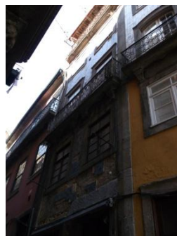
Figura A7.296| P 03, Rua da Reboleira.
