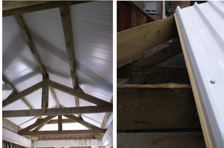
Figura 4.19 | Estrutura da cobertura com o painel sandwich aplicado.
