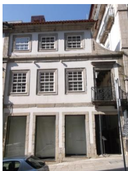
Figura A7.265 | P 02, Rua S. João.
