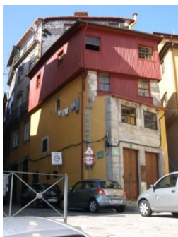
Figura A7.294| P 01, Rua da Reboleira.
