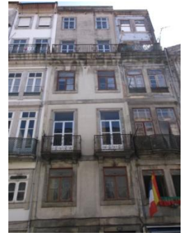
Figura A7.60 | P 08, Rua S. João.
