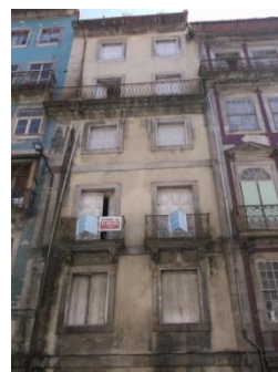
Figura A7.71 | P 19, Rua S. João.
