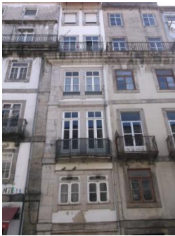
Figura A7.61 | P 09, Rua S. João.
