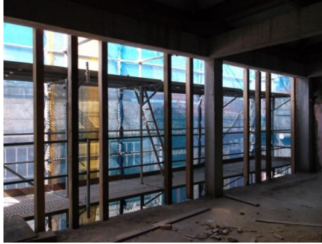
Figura 4.27 | Estrutura da parede de “tabique” com prumos verticais de madeira de pinho.
