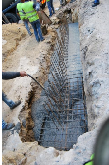
Figura 4.13 | Trabalhos de execução de sapatas [01].
