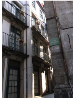
Figura A7.303 | P 10, Rua da Reboleira.
