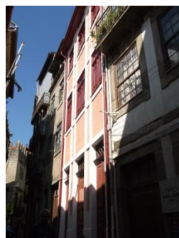
Figura A7.300| P 07, Rua da Reboleira.
