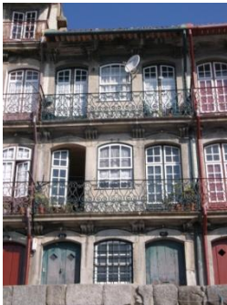
Figura A7.325| P 09, Muro Bacalhoeiros.
