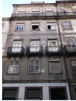
Figura A7.105 | P 26, Rua S. João.
