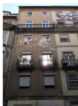
Figura A7.98 | P 19, Rua S. João.
