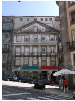
Figura A7.74 | P 22, Rua S. João.
