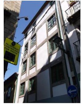
Figura A7.305 | P 12, Rua da Reboleira
