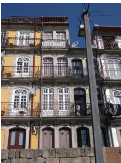
Figura A7.329| P 13, Muro Bacalhoeiros.
