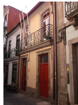
Figura A7.347 | P 11, Rua da Reboleira.
