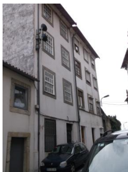
Figura A7.434 | P 07, Rua da Vitória.
