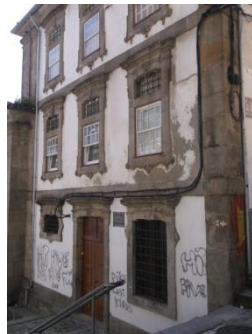
Figura A7.354 | P 02, Escadas do Codeçal.
