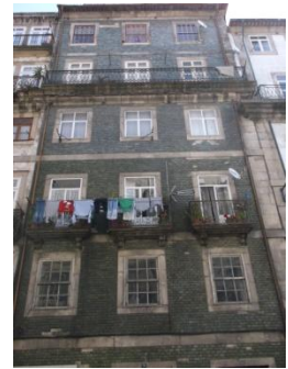
Figura A7.64 | P 12, Rua S. João.
