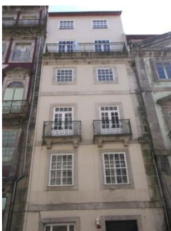
Figura A7.69 | P 17, Rua S. João.
