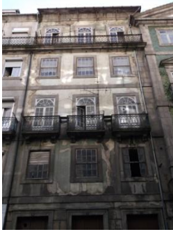
Figura A7.104 | P 25, Rua S. João.
