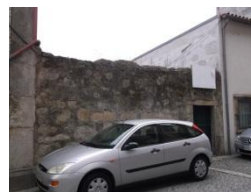
Figura A7.436 | P 09, Rua da Vitória.
