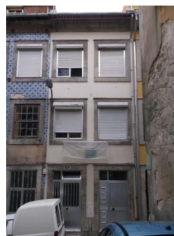
Figura A7.440 | P 13, Rua da Vitória.
