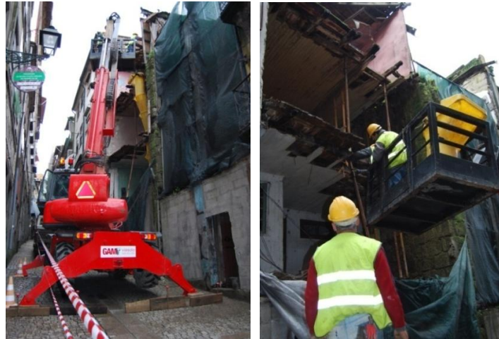
Figura 4.11 | Fase dos trabalhos de demolição [01].
