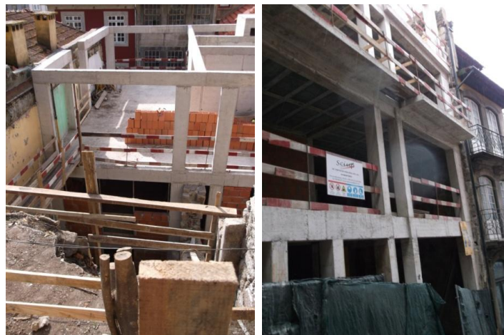
Figura 4.14 | Elementos estruturais executados quando do início do acompanhamento da obra.
