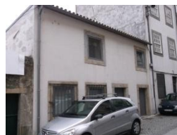
Figura A7.435 | P 08, Rua da Vitória.
