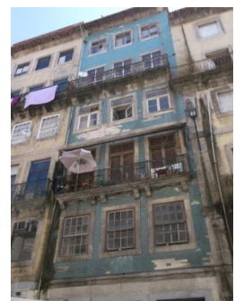
Figura A7.72 | P 20, Rua S. João.
