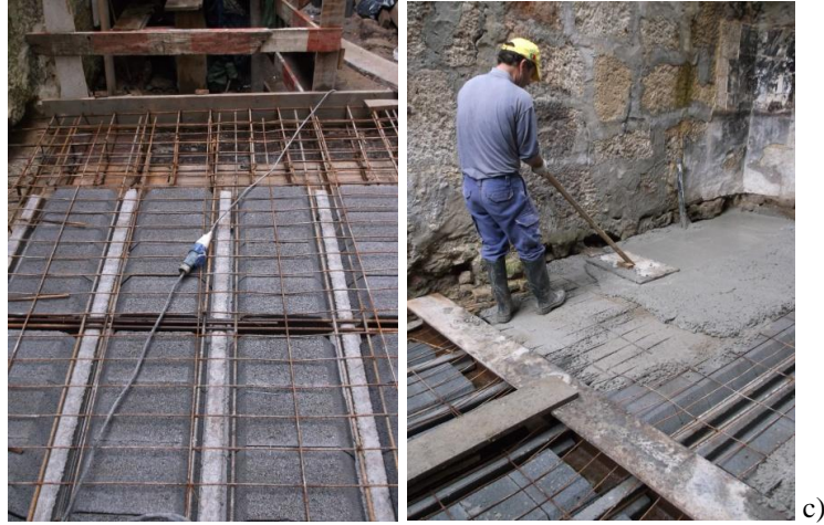
Figura 4.67 | Execução da laje aligeirada: a) colocação dos perfis metálicos selados nas paredes de alvenaria de pedra existentes; b) colocação das vigotas pré esforçadas e das abobadilhas em betão; c) execução da camada de compressão.
