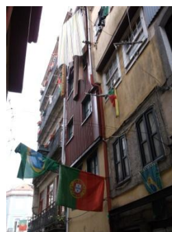
Figura A7.166 | P 04, Rua do Souto.
