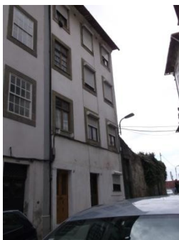
Figura A7.433 | P 06, Rua da Vitória.
