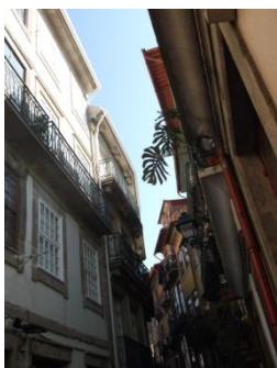
Figura A7.298| P 05, Rua da Reboleira.
