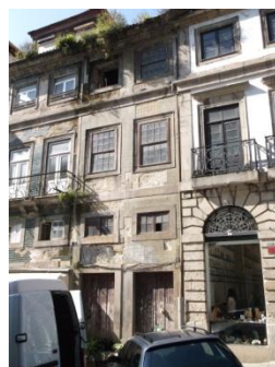
Figura A7.267 | P 04, Rua S. João.
