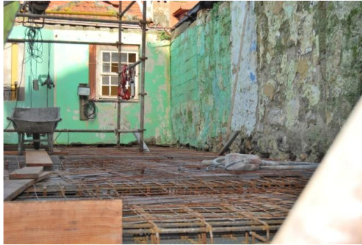
Figura 4.48 | Trabalhos de execução das lajes [01].
