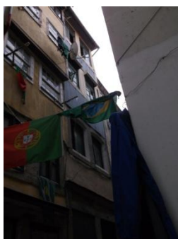
Figura A7.164 | P 02, Rua do Souto.
