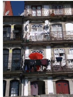
Figura A7.327| P 11, Muro Bacalhoeiros.
