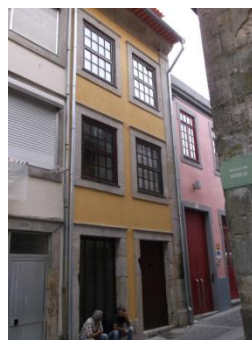
Figura A7.439 | P 12, Rua da Vitória.
