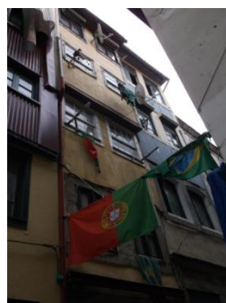
Figura A7.165 | P 03, Rua do Souto.
