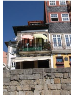
Figura A7.335 | P 19, Muro Bacalhoeiros.
