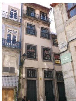
Figura A7.338| P 02, Rua da Reboleira.
