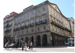
Figura A7.107 | P 28, Rua S. João.
