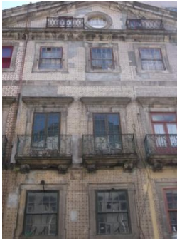
Figura A7.57 | P 05, Rua S. João.
