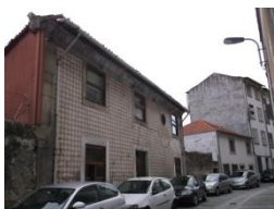
Figura A7.437 | P 10, Rua da Vitória.
