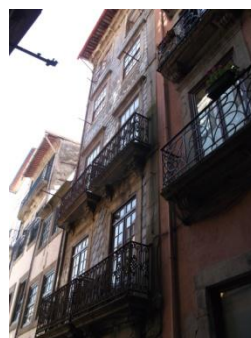
Figura A7.340| P 04, Rua da Reboleira.
