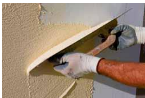
Figura A6.15 | Aplicação do revestimento final [04].
