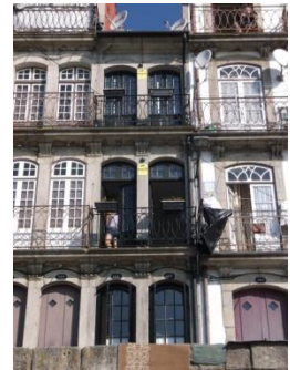
Figura A7.328| P 12, Muro Bacalhoeiros.
