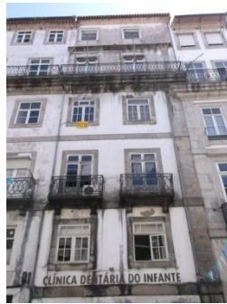
Figura A7.62 | P 10, Rua S. João.
