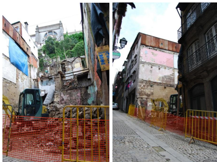
Figura 4.12 | Trabalhos de remoção e limpeza dos resíduos de demolição [01].
