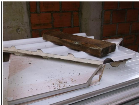
Figura 4.20 | Constituição do painel sandwich aplicado.
