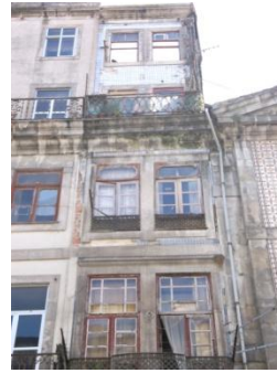
Figura A7.59 | P 07, Rua S. João.
