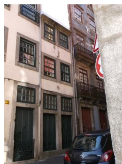
Figura A7.339| P 03, Rua da Reboleira.
