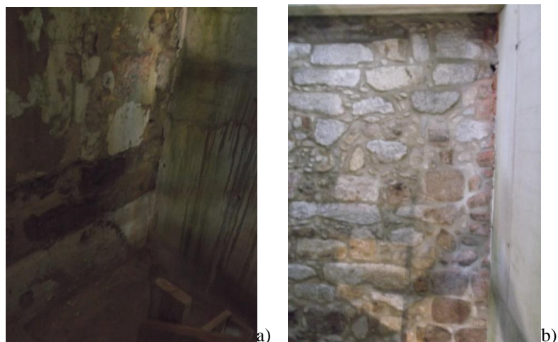
Figura 4.33 | Parede da caixa de escadas: a) antes da intervenção; b) depois da intervenção.
