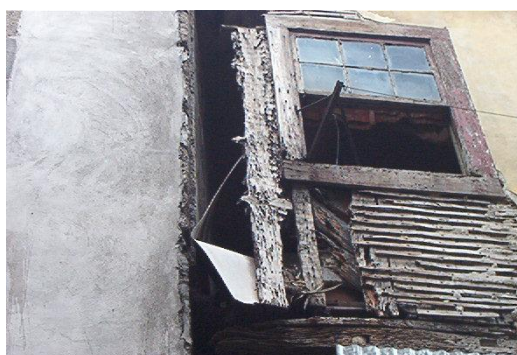
Figura 4.26 | Pormenor da parede em tabique ( cedido pela Arq. a Ana Leite ).
