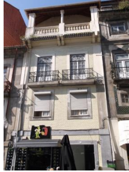
Figura A7.269 | P 06, Rua S. João.
