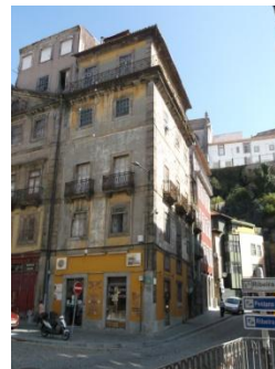
Figura A7.55| P 03, Rua S. João.
