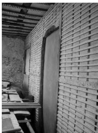
Figura A5.12 | Exemplo de parede interior em tabique simples [04].
