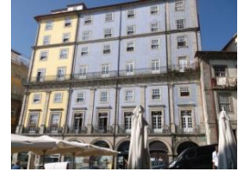
Figura A7.271 | P 08, Rua S. João.
