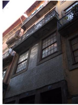
Figura A7.342 | P 06, Rua da Reboleira.
