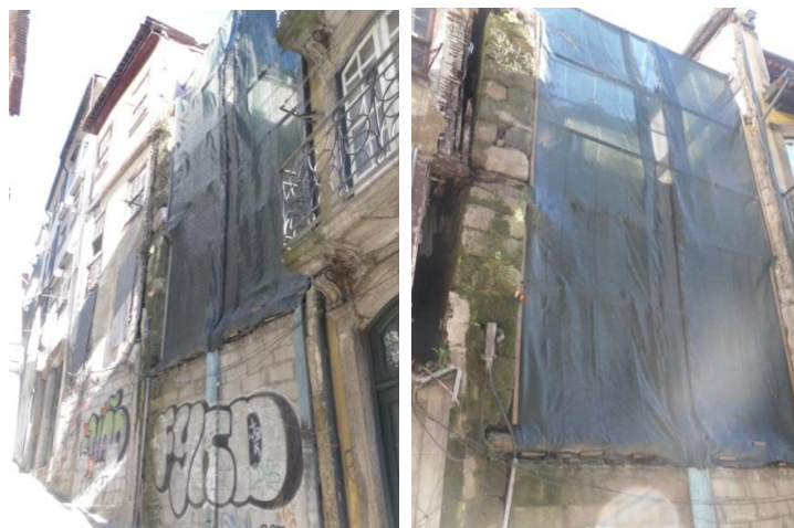
Figura 4.7| Fachada principal da parcela 2, depois da demolição e emparedamento ( cedido pela Arq. a Ana Leite ).
