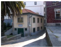
Figura A7.306 | P 13, Rua da Reboleira.
