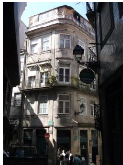
Figura A7.78 | P 26, Travessa da Bainharia.
