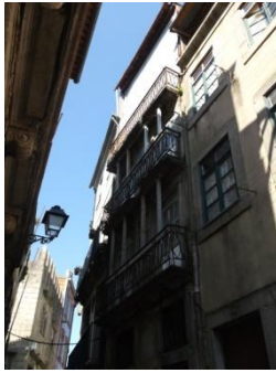
Figura A7.302 | P 09, Rua da Reboleira.
