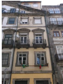
Figura A7.66 | P 14, Rua S. João.
