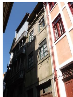
Figura A7.301| P 08, Rua da Reboleira.
