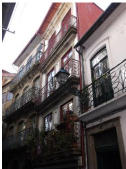
Figura A7.345 | P 09, Rua da Reboleira.
