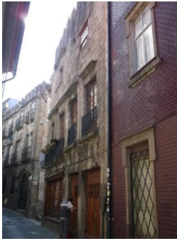
Figura A7.350 | P 01, Rua da Reboleira.
