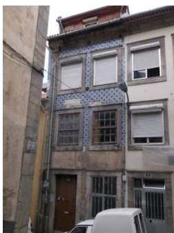
Figura A7.441 | P 14, Rua da Vitória.
