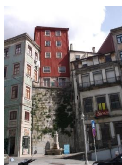
Figura A7.170 | P 08, Rua do Souto.
