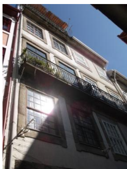
Figura A7.299| P 06, Rua da Reboleira.
