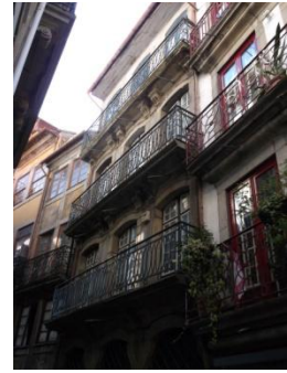
Figura A7.344 | P 08, Rua da Reboleira.
