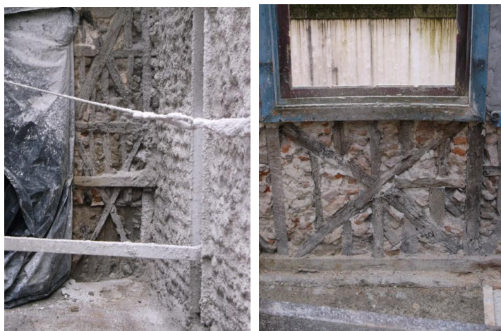
Figura 4.70 | Parede existente em tabique.
