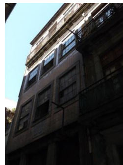
Figura A7.232 | P 36, Rua da Ponte Nova.
