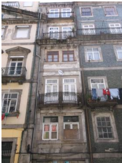
Figura A7.65 | P 13, Rua S. João.
