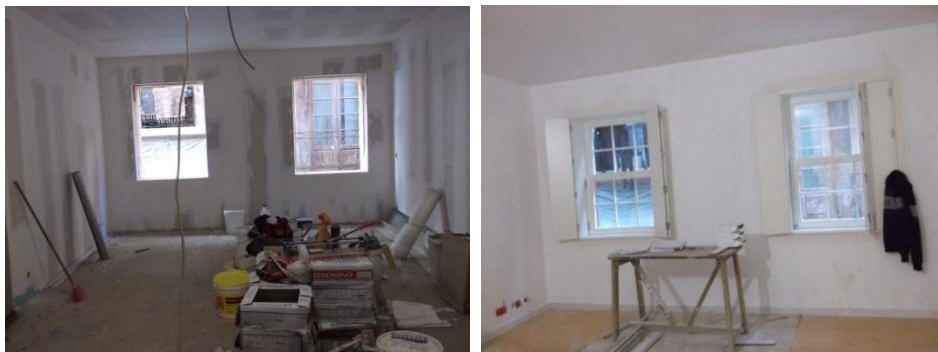
Figura 4.53 | Parede interior e teto revestidos com placas de gesso cartonado.
