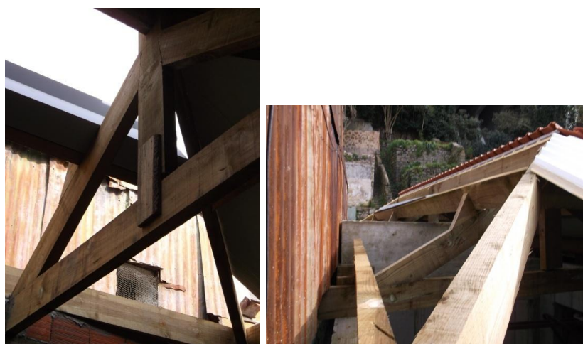
Figura 4.18| Pormenores da estrutura da cobertura.
