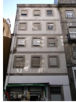
Figura A7.106 | P 27, Rua S. João.
