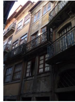
Figura A7.343 | P 07, Rua da Reboleira.
