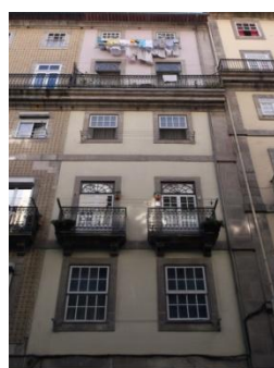
Figura A7.98 | P 19, Rua S. João.
