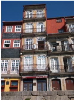
Figura A7.333 | P 17, Muro Bacalhoeiros.
