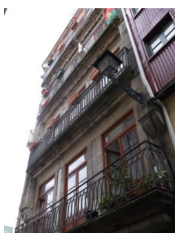
Figura A7.167 | P 05, Rua do Souto.
