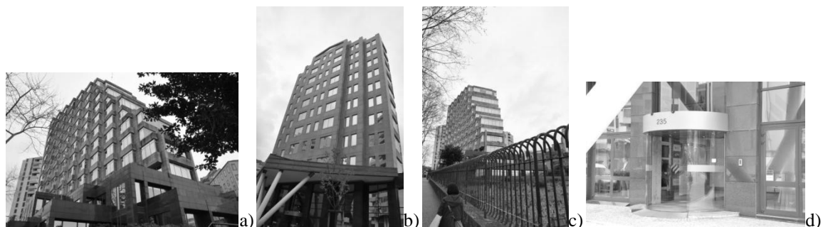
Figura 6.5 | Exemplo de registo fotográfico (Q07019 - Parcela 1): a) fachada lateral direito; b) fachada principal; c) fachada tardoz; d) nº de polícia
