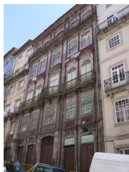
Figura A7.70 | P 18, Rua S. João.
