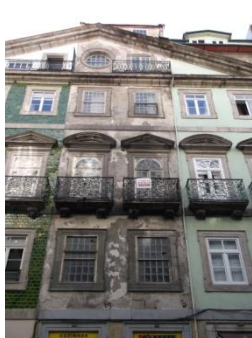
Figura A7.101 | P 22, Rua S. João.
