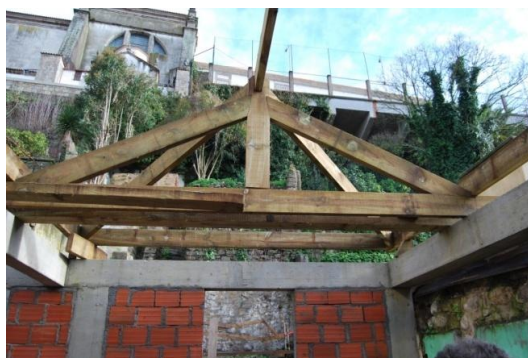
Figura 4.16| Estrutura da cobertura, em madeira.
