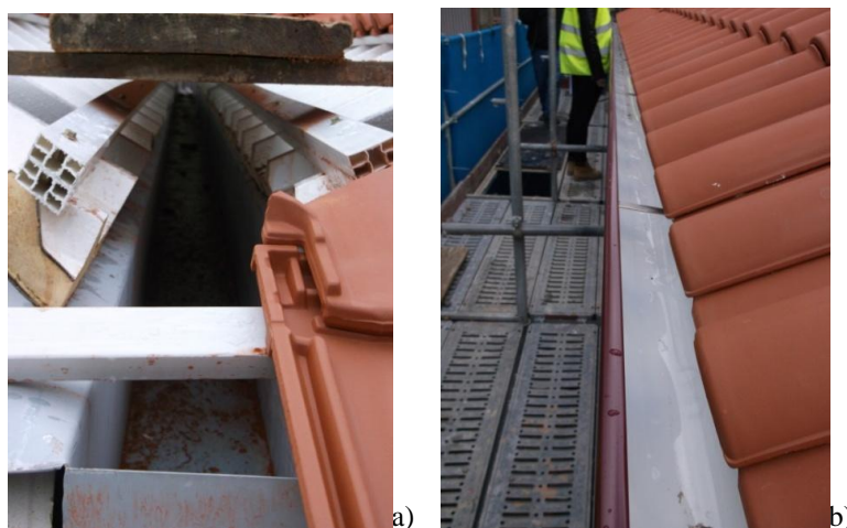
Figura 4.22 | Caleiras: a) na ligação das vertentes da cobertura dos dois edifícios; b) na fachada.
