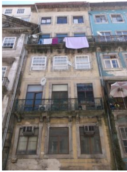
Figura A7.73 | P 21, Rua S. João.
