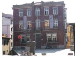
Figura A7.351 | P 02, Rua da Reboleira.
