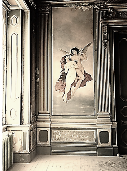
Fotografia 121 - P R C - Parede trabalhada com lambrim, painéis e pilastras.
