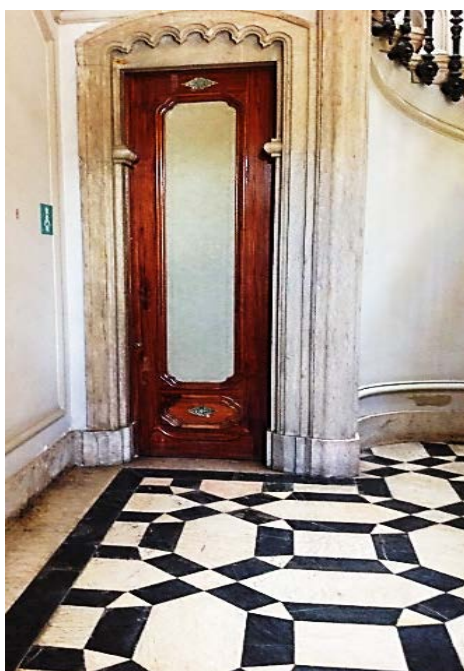
Fotografia 85 - P R C - Porta da Instalação sanitária.
