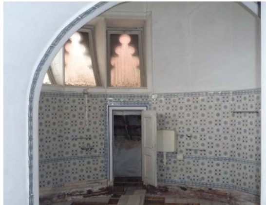
Fotografia 139 – Instalação sanitária numa das cúpulas.
