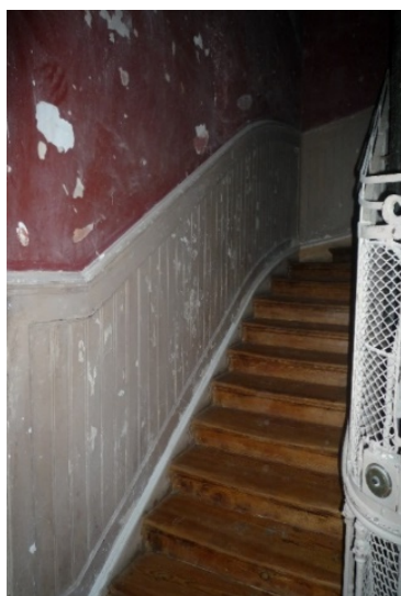
Fotografia 65 - P R C - Piso 0 - Escada de serviço.
