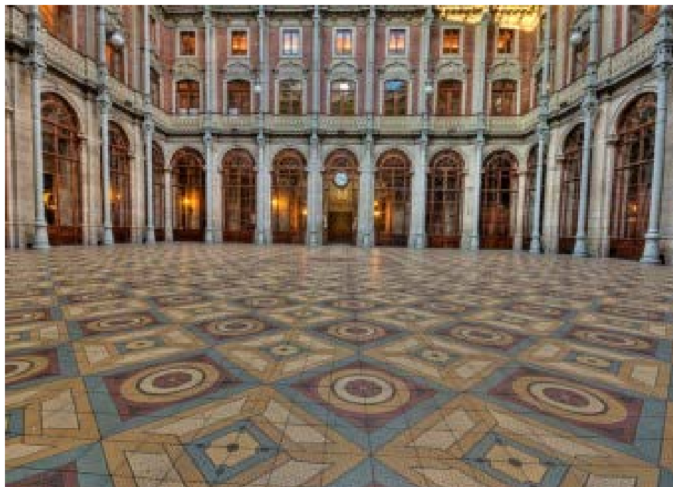
Fotografia 26 – S N A C P - Pavimento em mosaico cerâmico de Tomás Soller.
