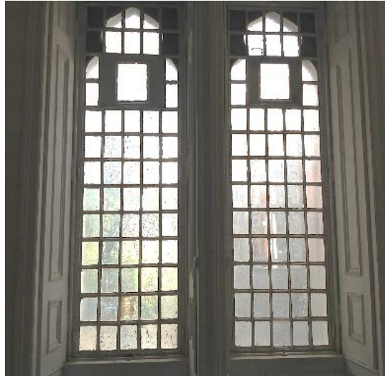
Fotografia 60 - P R C - Vista interior das Janelas da Cozinha.
