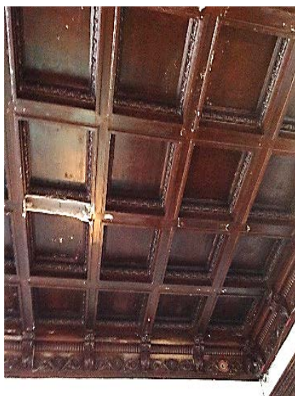
Fotografia 133 - P R C - Tecto forrado em forma de caixotões.
