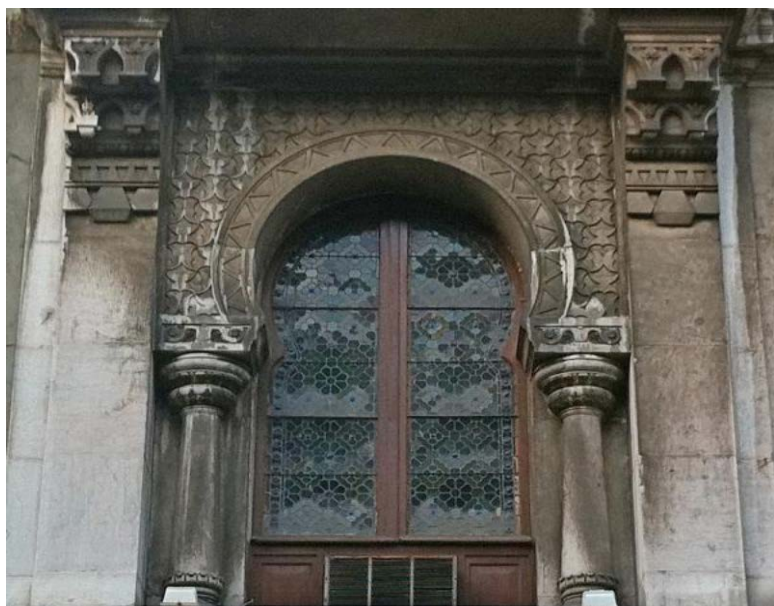
Fotografia 15 - Palacete Conceição e Silva - Fachada principal: pormenor de janela neo-árabe.
