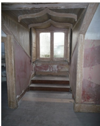
Fotografia 138 - P R C - Acesso a uma janela de peito.
