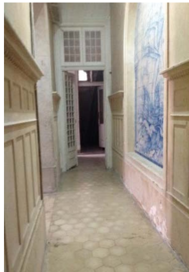
Fotografia 61 - P R C - Piso - 1 - Zona de circulação Principal.
