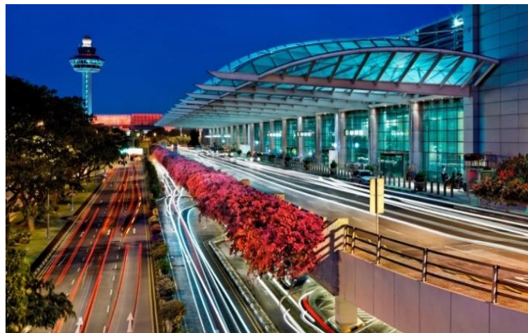
Figura 2 – Terminal do Aeroporto de Changi - Fonte: (Airport C. , 2020)
