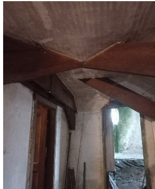
134. Entrada para o torreão à direita da imagem
