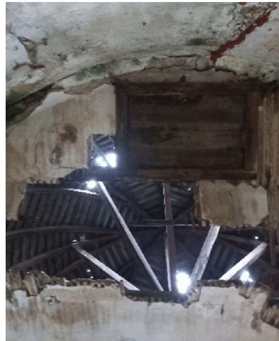
133. Pormenor das asnas do torreão
