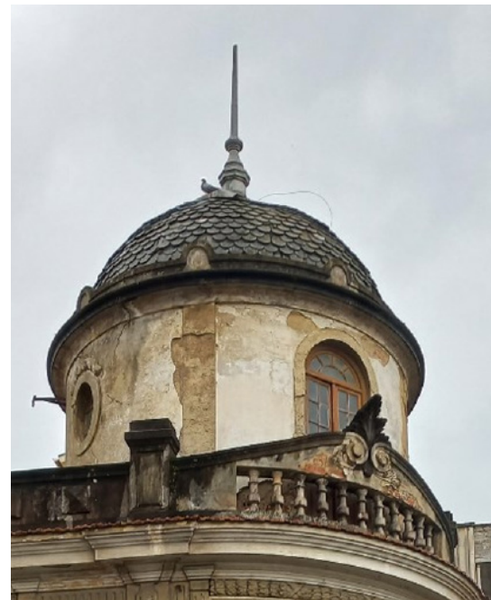
93. Vista lateral do torreão
