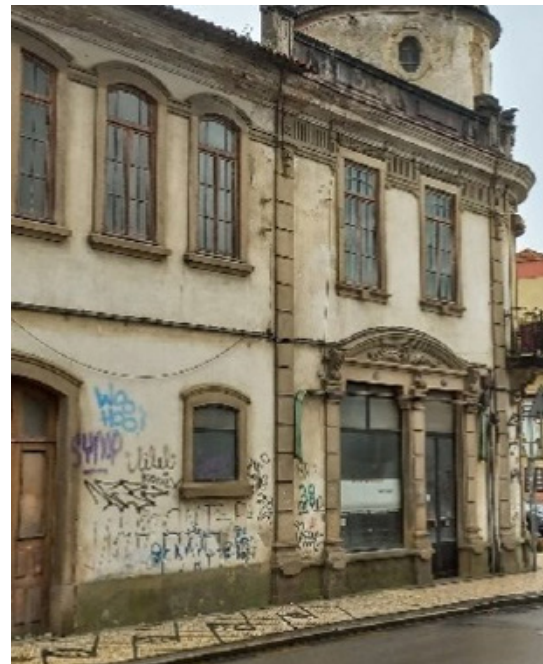
94. Fachada orientada para a Rua Eng. Oudinot
