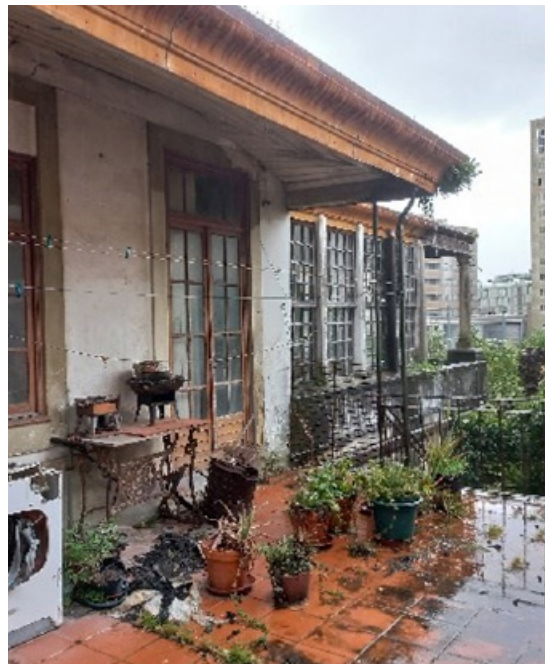
89. Patamar de chegada do piso superior, terraço
