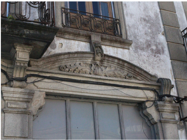
63. Frontão curvos acima de uma das janelas da fachada principal
