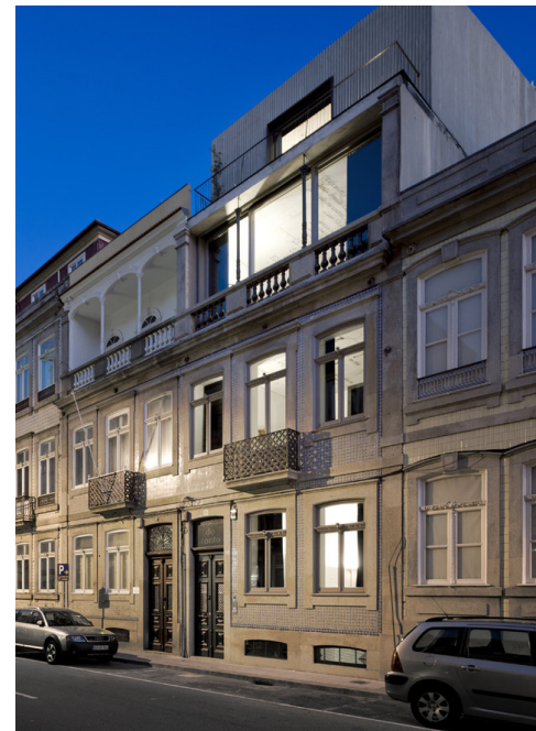
24. Fachada principal, Rua da Boavista
