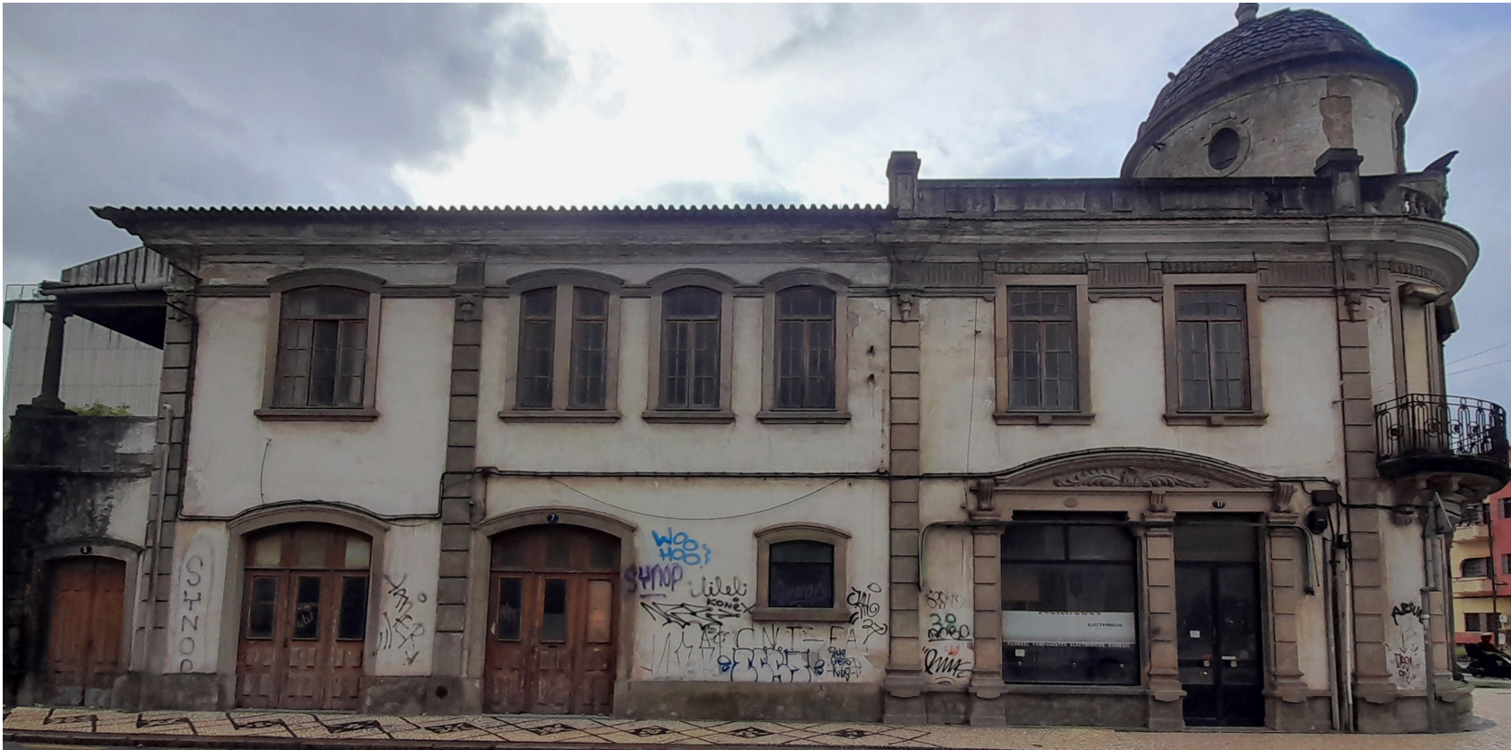
64. Fachada lateral orientada para a Rua Engenheiro Oudinot
