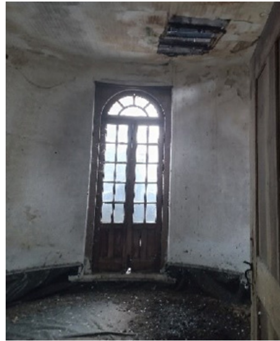
131. Porta de acesso ao exterior do torreão
