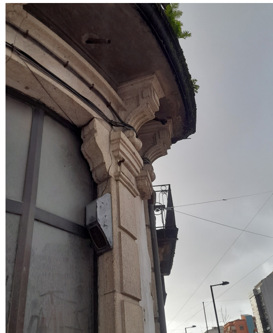
98. Granito trabalhado junto aos vãos
