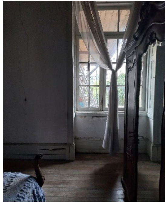
112. Vista da entrada de um dos quartos
