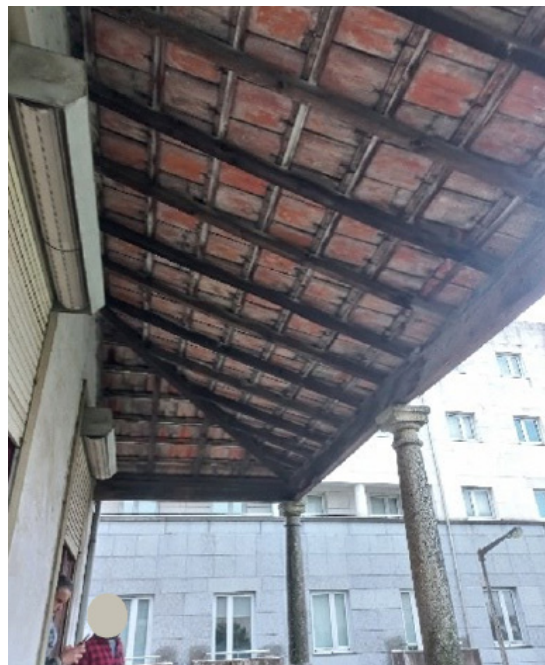
92. Telheiro da varanda da sala
