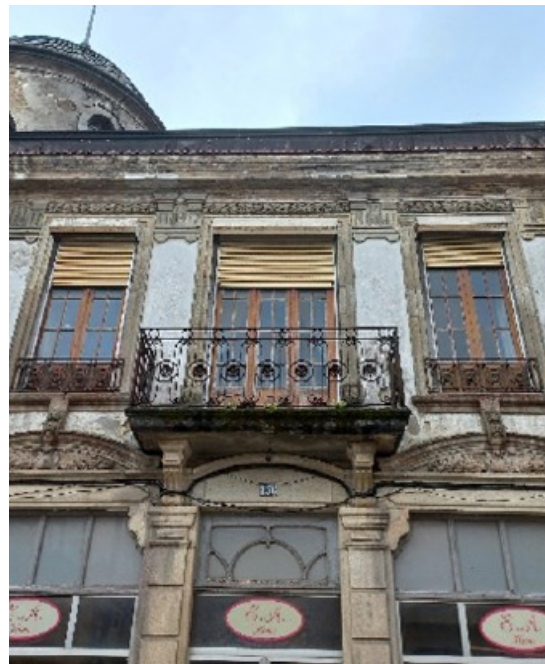
88. Platibanda da fachada principal
