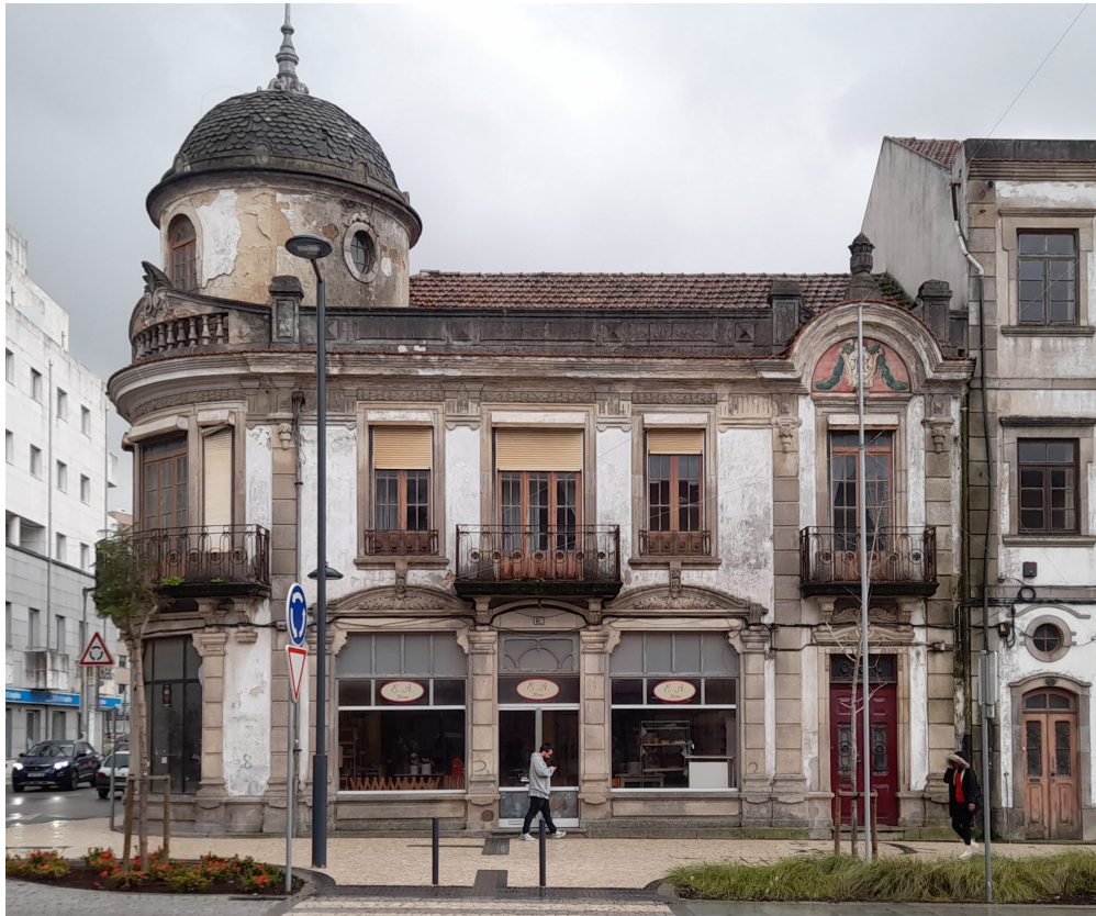
62. Fachada principal orientada para a Av. Dr. Lourenço Peixinho
