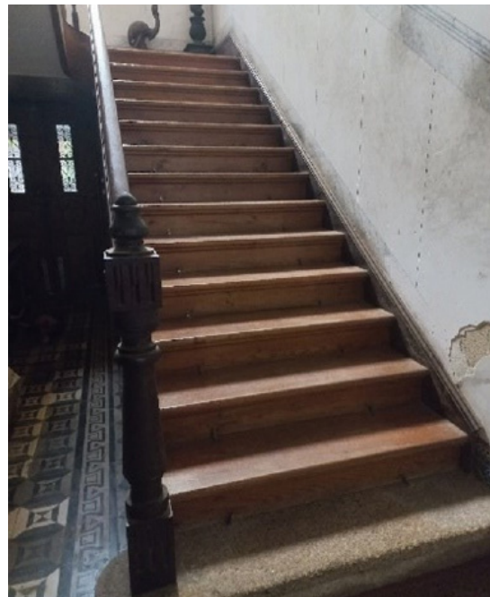
100. Arranque de escadas principais
