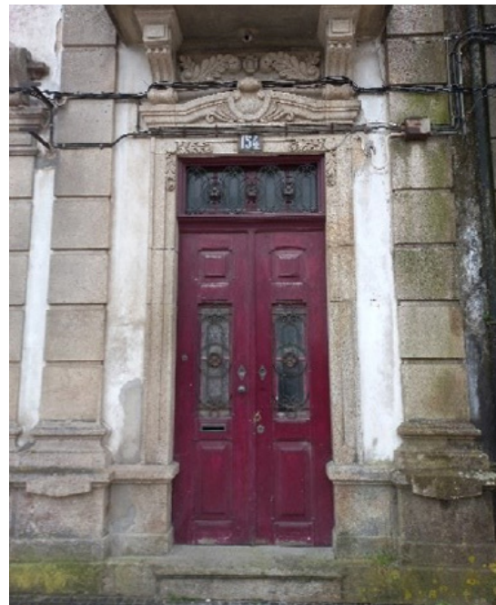
87. Porta principal de acesso à habitação
