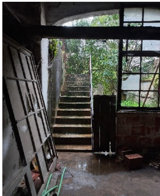
104. Traseiras com escada de acesso ao piso superior
