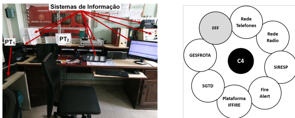
Figura 2 Vista dos Postos de Trabalho 1 e 2 e sistemas instalados (Fonte: Autor)
