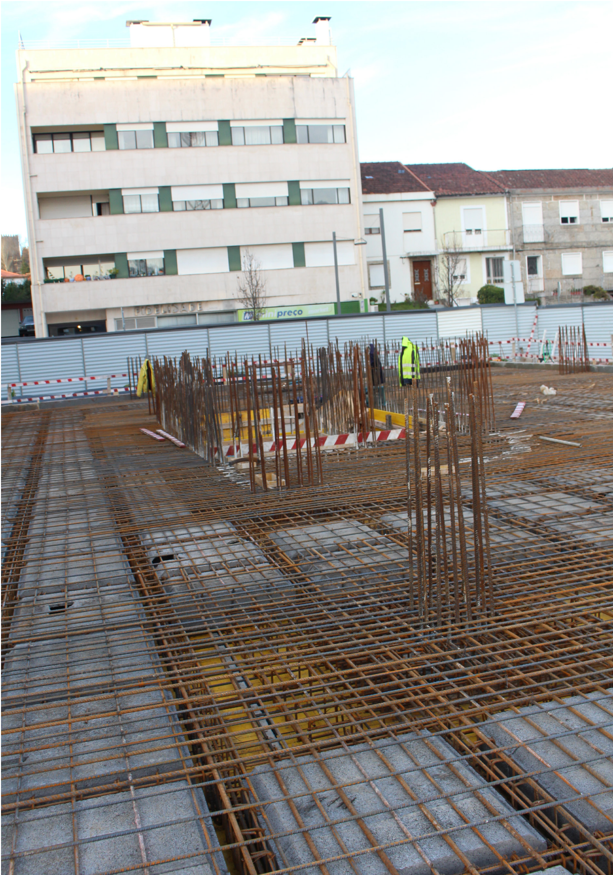
Estrutura de ferro com objetivo de reforçar o betão.
