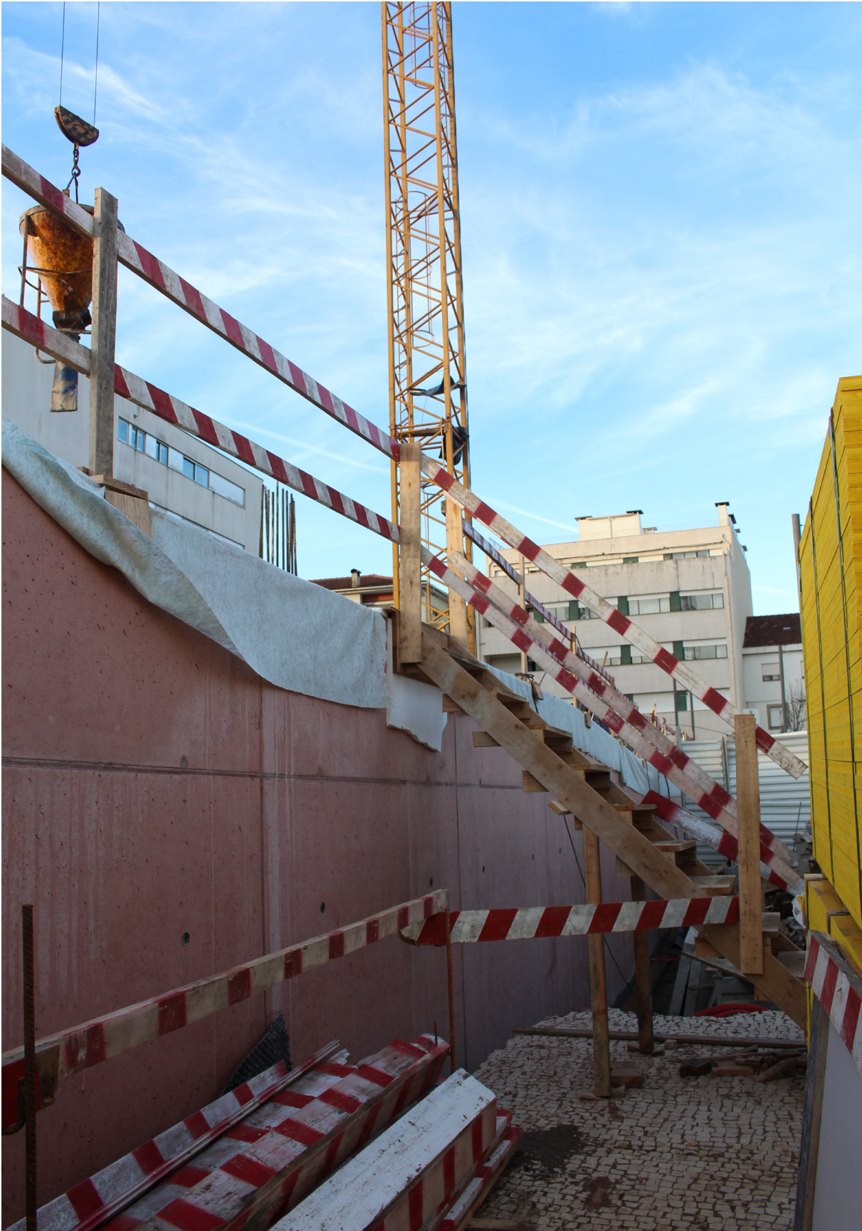
Sistema de escadas que liga um andar ao outro.
