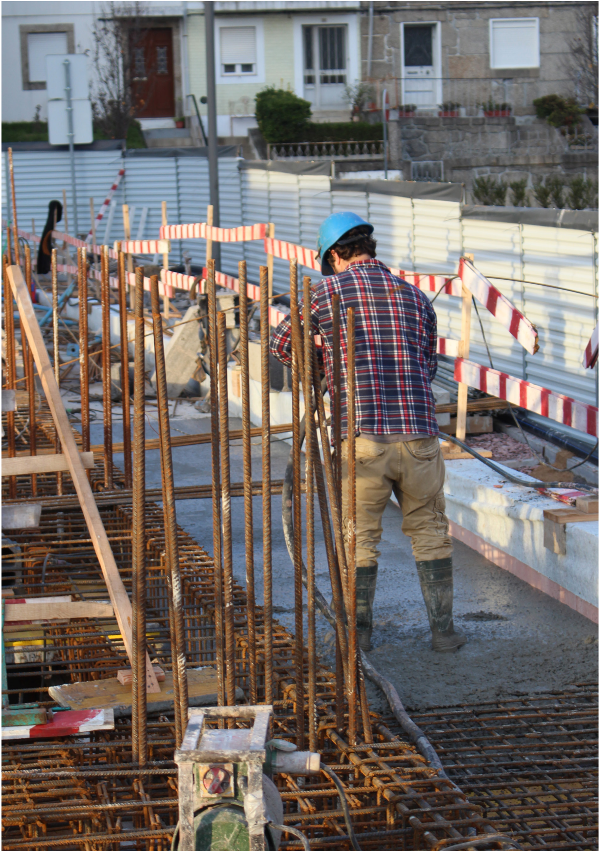
Fig. 31 Operário a encher uma laje com betão.
