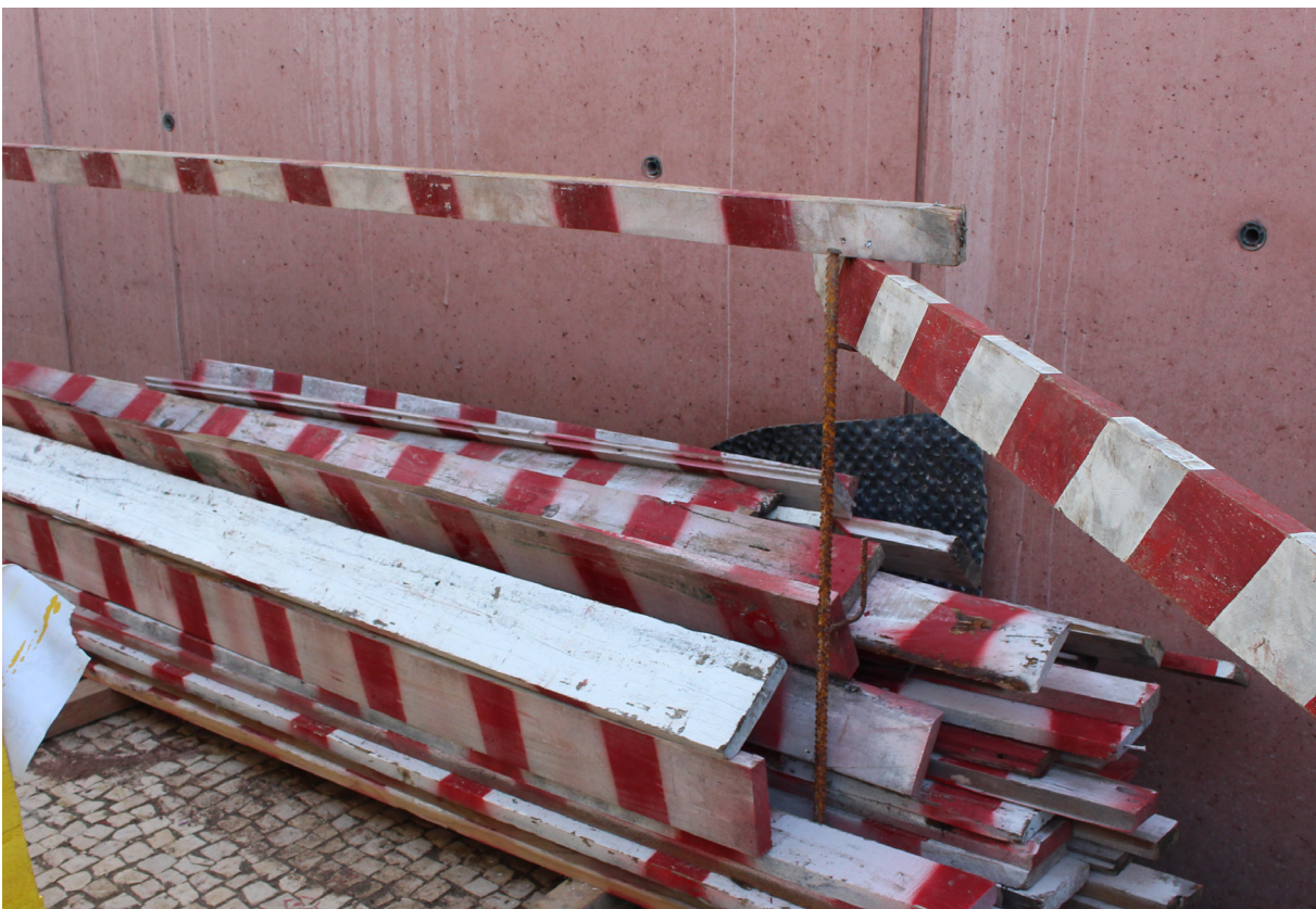
Tábuas usadas para as grades de segurança. Apresentam este padrão listado para que sejam visíveis mais facilmente.
