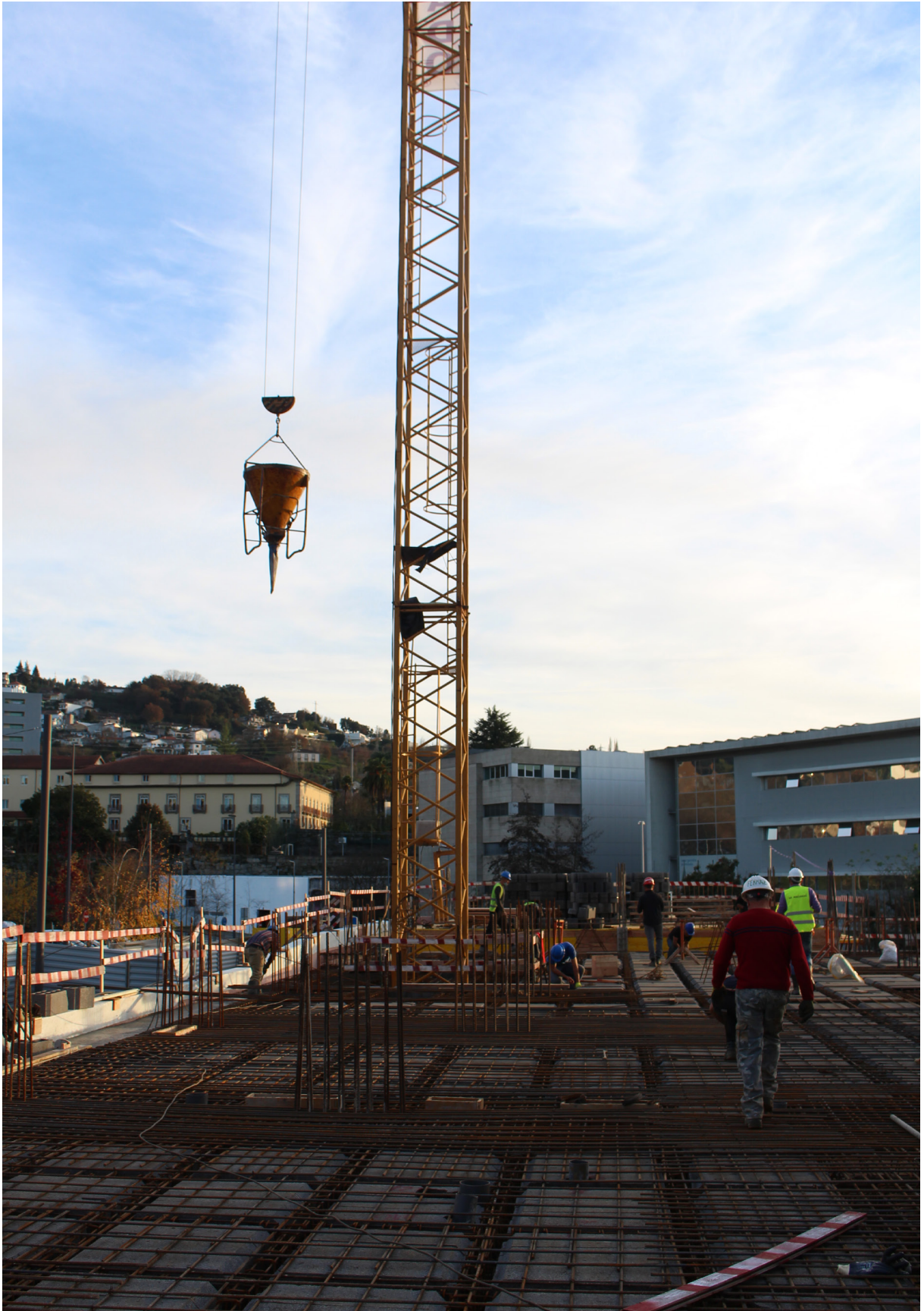
Fig. 28 Vista geral da obra.
