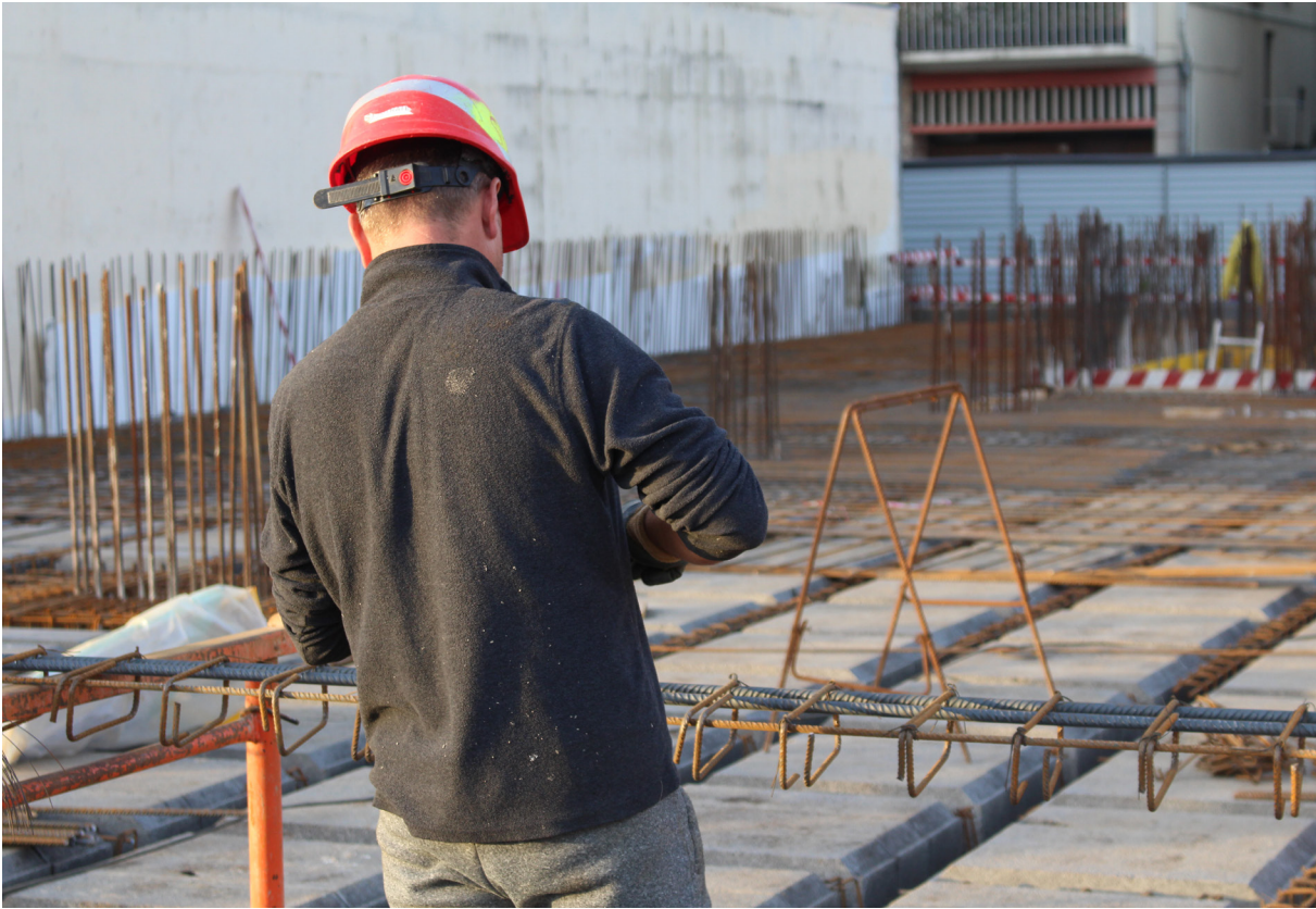
Operário a trabalhar numa estrutura de ferro.
