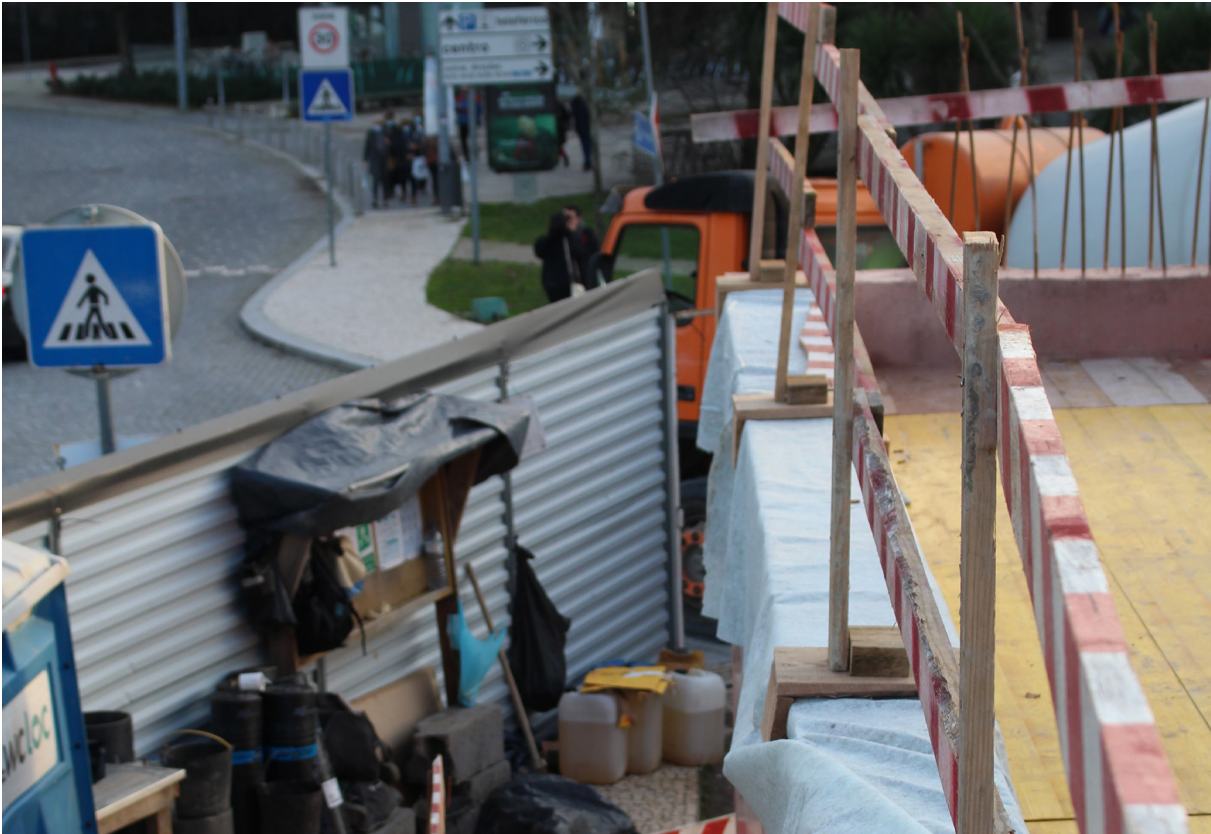
Grades de segurança. Neste caso podemos observar o seu modo de aplicação à estrutura do edifício.
