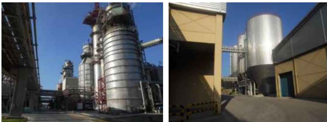
Figura 4.4 – Digestor da pasta; silos de armazenamento da pasta
