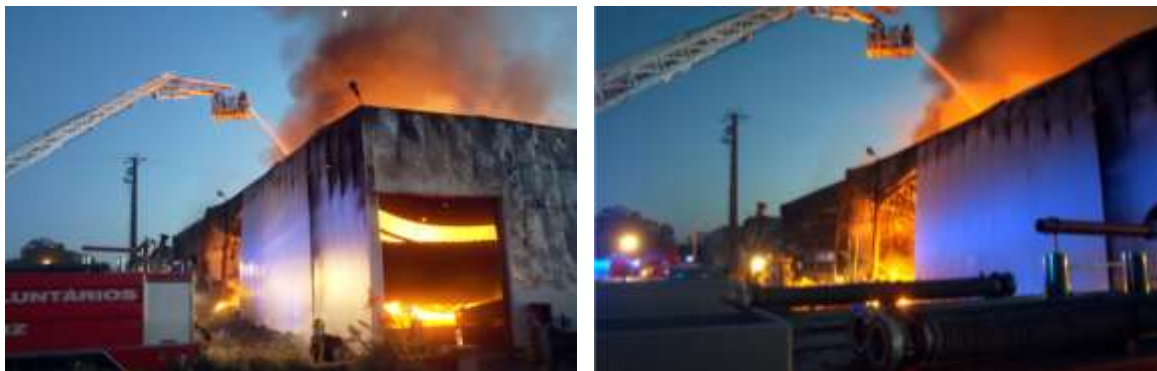
Figura 2.3 – Incêndio na Joviflex [4]
