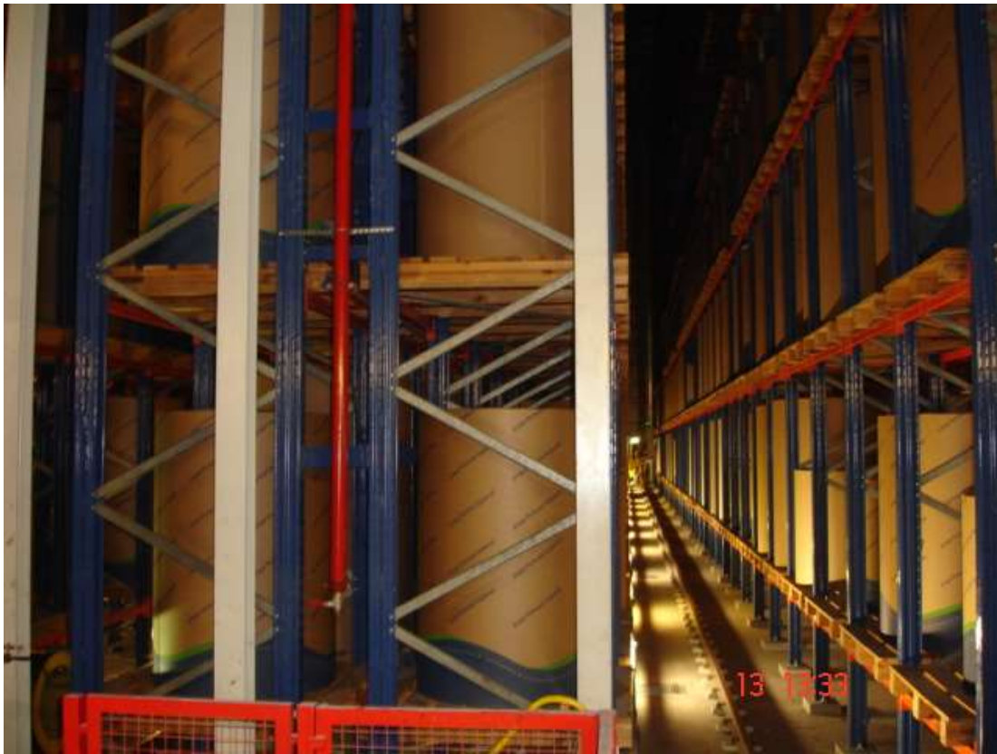
Figura A3.21 – Armazém automático PR2
