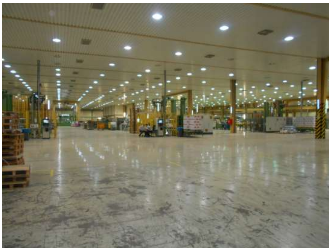
Figura A3.24 – Nave 2 da Transformação de papel
