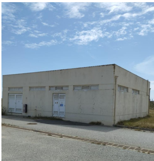
Figura 25 - Edifício da elevatória final
