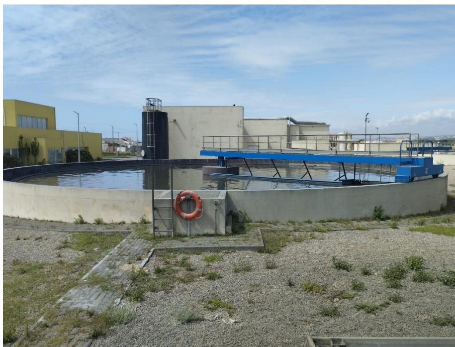
Figura 22 - Decantador primário
