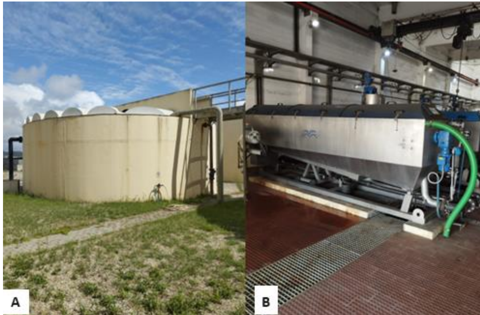
Figura 26 – (A) Espessador gravítico; (B) Mesa de espessamento
