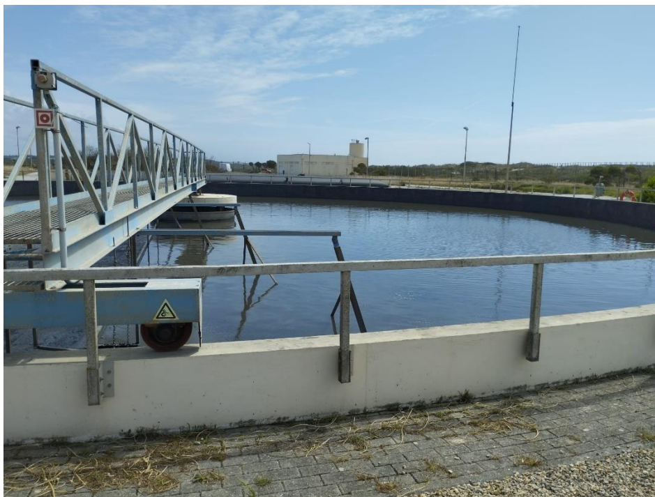
Figura 24 - Decantador secundário
